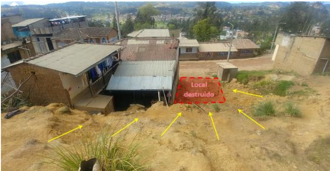
Figura 14. Se puede apreciar que el movimiento del material destruyó un local utilizado como lavadero de vehículos y está muy próximo a una vivienda, que podría ser afectada.
