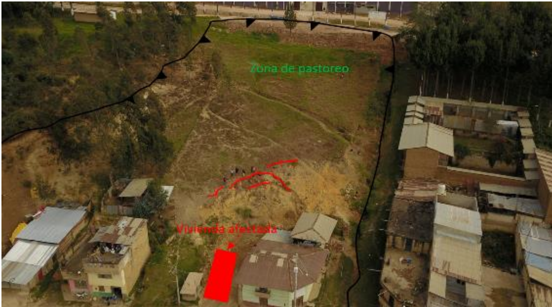
Figura 13. Puede observarse el área de pastoreo afectada por el deslizamiento, presentando grietas que pueden afectar a las personas y animales que transiten por el sector.
