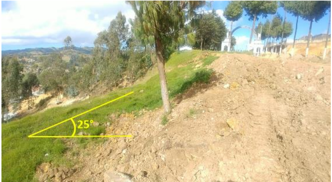
Figura 5. Pendiente promedio del sector evaluado es de 25^\circ , ladera al noroeste del deslizamiento.
