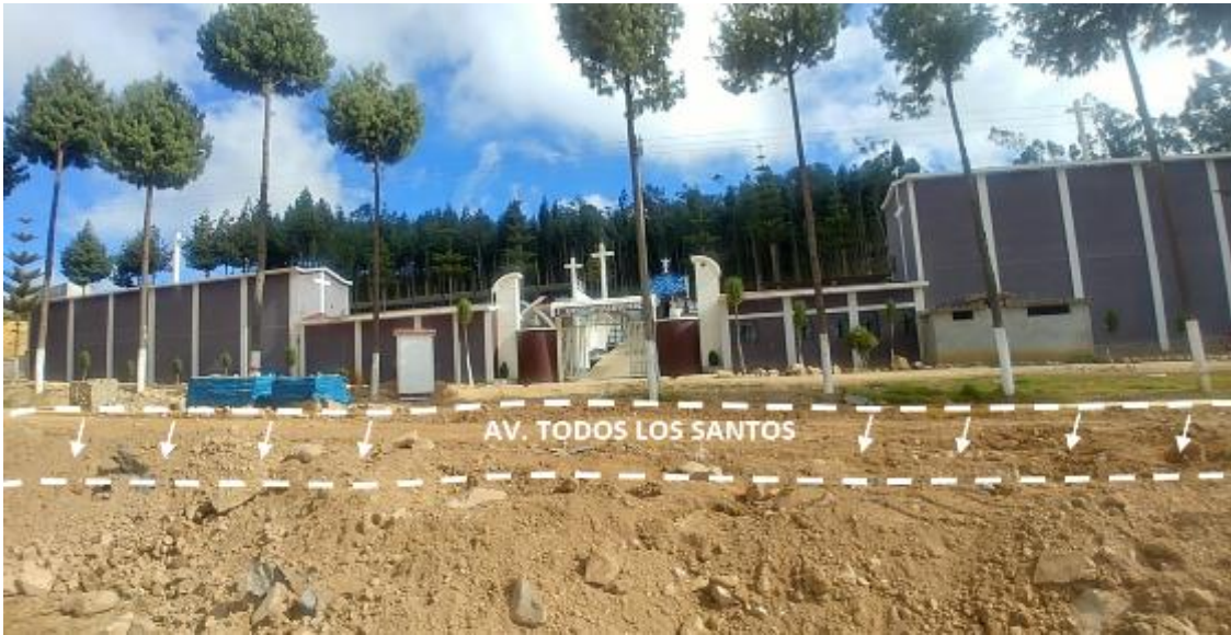
Figura 12. Avenida Todos Los Santos, afectado por el escarpe principal del deslizamiento reactivado, vía actualmente rellenada para la circulación de vehículos.
