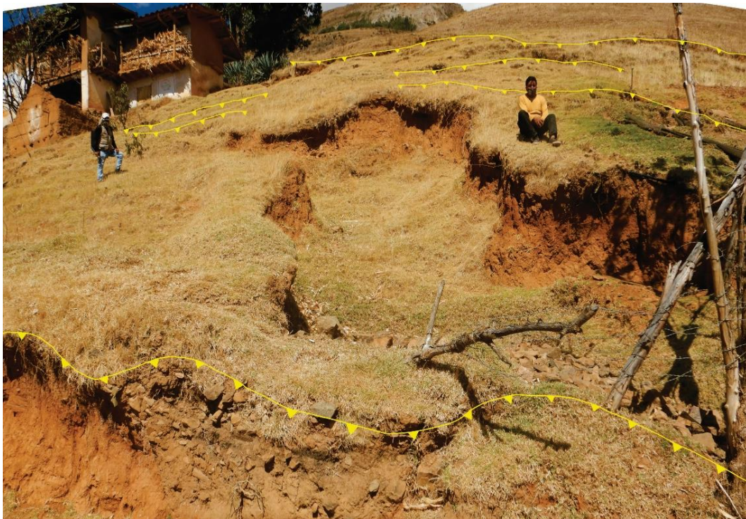
Figura 17. Se observa saltos continuos con longitudes de hasta 4.5 m, la cuales se encuentran en la margen izquierda de la vivienda destruida; la misma que se ubican en las coordenadas UTM 9021164 N, 264309 E a una altitud de 3073 m s.n.m.
