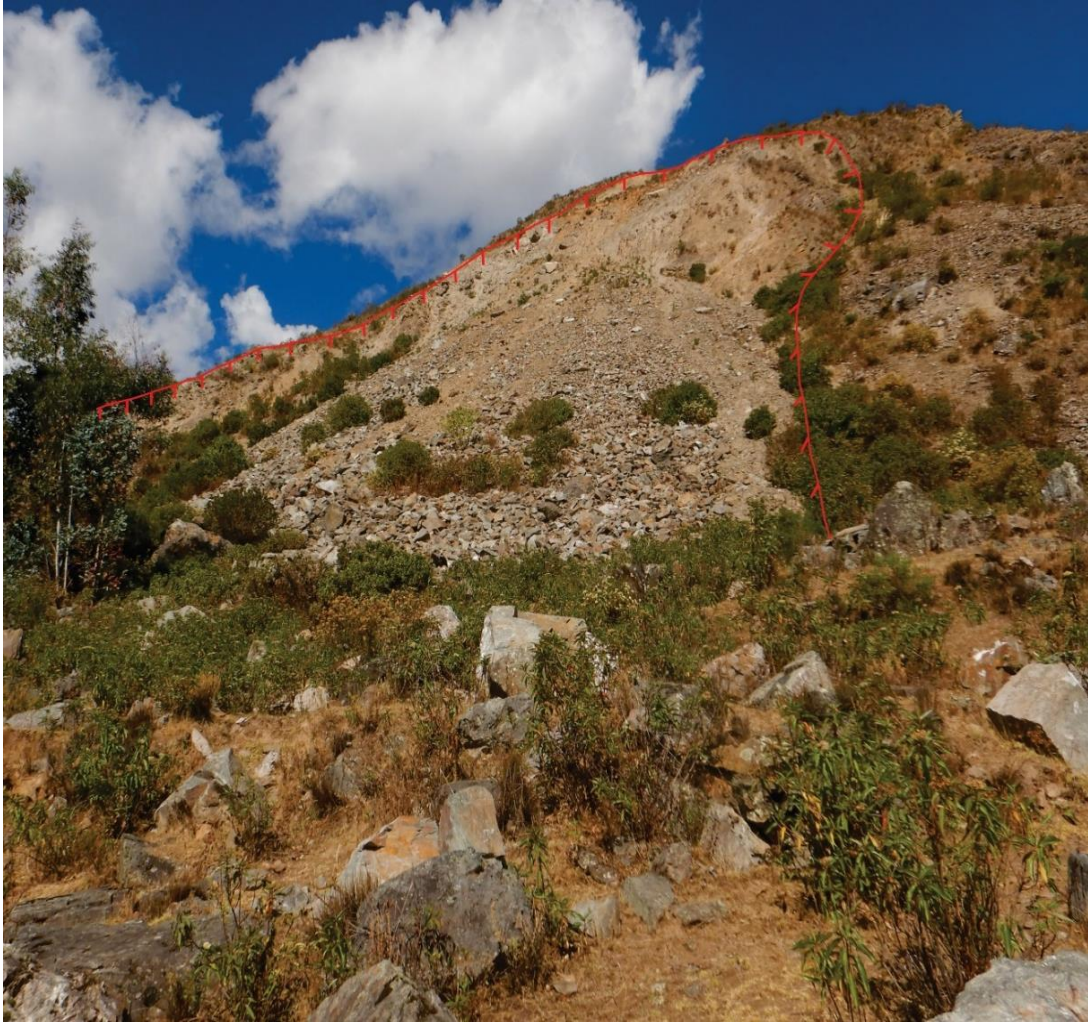
Figura 11. Vista del derrumbe, ubicado al este del sector Pauca. Desde este punto rodó un bloque de roca que generó el colapso de una vivienda.
