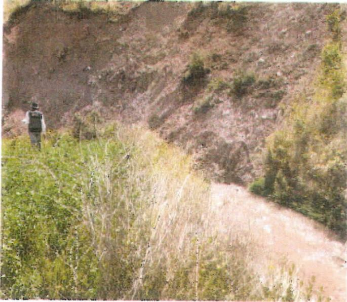
FIGURA N°02: POSIBLE EMBALSAMIENTO DEL RIO HATUNMAYO POR DERRUMBE DE TALUD EN LA MARGEN DERECHA DEL RIO.
