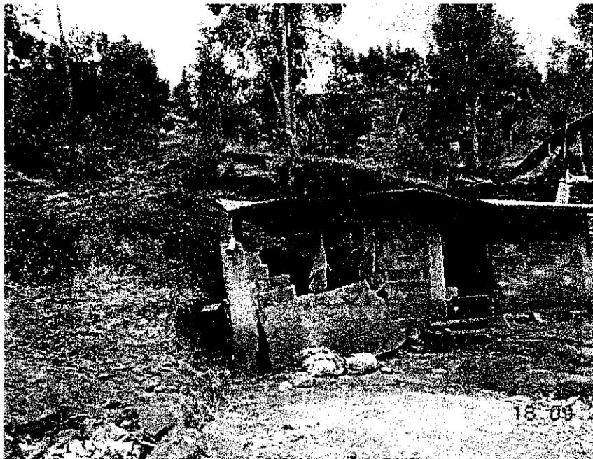
**Fotografía 7.** Vivienda colapsada producto de la reactivación de la ladera noreste del cerro Roquellocata en derrumbe.
