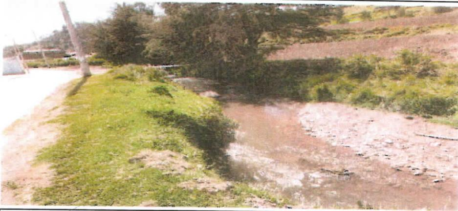
FIGURA N°02: VIA ASFALTADO EN RIESGO POR CRECIDA DEL RIO HATUNMAYO
