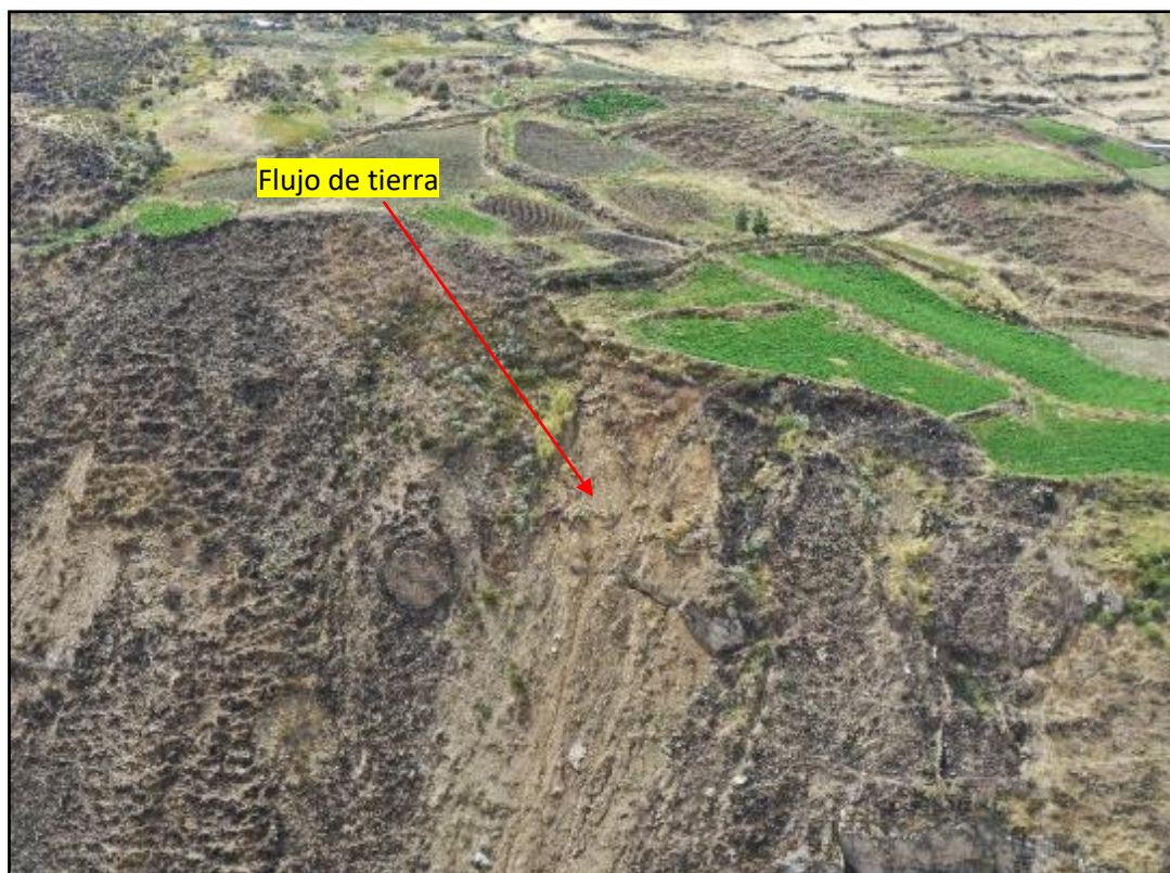
Figura 6. Flujo de tierra en el sector Pachamalqui (coordenadas UTM WGS84 223308E, 8273977N).
