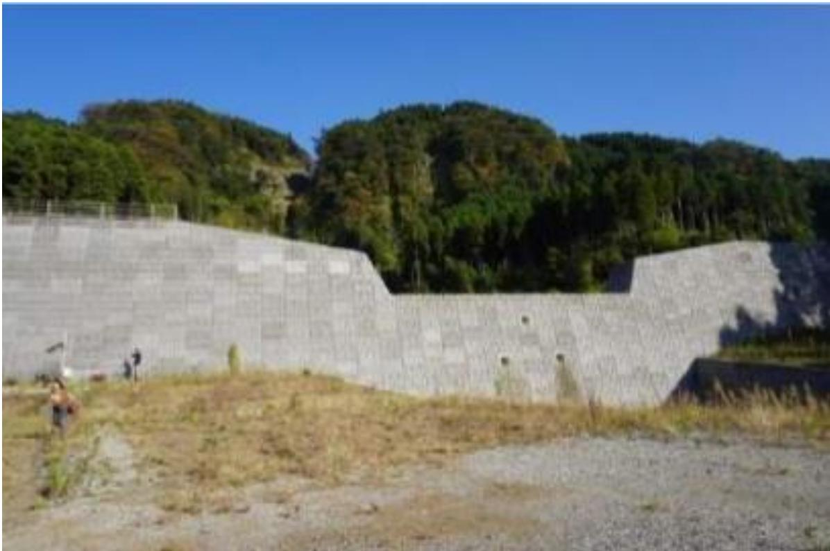
**Figura 30.** Represa SABO para el control de flujos de detritos en Minami-Aso Village (Kumamoto). Nótese el gran tamaño de la misma (Foto: S. Villacorta, 2015).
