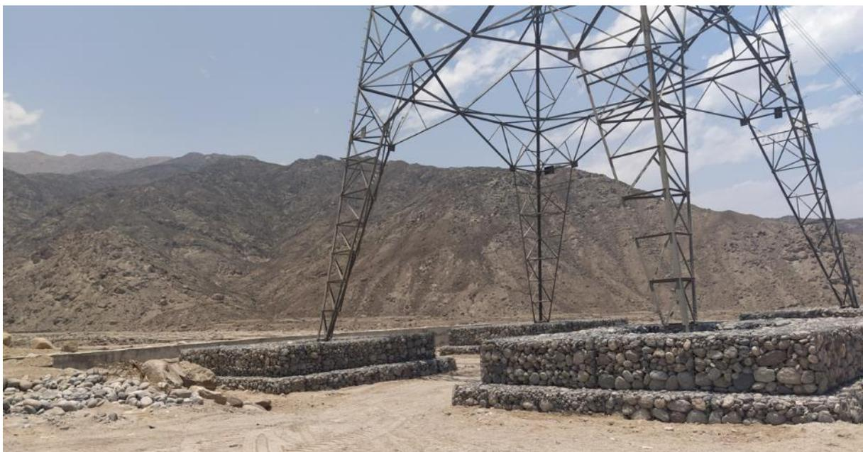
**Fotografía 1.** Torre de alta tensión instalada en la quebrada Huarequeque, protegida por muros de gaviones (Coordenadas UTM, WGS 84, zona 18 s, X: 265811; Y: 8739926).
