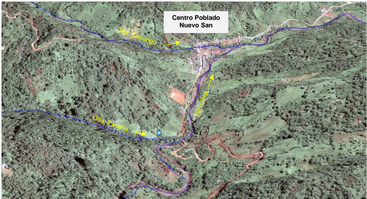
Figura 5. El centro poblado Nuevo San Miguel se encuentra asentado sobre la margen izquierda del río Gera, sobre terrazas aluviales formadas por la confluencia de este con la quebrada Sanango.
