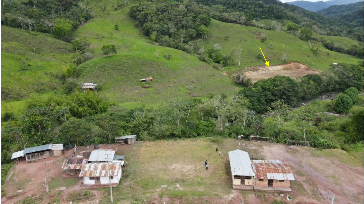
Figura 26. Excavación de base de laderas. Estas acciones pueden generar deslizamientos de suelos.
