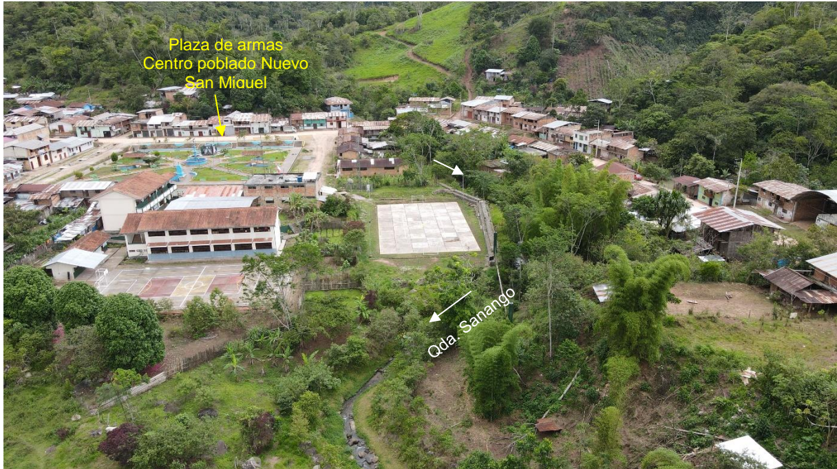
Figura 24. Vista del tramo final de la quebrada Sanango, donde ambas riberas están ocupadas por viviendas.
