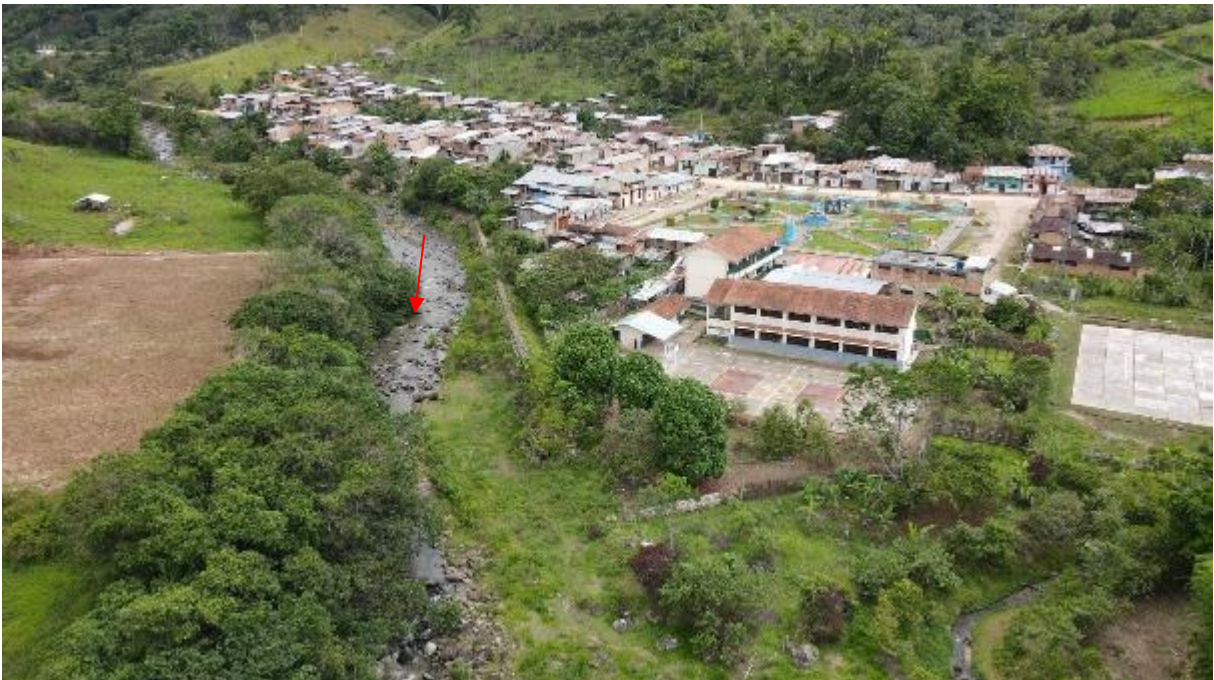
Figura 20. Depósitos fluviales en el cauce del río Gera.
