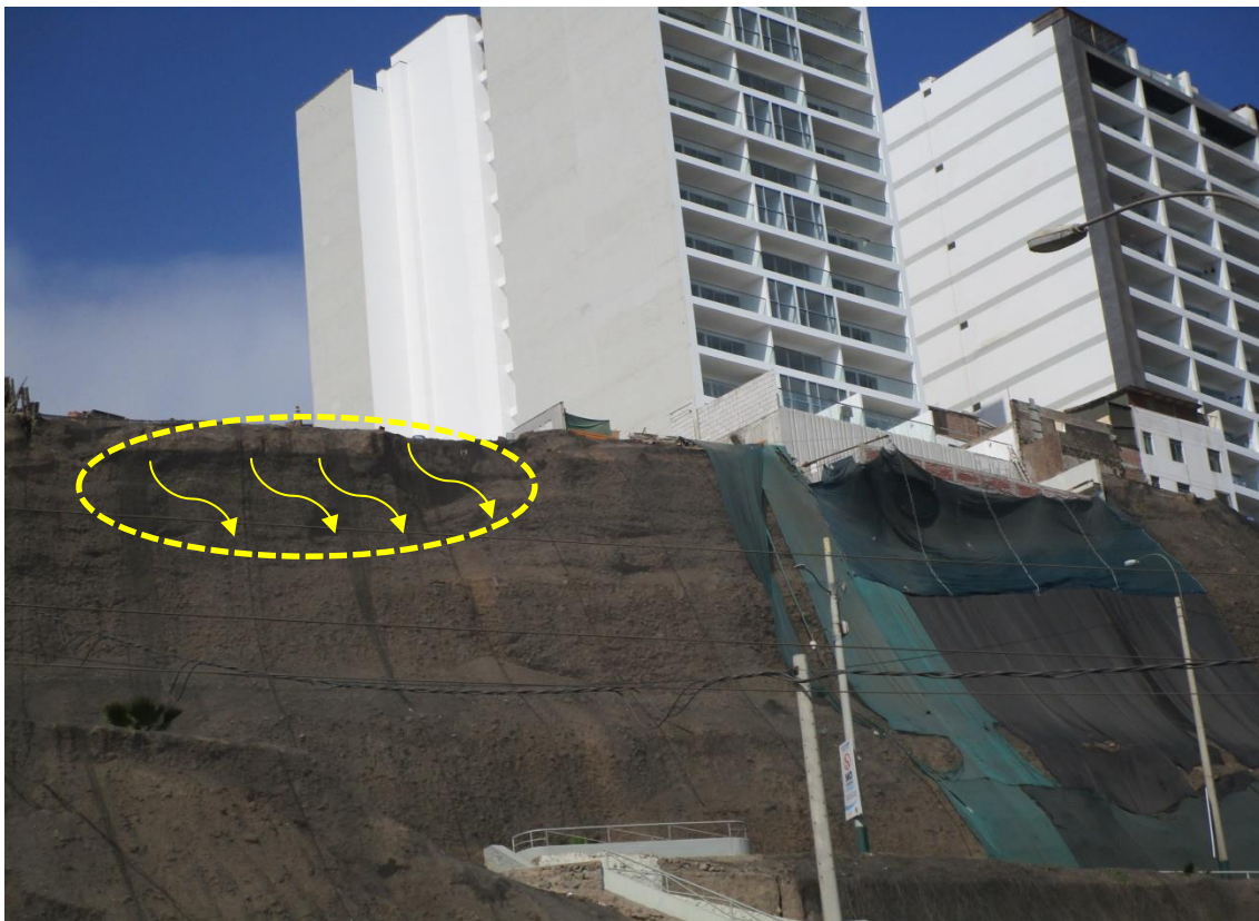
Figura 44. ... Continuación.../. Imágenes de erosión en la parte alta del talud y sobre el cual se asientan edificaciones, próximo al Malecón Castagnola y de la oficina de seguridad ciudadana.
