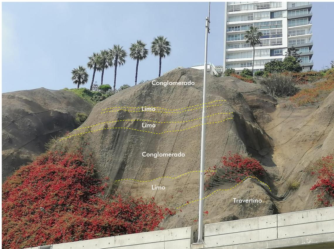
Figura 4: a) Vista de la estratigrafía de los ACV en el distrito de Miraflores. Depósito aluvial, gravas sub redondeadas con intercalaciones de lentes de limos y travertinos en la parte inferior del talud.
