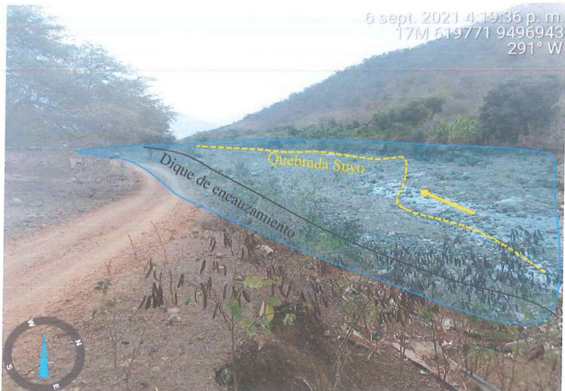
Figura 17.- Zona inundable (polígono celeste) por desborde de las aguas de la quebrada Suyo en las inmediaciones del poblado Zapallal
