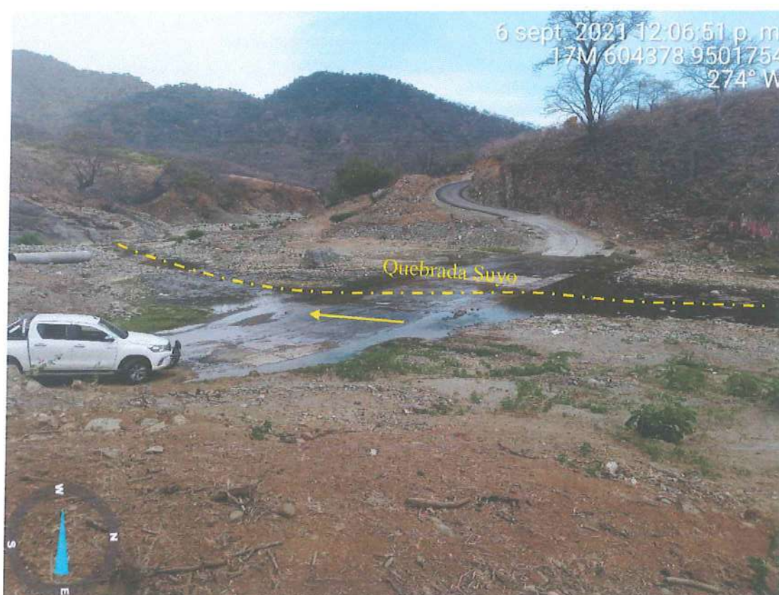
Figura 8.- Quebrada Suyo en las inmediaciones de la vía Puente Quiroz – La Monja. Debido a la presencia continua de agua durante todo el año, dificulta el acceso.
