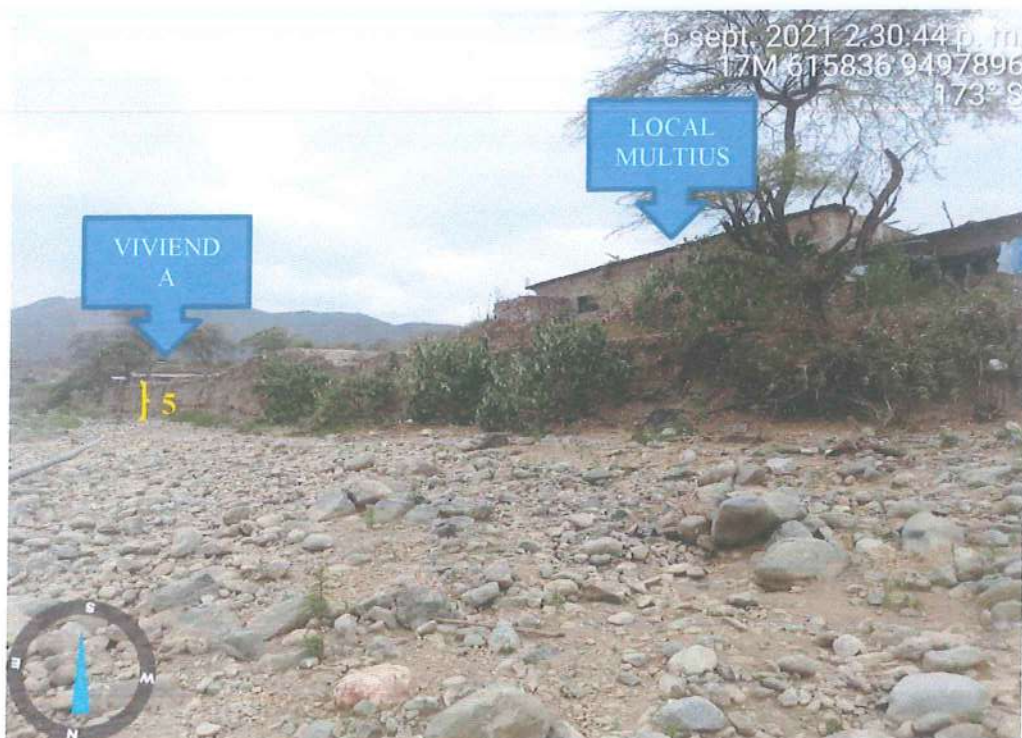
Figura 10.- Erosión fluvial en la terraza aluvial que se ubica en el margen izquierdo de la quebrada Suyo. Terraza conformada por materiales limo-arcillosos que tienen un desnivel topográfico de 5m respecto al cauce de la quebrada
