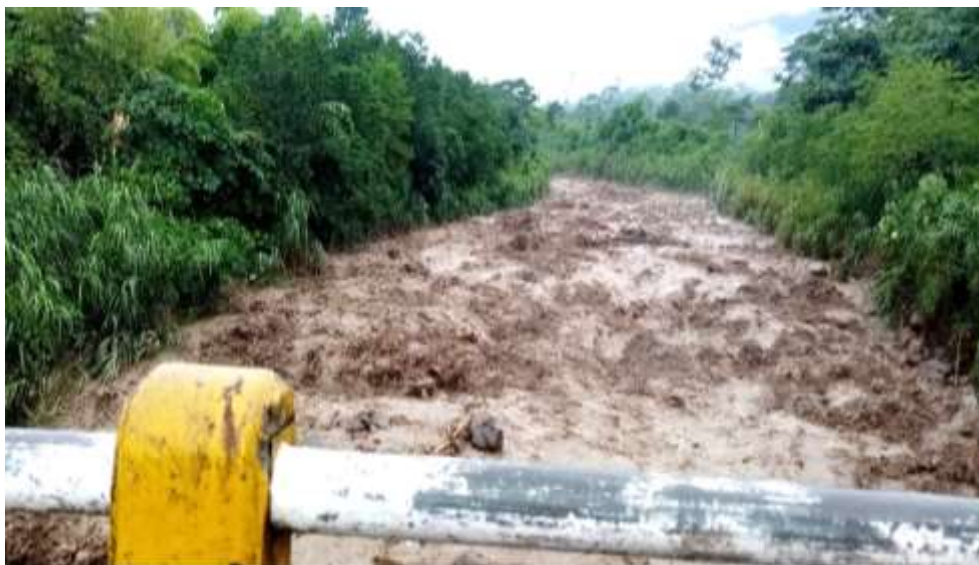
Fotografía 23: Vista del flujo de detritos que sobrepasó el puente de Otari, ampliando su cauce y desbordando hacia la comunidad de Otari Nativos, fotografía tomada en abril de 2021. INDECI_PICHARI 2021
