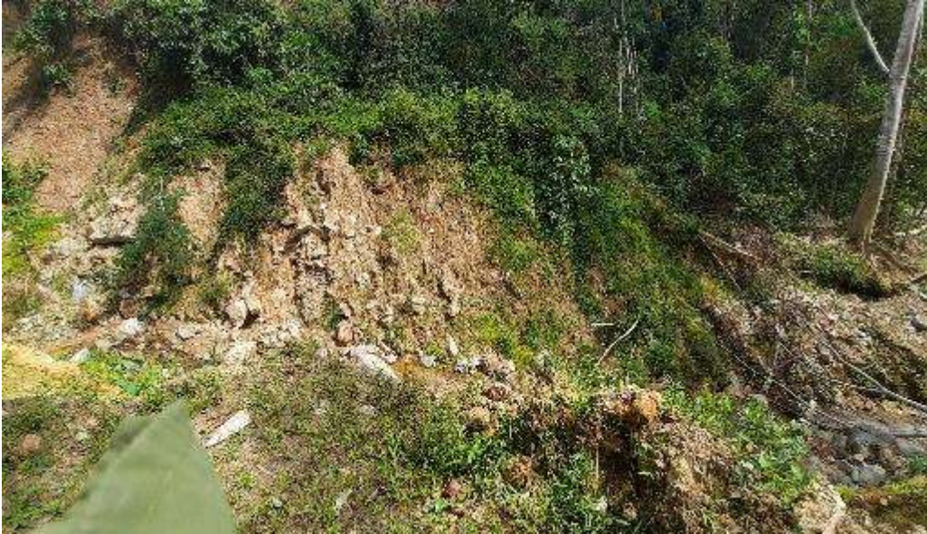
Fotografía 22: Presencia de derrumbes en el flanco izquierdo del río Shankirwato
