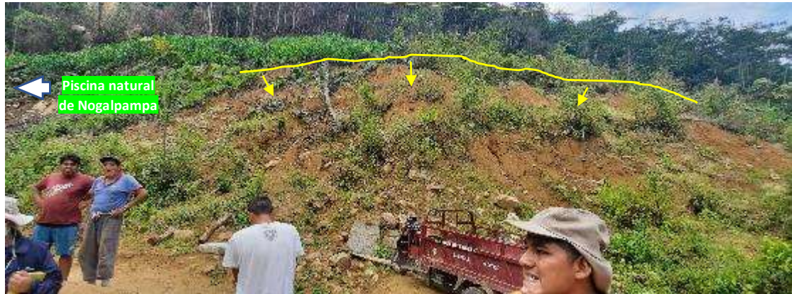
Fotografía 13. Derrumbes re-activados en el lado izquierdo de la piscina natural de Nogalpampa, en el camino que lleva a piscina natural de Nogalpampa
