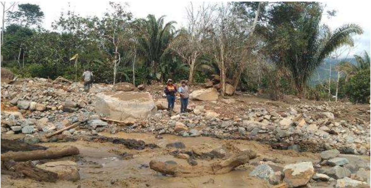
Fotografía 19: Flujo de detritos en el sector de Shankirwato, destrucción de terrenos de cultivos, carretera afirmada y baden. INDECI-Pichari, 2021
