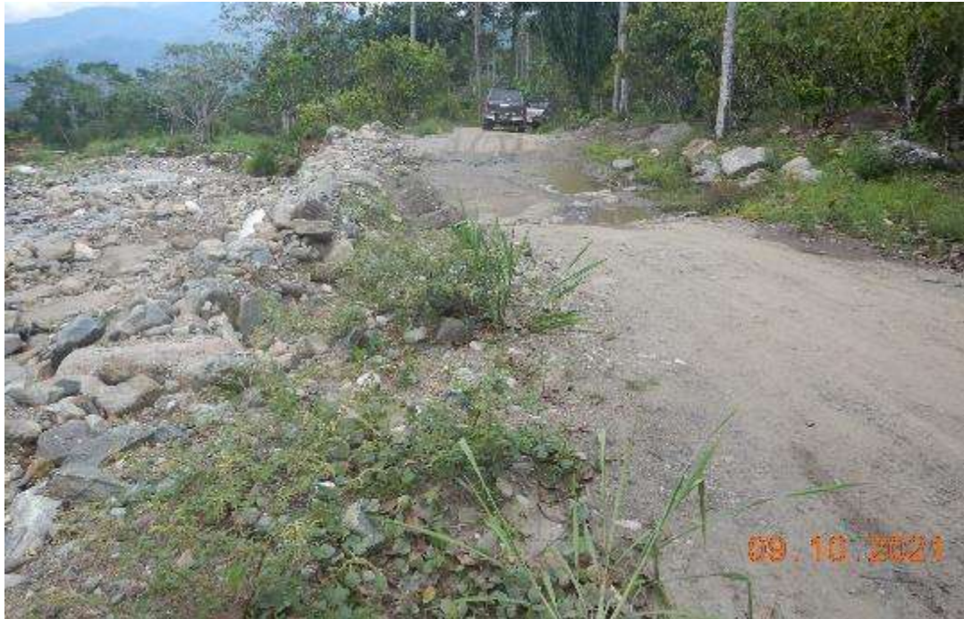
Fotografía 17. Carretera rehabilitada para habilitar el tránsito vehicular
