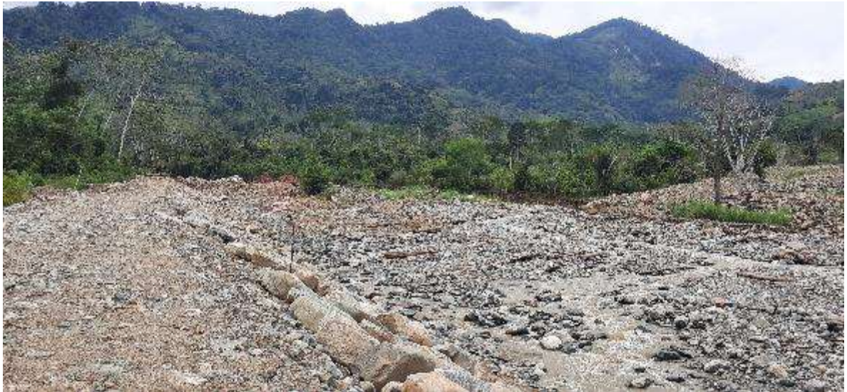
Fotografía 16. Descolmatación y construcción de diques a la altura de la comunidad de Nogalpampa en el flanco derecho del río Periaventina y vista de la confluencia del flujo de detritos generado en el río Shankirwato hasta el río Periaventina
