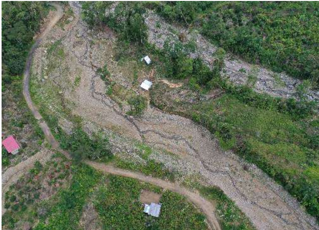
Fotografía 9: Vista aérea de la vertiente aluvio-torrencial en el sector de Nogalpampa Alta. Las lluvias excepcionales en abril de 2021 provocaron un flujo de detritos que ensanchó el cauce del río Agua Virgen, Periaventina y Otari, destruyendo terrenos de cultivo a su paso.
