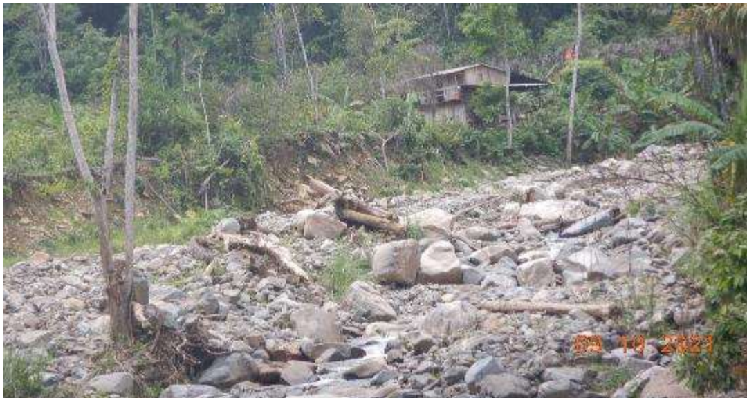
Fotografía 15. Vista del flujo de detritos y vivienda al límite del flanco derecho del río Periaventina
