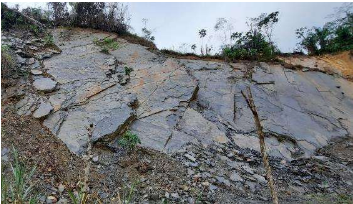
Fotografía 2: Pizarras en capas delgadas con laminación paralela, fuertemente fracturada y patinas de Fe por oxidación.
