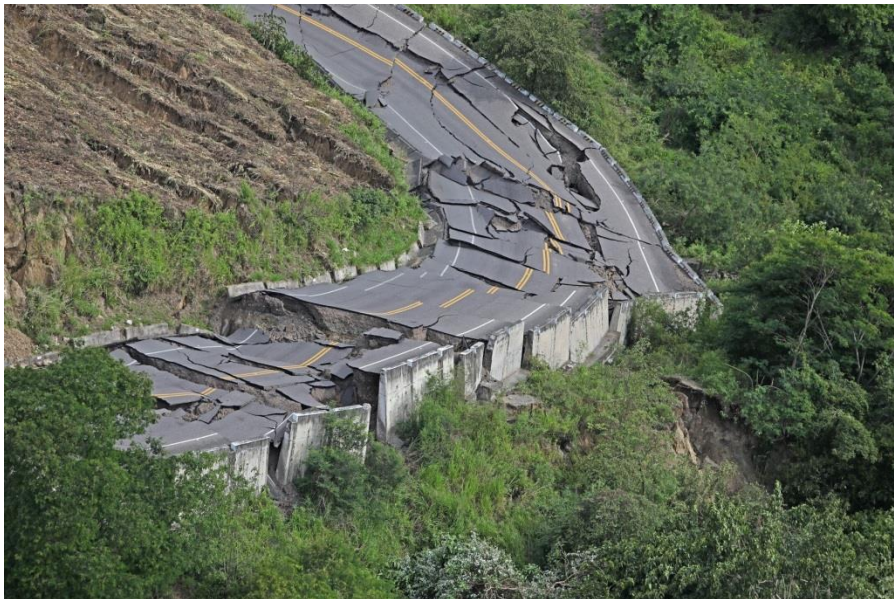
Figura 9: Licuación de suelos en carretera Bagua Grande y Pedro Ruiz (Fuente ANDINA/Prensa)
