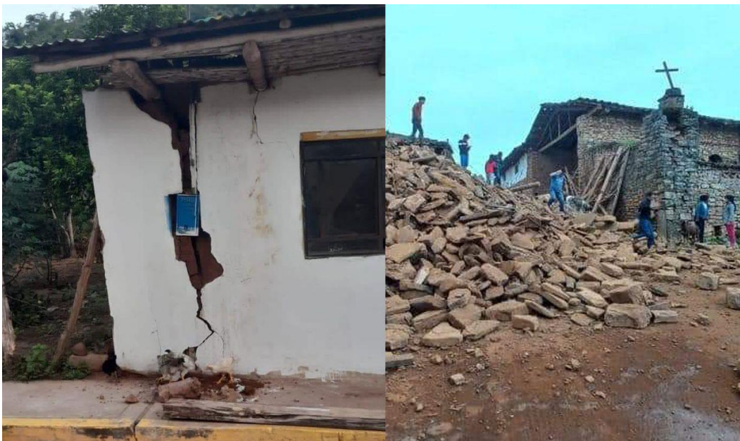
Figura 7: Vivienda de adobe en Yurimaguas dañada por el sismo del Datem del Marañón (fuente Composición LR)
