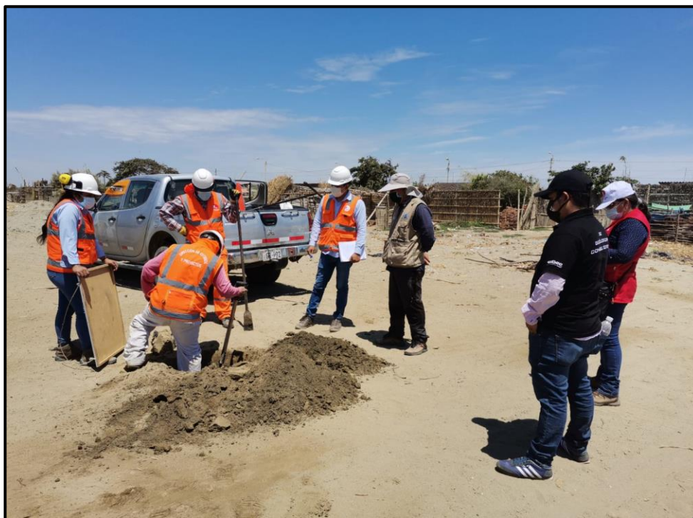
SE HA REALIZADO ESTUDIOS DE SUELOS CON FINES DE CIMENTACION - DIRECCION DE ESTUDIOS Y PROYECTOS - LABORATORIO MECANICA DE SUELOS -GRP
