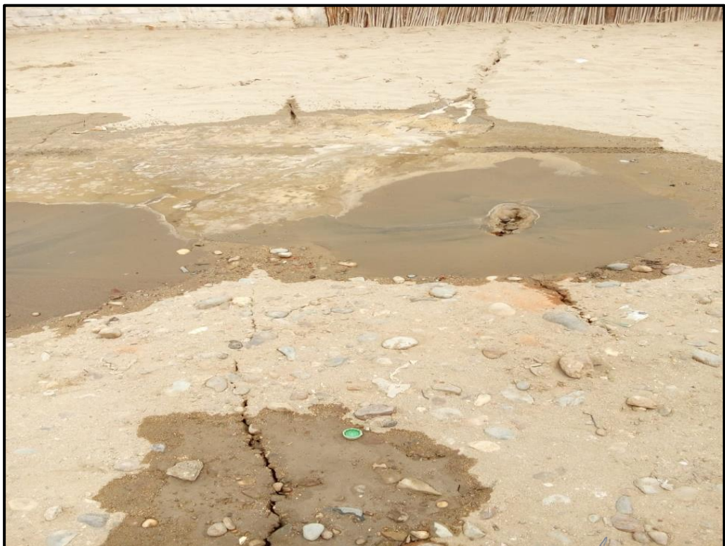
GRIETAS EN EL SUELO PRODUCIDO POSTERIOR A LA OCURRENCIA DEL SISM
