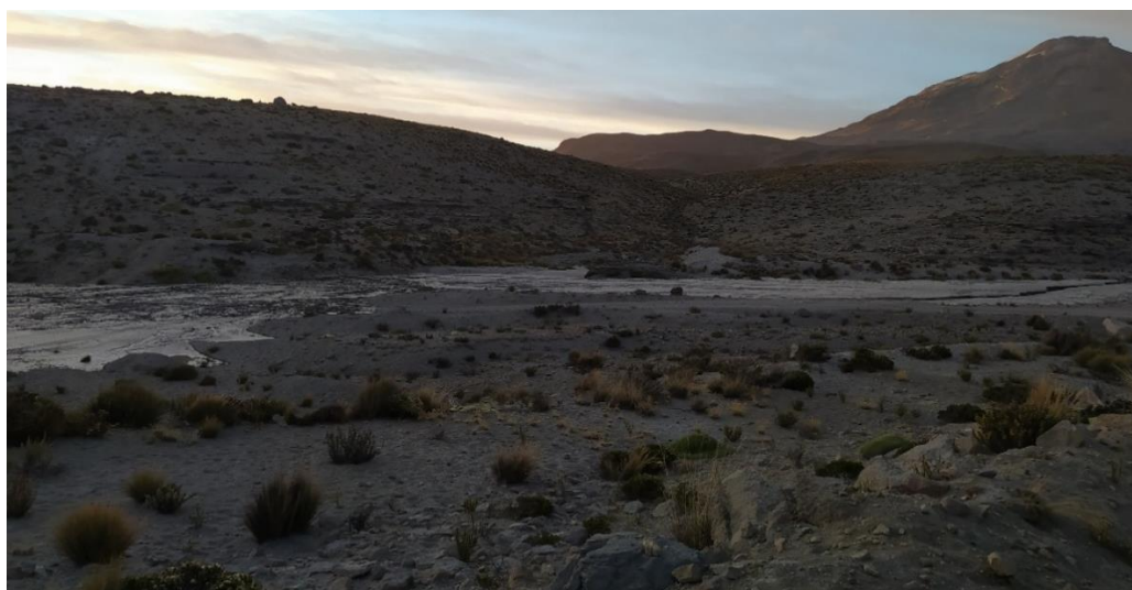
Figura 27: Flujo de lahar quebrada Cabana Pujio, afectando la vía Taya-Patapampa-Chivay.
