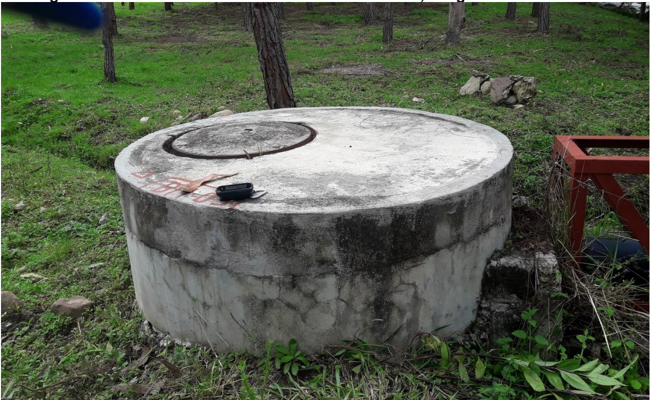
Fotografía 18: Buzón de la red de alcantarillado sanitario, margen derecho del río Olia
