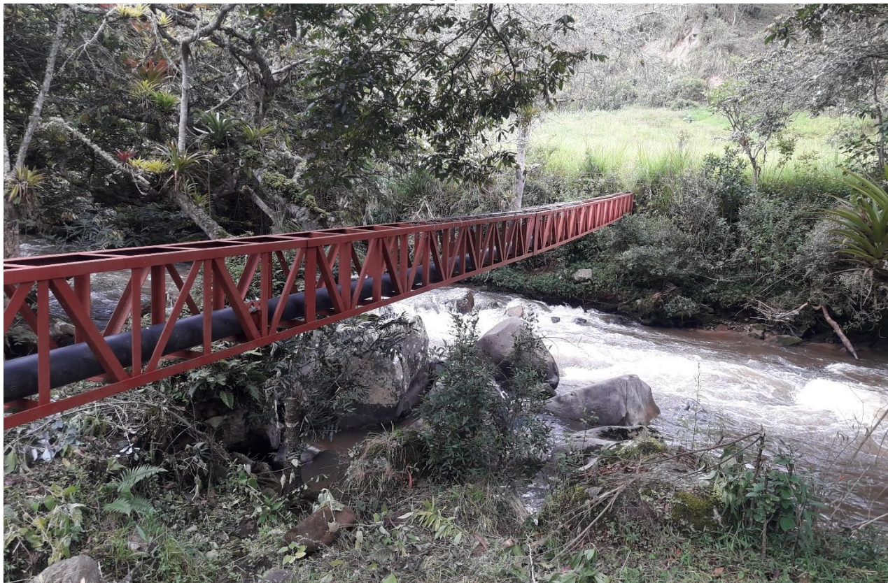
Fotografía 19: Pase aéreo que conduce la tubería de la red de alcantarillado sobre el río Olia
