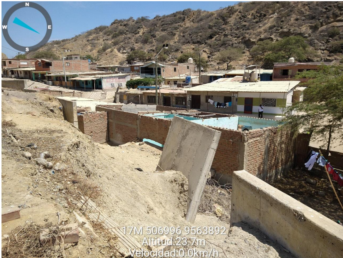
Figura 8.- Muros colapsados que afectaron viviendas ubicadas en la parte baja de la quebrada.
