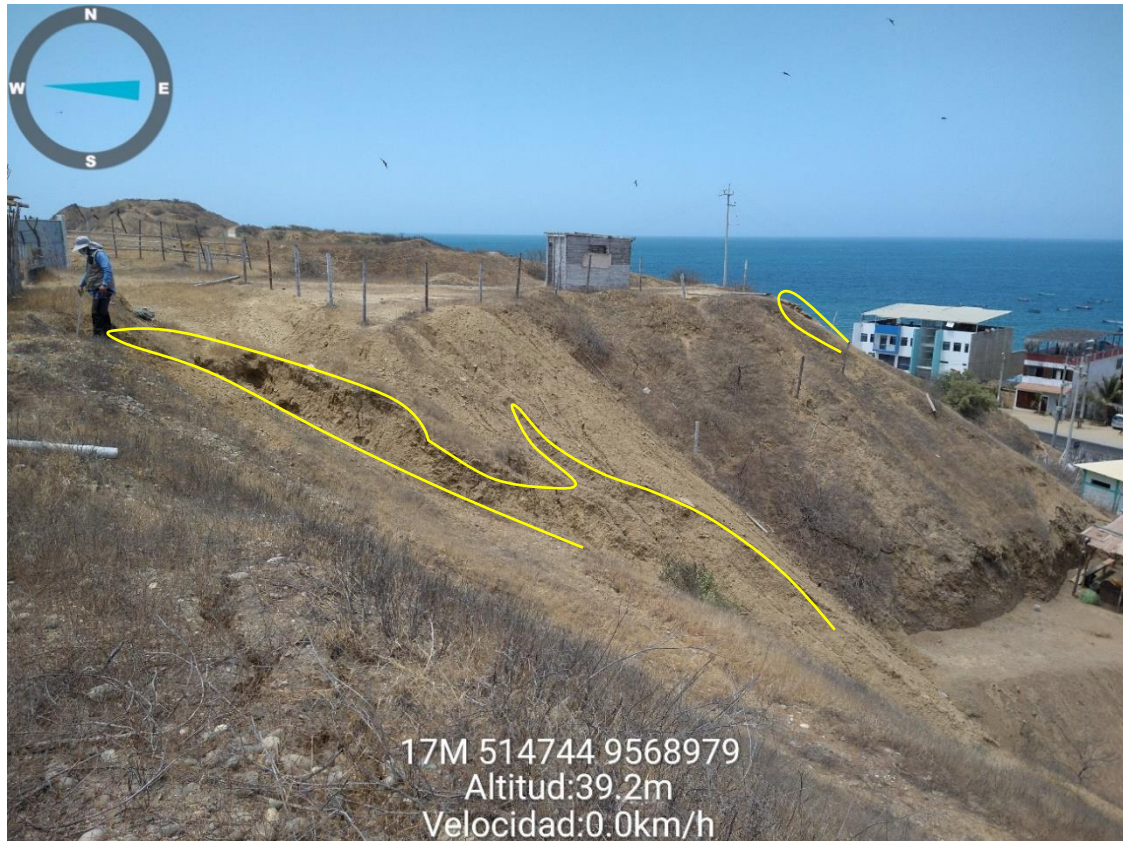
Figura 3.- Cárcavas (líneas amarillas) generadas producto de la erosión de laderas que se ubican en la parte baja del reservorio de agua del sector Punta Mero
