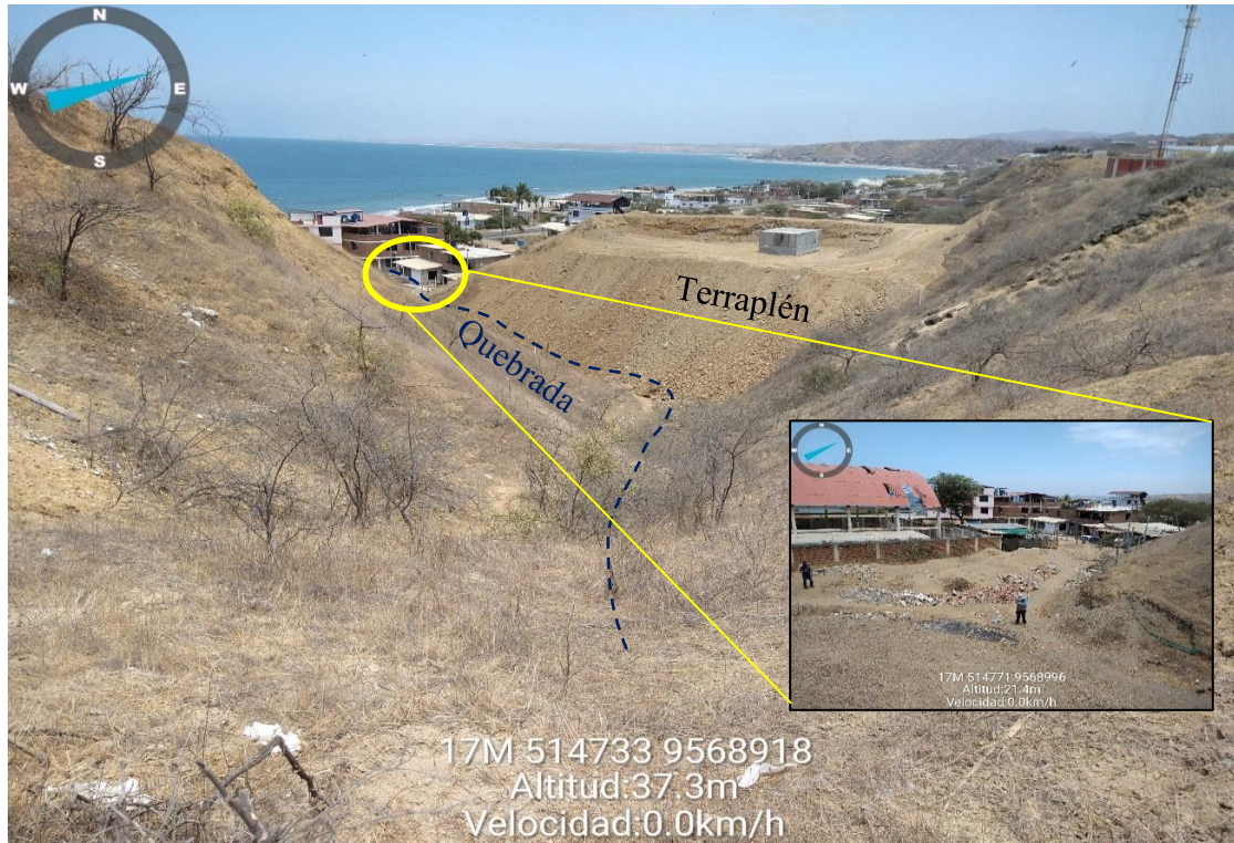
Figura 4.- Quebrada ubicada al lado derecho de IE inicial – primaria N° 123 del sector Punta Mero que se activa y genera flujos en épocas de precipitaciones intensas, en la parte media se observa terraplén que es susceptible a erosionarse por el flujo de agua y trasladar los materiales con dirección pendiente abajo
