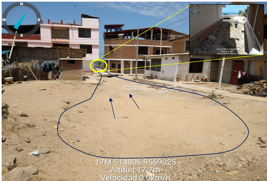
Figura 5.- Recorrido del flujo de detritos contiguo a viviendas que durante el año 2017 fueron afectadas
