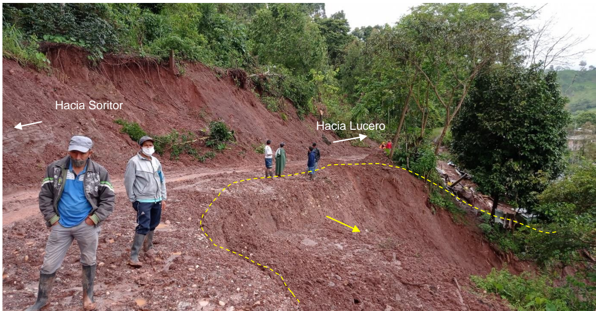
Figura 14. Zona de arranque del deslizamiento flujo de lodo N°1.
