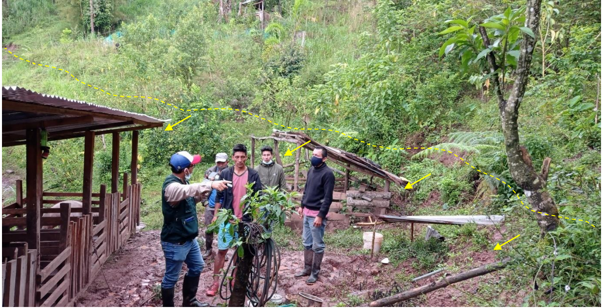
Figura 22. Masa inestable suspendida en la ladera, propensa a moverse ladera abajo.
