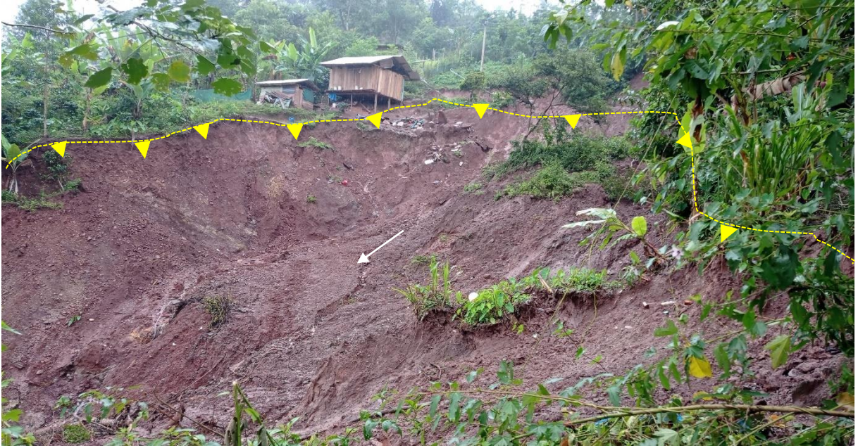
Figura 17. Vista hacia arriba de la zona de arranque del deslizamiento flujo de lodo N°1.
