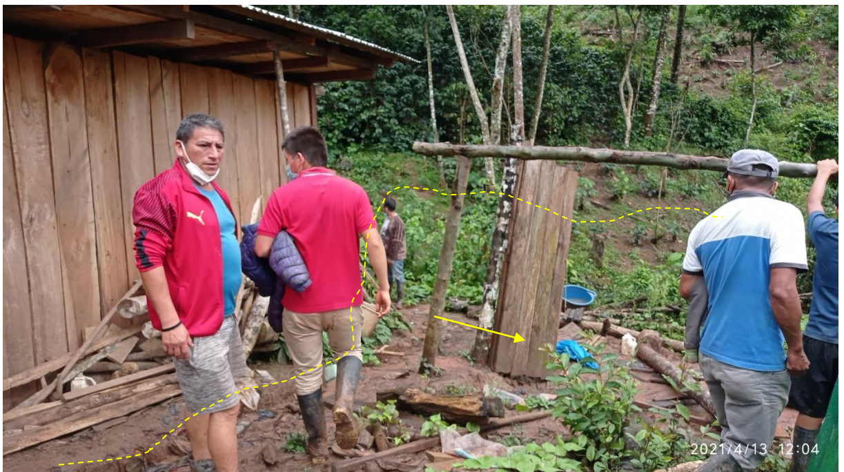
Figura 27. Arcillas saturadas movilizadas por el evento.
