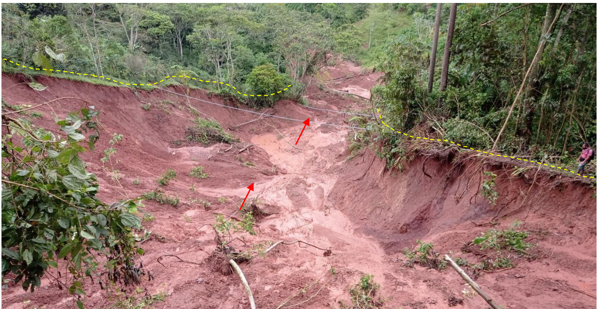
Figura 19. Vista de la canalización del deslizamiento flujo de lodo N°2.
