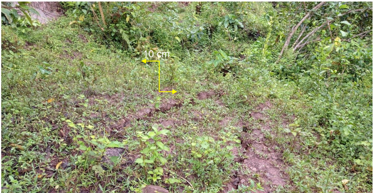
Figura 23. Grietas de tensión de 10 cm de abertura.
