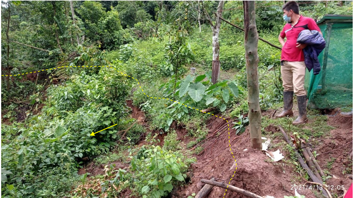
Figura 26. Arcillas saturadas movilizadas por el evento.
