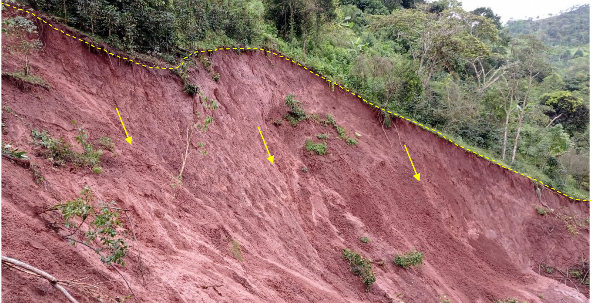
Figura 18. Vista hacia arriba de la zona de arranque del deslizamiento flujo de lodo N°2.
