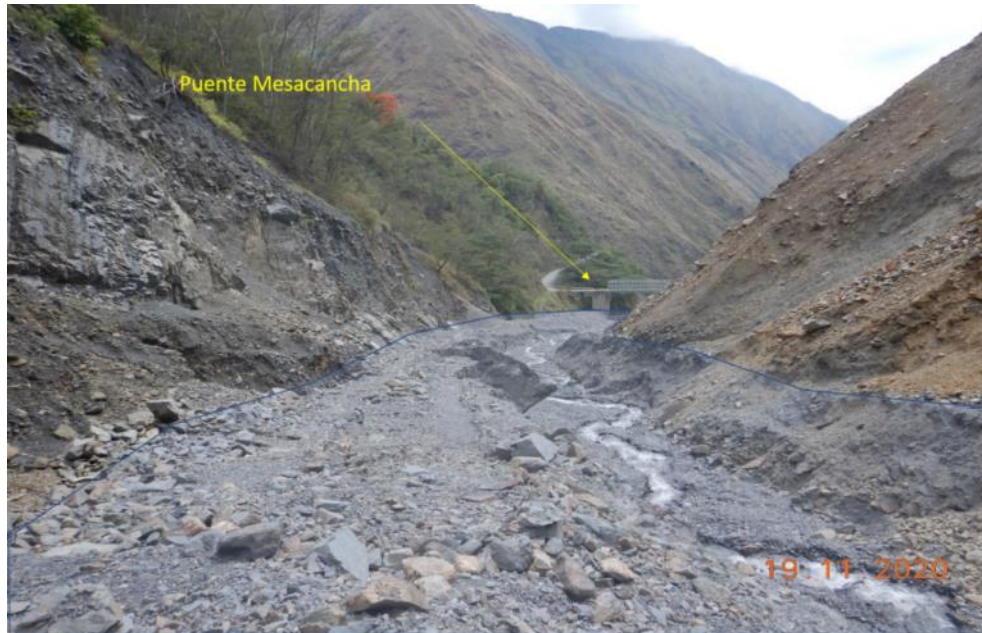
Figura 2: Flujo de detrito del año 2014 que afectó al puente Mesacancha.
