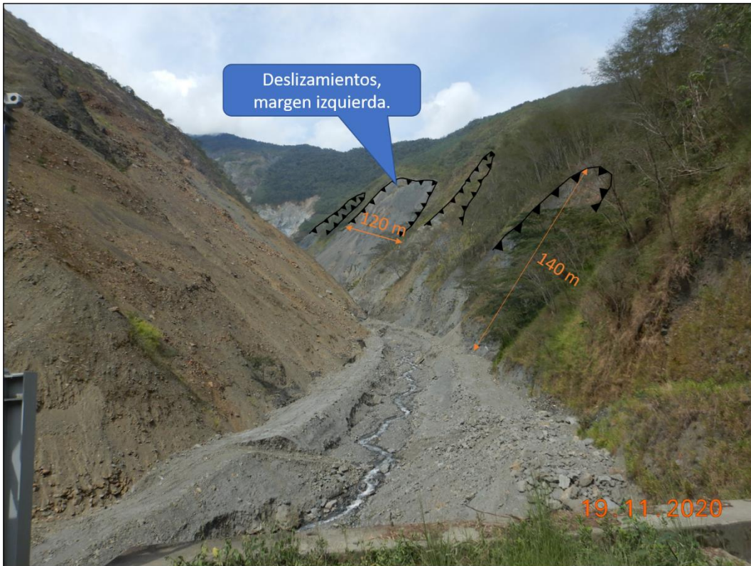
Figura 4: Cartografía de los deslizamientos de la margen izquierda del río Mesacancha.
