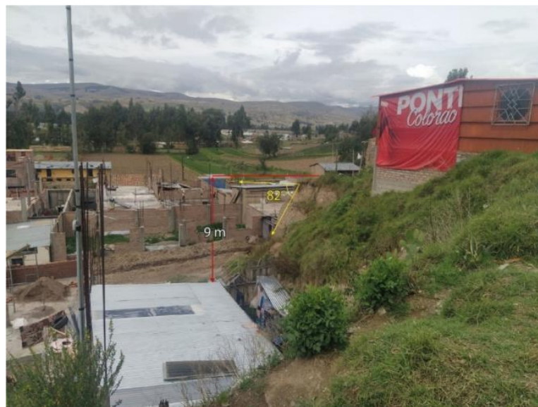
Figura 14. Altura y pendiente del talud 2 verticalizado.
