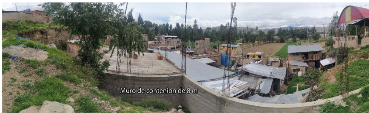
Figura 24. Muro de contención construido a partir de los derrumbes del 2019.
