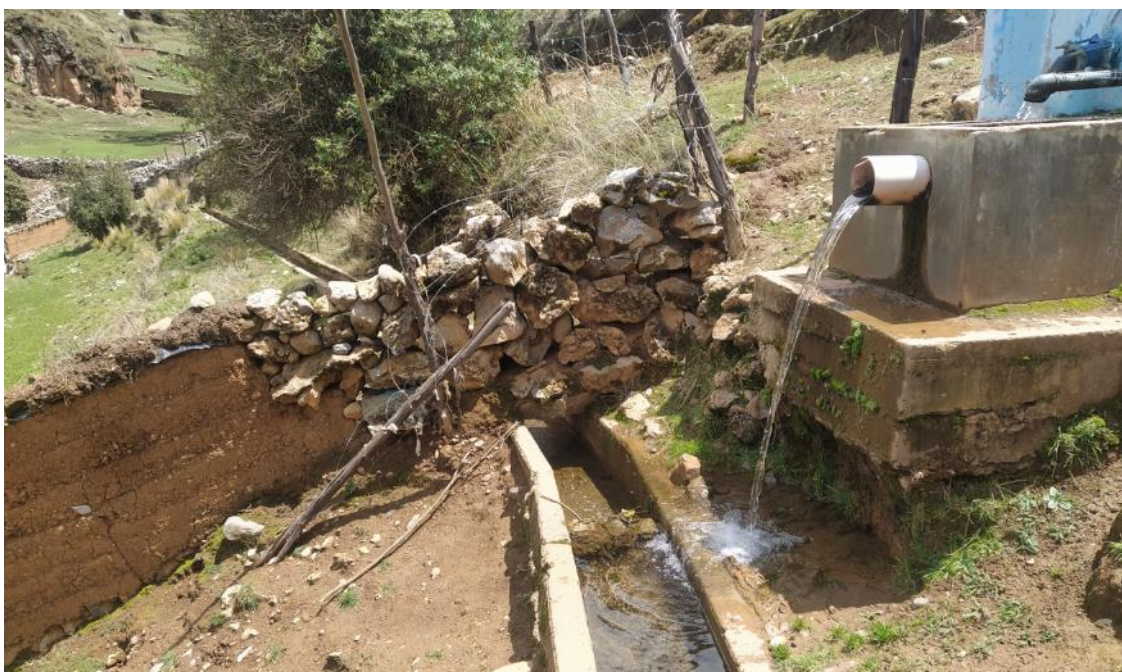
Fotografía 4. Captaciones de agua que discurren por canales impermeabilizados incorrectamente dimensionados, saturan las laderas del cerro Huacrash.
