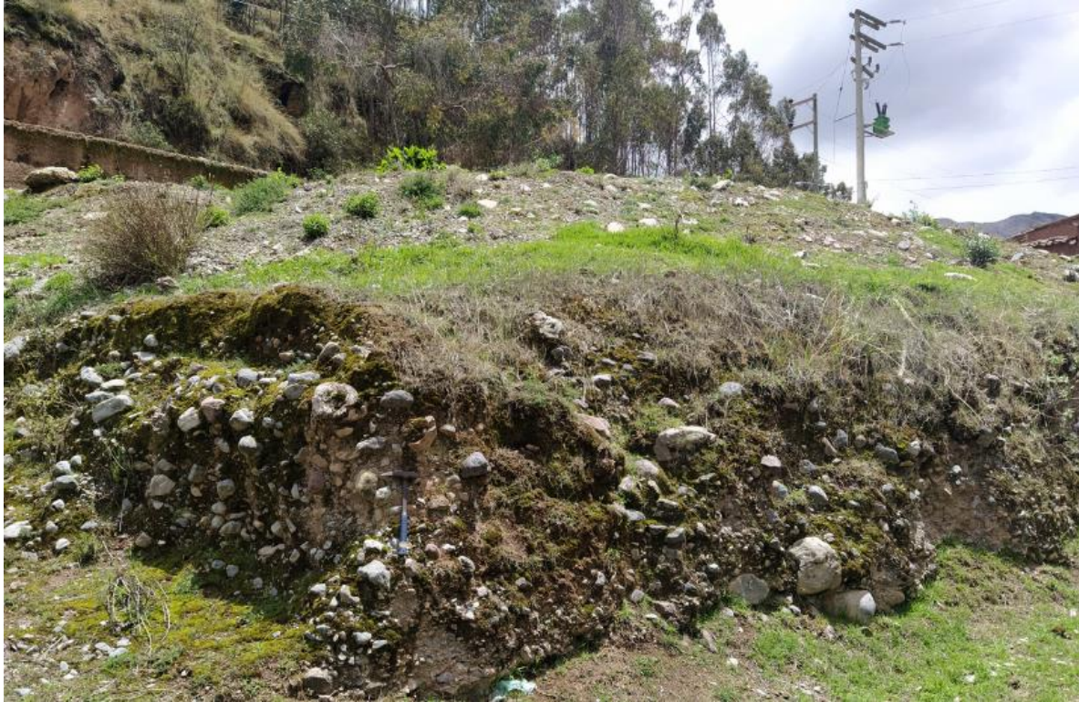
Fotografía 1. Depósitos coluvio-deluviales en la ladera sur del cerro Huacrash.
