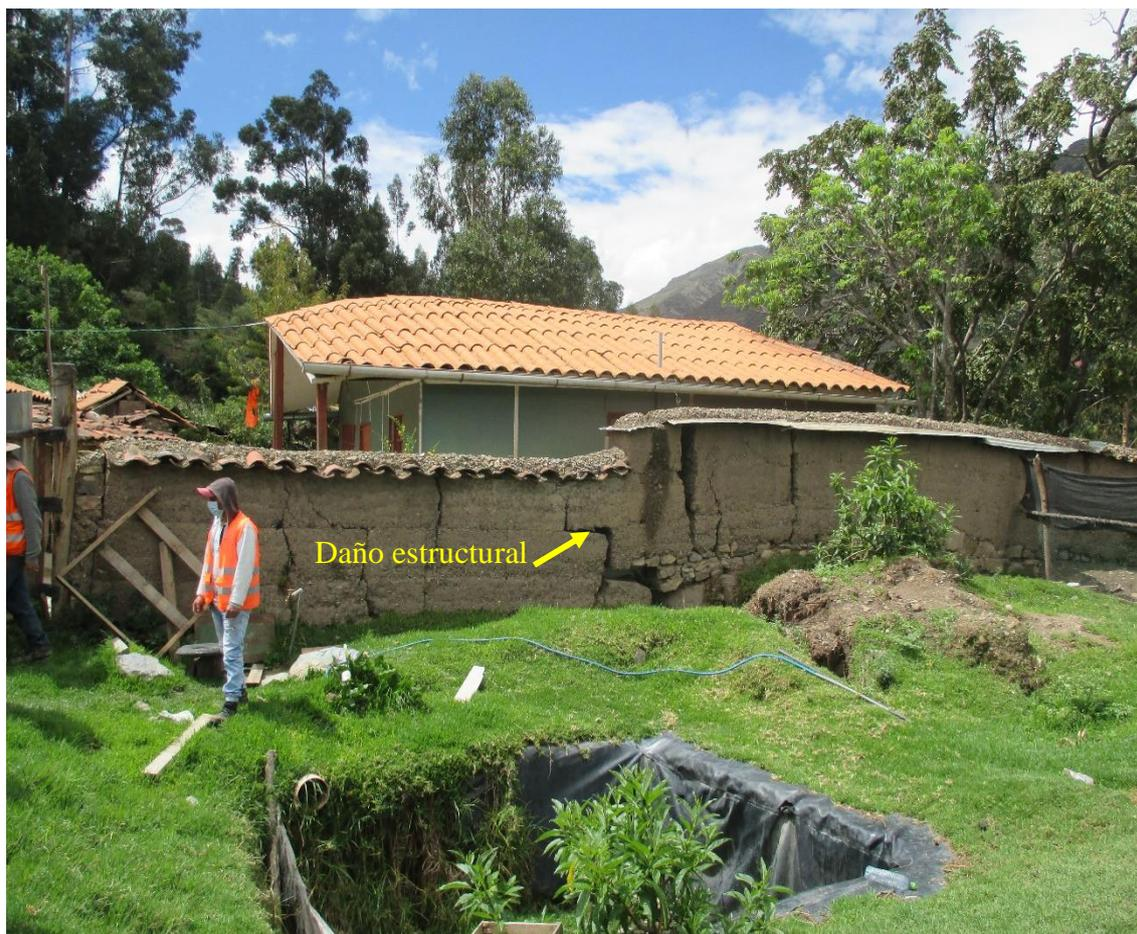
*Figura 3. Asentamiento del suelo y presencia de agrietamientos en estructuras de albañilería.*
