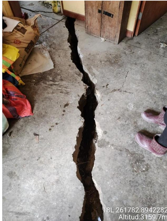
*Figura 13. Grietas de hasta 12 cm en vivienda afectada por deslizamientos.*
