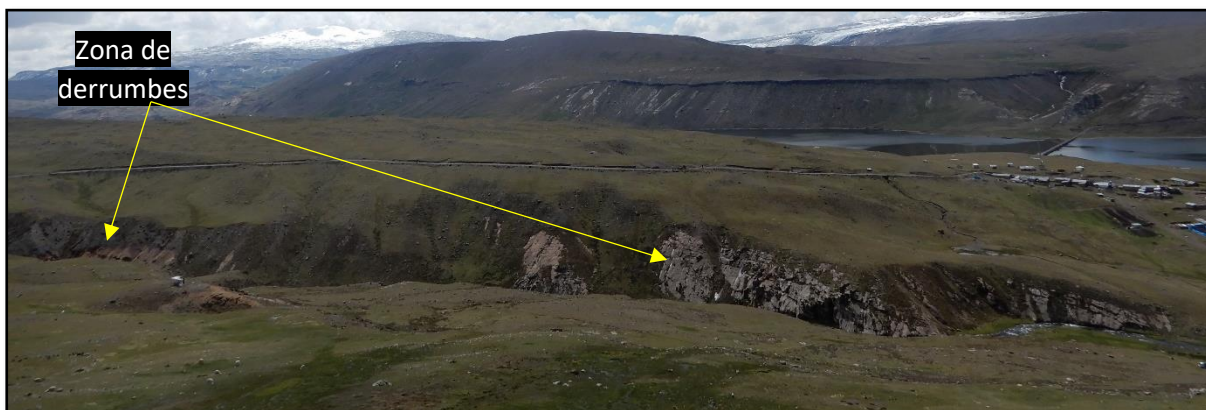
Figura 5. Zona de derrumbes en Arcata. (coordenadas UTM E: 792489., N: 8335672).
