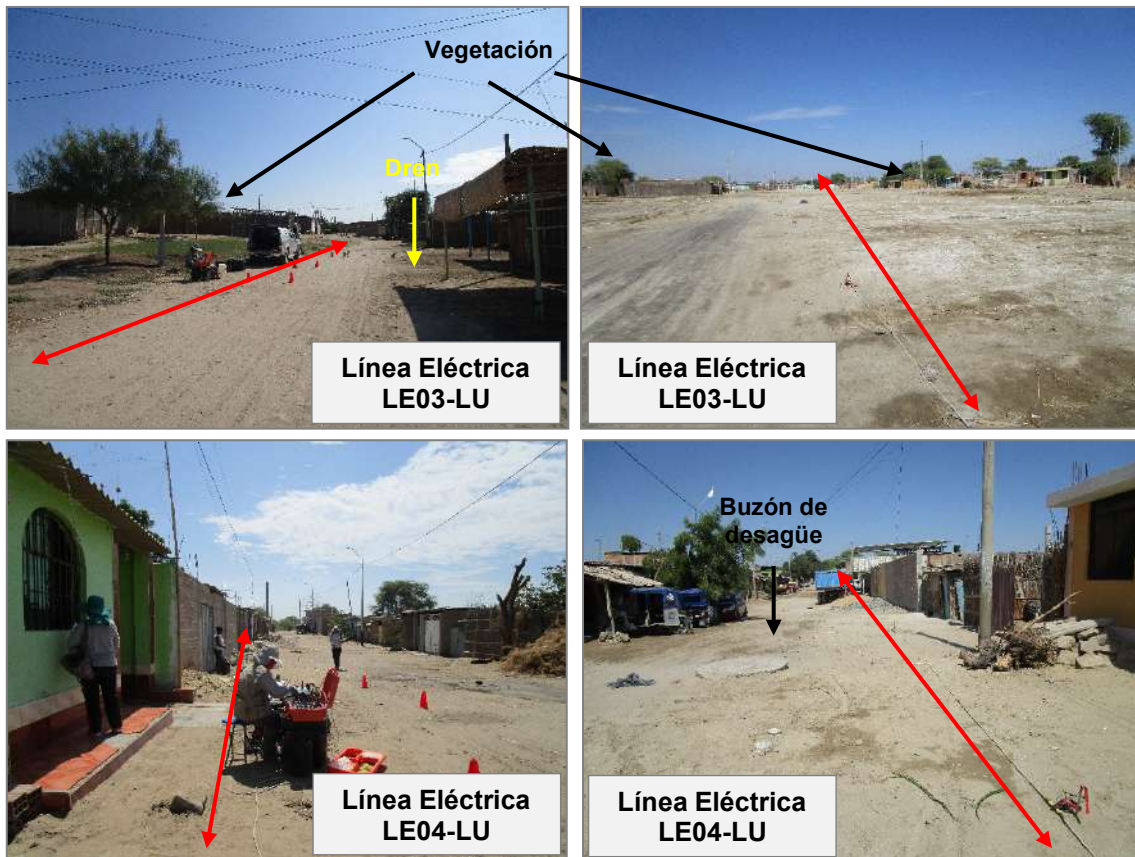
Figura 15. Vista de la línea eléctrica LE01-LU, LE02-LU, LE03-LU y LE04-LU.
