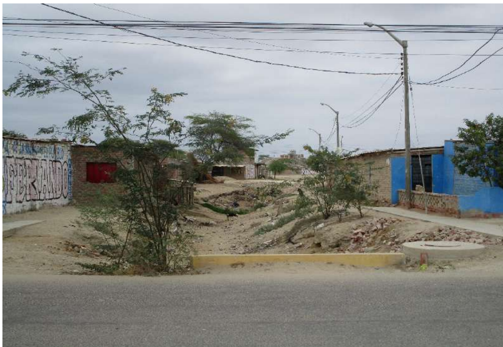
Foto 11: Canal de desfogue localizado en el sector urbano Tablazo Norte.
