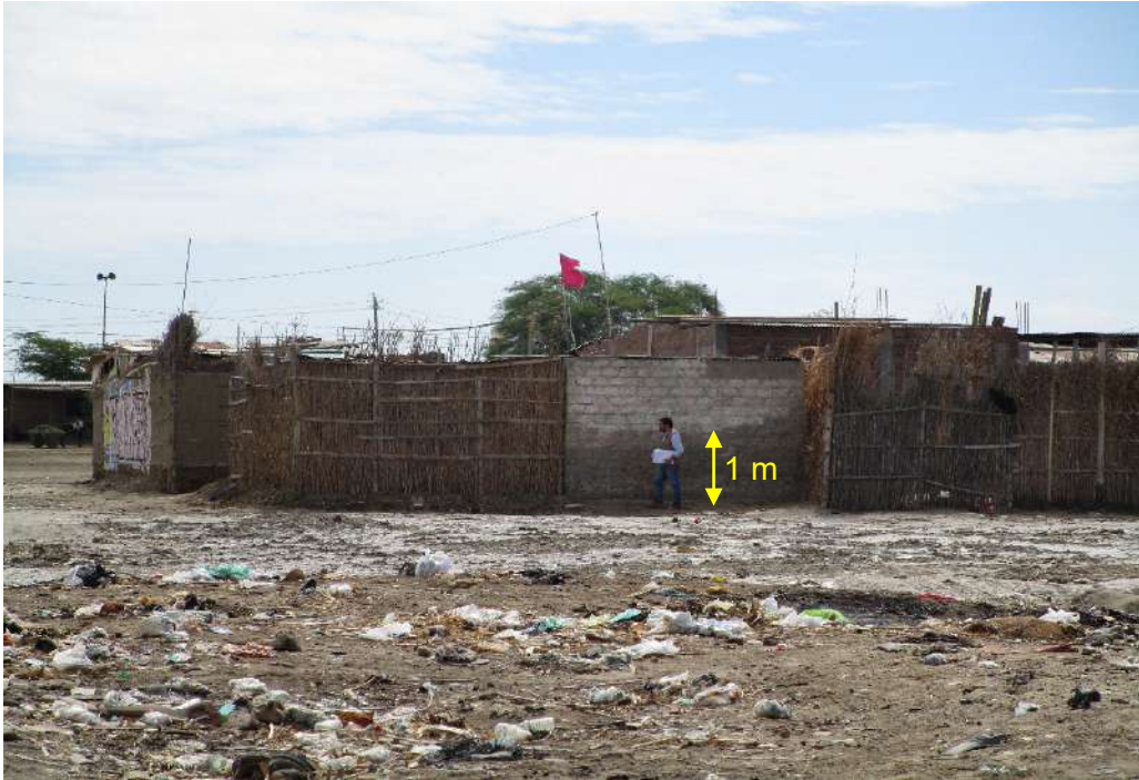
Foto 09. El agua llegó a 1 m de altura, afectó a las viviendas localizadas en el sector Arroyo Mío.
