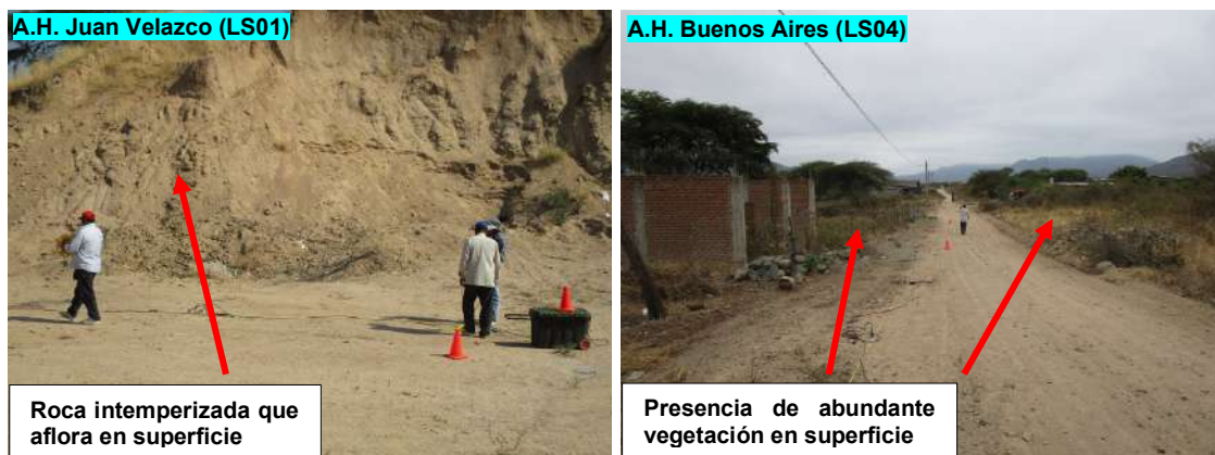
Figura 14. Sectores en los cuales se muestra un cambio en las características del tipo de suelo.
