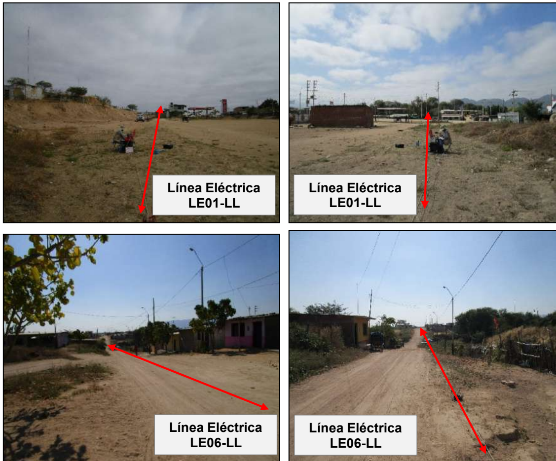
Figura16. Vista de la línea eléctrica LE01-LL y LE06-LL.
