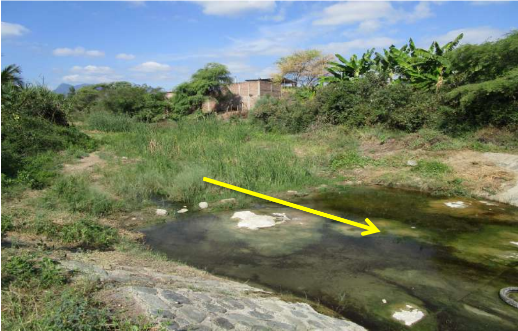
Foto 13: En las intersecciones de jirón Loreto con Pasco, empieza la canalización del Canal Vía, el mismo que se encuentra sin mantenimiento y con agua empozada, foco de infecciones y enfermedades. La flecha amarilla indica la dirección del flujo
