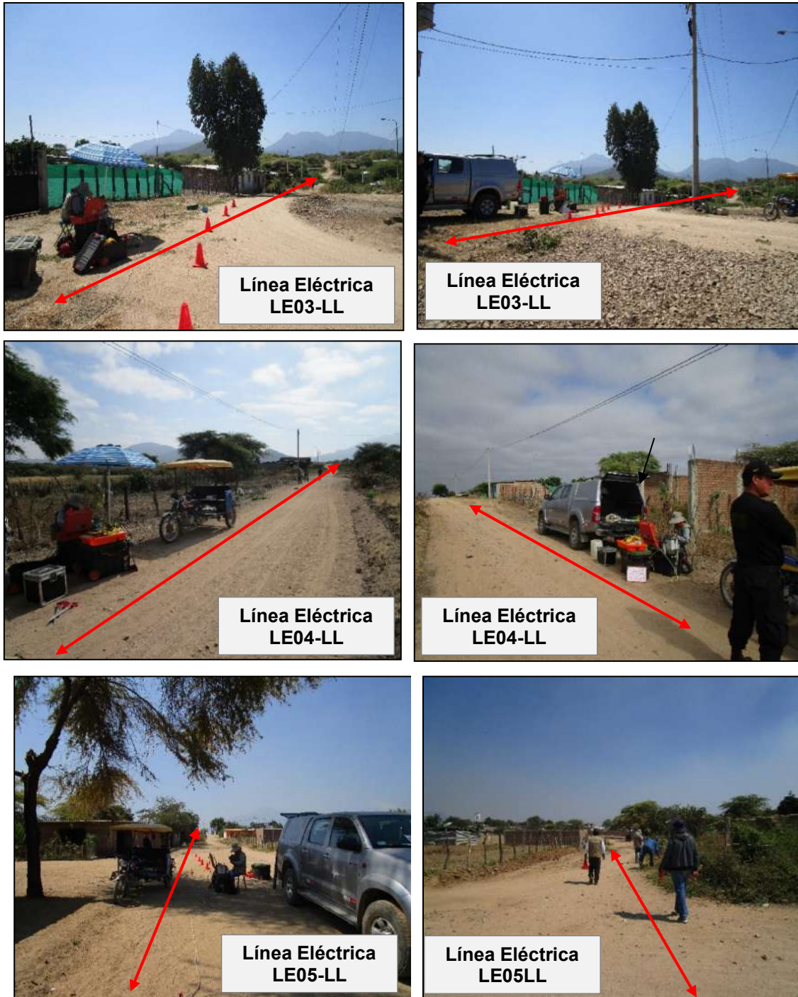
Figura15. Vista de la línea eléctrica LE02-LL, LE03-LL, LE04-LL y LE05-LL.
