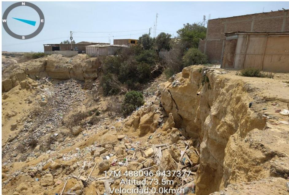
*Figura 15.- En el A.H Hermanos Cárcamo se aprecia eventos de caída de rocas, derrumbes y zona de torrenteras que se activan en periodos lluviosos, afectando la seguridad física de las viviendas asentadas en las inmediaciones.*
