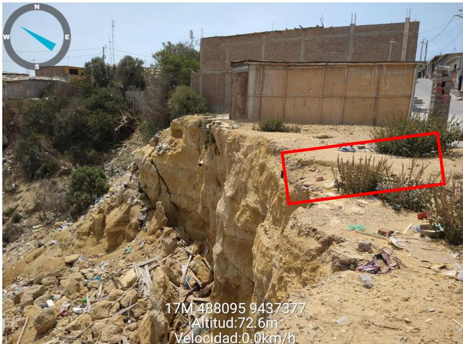
*Figura 16.- Por versión de los pobladores, en el A.H. Hermanos Cárcamo ha colapsado una vivienda asentada en la parte indicada por el cuadro rojo. Asimismo, las viviendas aledañas se encuentran en alto peligro de reactivarse este tipo de eventos.*
