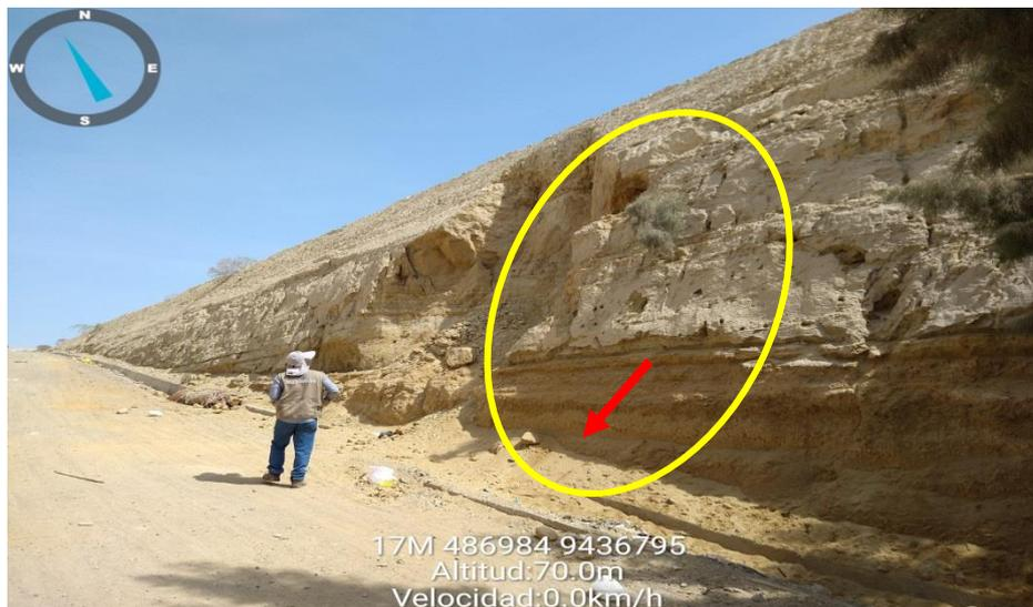
Figura 8.- Zona de caída de rocas (círculo amarillo) que afectó la vía que une sector Tablazo (parte alta de Paita) con San Martín Oriente (parte baja de Paita). A la fecha de inspección ya se encontró el material removido
