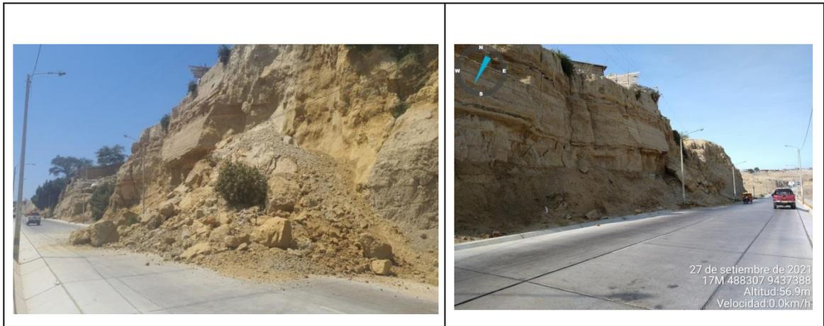
Figura 7.- Caída de rocas ocurrido el 07-08-2021 (foto de la izquierda) y que dejó interrumpida la vía que une Paita Baja con Paita Alta. El día 27-09-2021 (foto de la derecha) se encontró ya recuperada la vía
