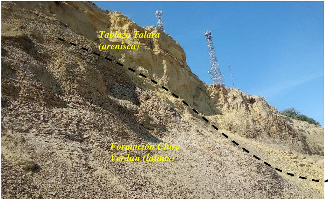
Figura 4.- Límite de la formación Chira Verdún y el Tablazo Talara. Aquí, las lutitas se erosionan muy fácilmente, lo que permite el socavamiento del talud para causar la inestabilidad de las areniscas que se encuentran en la parte alta del talud
