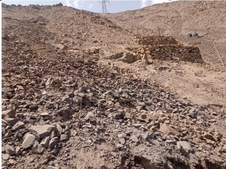
Fotografía N°2 – Caída de rocas en el sector de Virgen del Carmen-Ñaña
