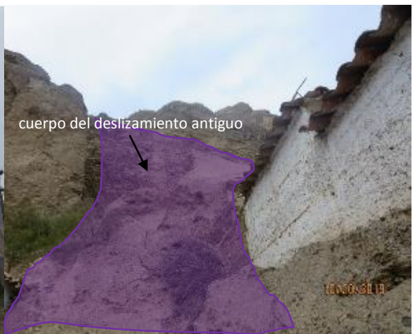
Figura 72. Depósito inconsolidado susceptible a ser movilizado poniendo en peligro un tramo de carretera asfaltada y un vivero municipal.
