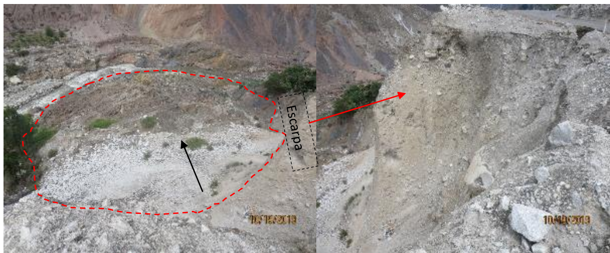
Figura 56. Identificación de deslizamiento antiguo, se nota la escarpa casi vertical de 25 m de altura aproximadamente, en estos suelos inestables están apareciendo grietas y socavación en la base de la vía pavimentada. Fuente: Elaboración Propia, 2019
