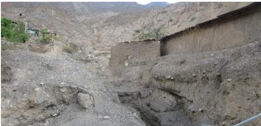
Fotografía 1. Depósito aluvial de 8 m a 13 m de espesor, ubicado al sureste de la localidad de Huallanca, en la parte alta del sector Buenos Aires.
