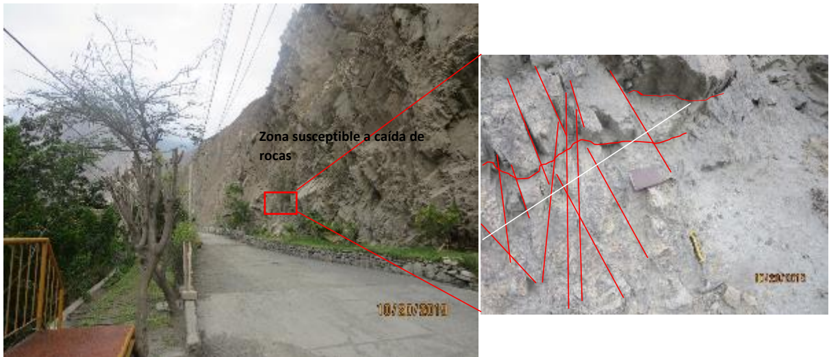
Figura 65. Zona susceptible a caída de rocas, por macizo rocoso fracturado, en el sector de Morocochoa.
