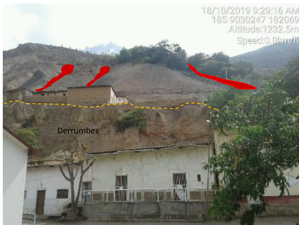
Figura 58. Vista donde se observa flujo de lodos, el material acumulado producto de procesos físico químicos de la roca, estos son arrastrados ladera abajo en forma de flujos de lodo, afecta viviendas asentadas al pie de la ladera; así como, vía asfaltada e infraestructura (Institución Educativa Primaria) ubicado cotas abajo del talud. Fuente: Elaboración Propia, 2019.
