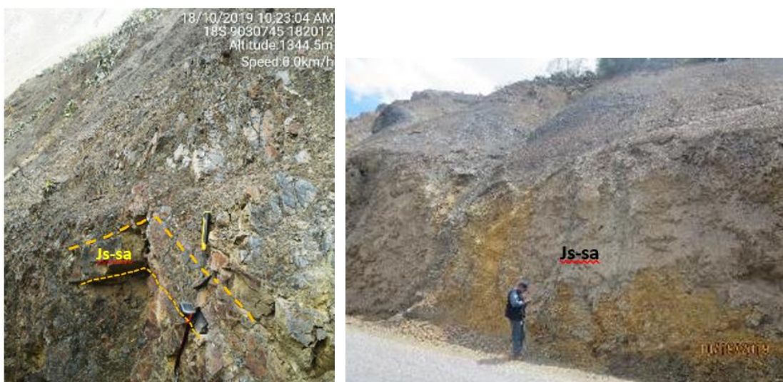
Figura 7. Formación Sapotal hacia el noreste del poblado Yungaypampa con la secuencia de limolitas arenosas, finas, gris oscuras plegadas en forma de Chevrón y en la parte central del mismo poblado afloran secuencias de areniscas cuarzosas, finas, de color gris claro, con superficie amarillenta.
