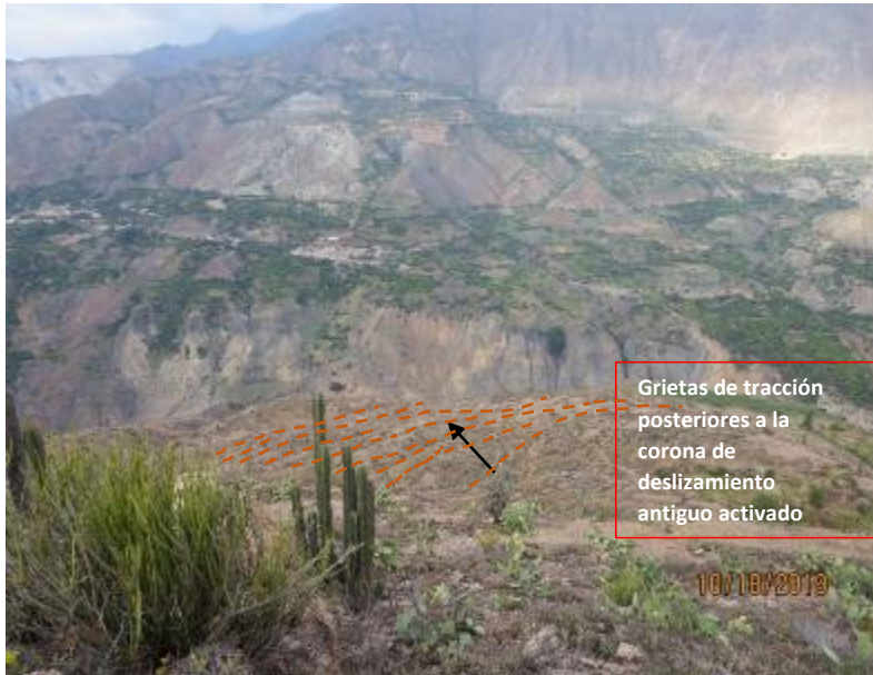
Figura 49. Evidencia de grietas longitudinales en la parte baja de la ladera, generadas por la reactivación por el movimiento lento del deslizamiento antiguo, en ladera de suelos inconsolidados e inestables
