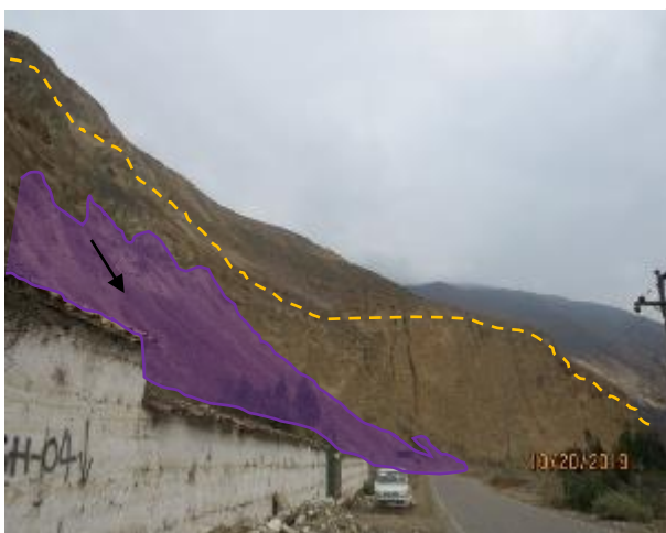
Figura 72. Depósito inconsolidado susceptible a ser movilizado poniendo en peligro un tramo de carretera asfaltada y un vivero municipal.
