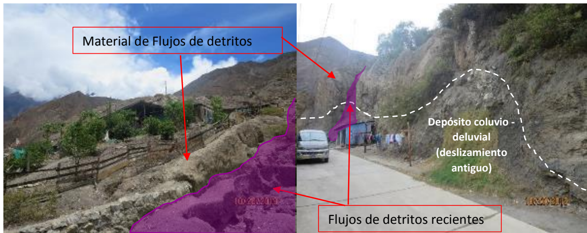
Figura 68. Se aprecian los depósitos coluvio-deluvial conformado por materiales del deslizamiento antiguo, con superficie salitrosa debido a las filtraciones de agua que lavan sedimentos salinos.
