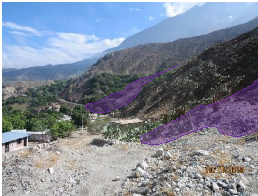
Figura 54. Identificación de material depositado en laderas y lechos de quebradas susceptible flujos de detritos que en periodos de lluvias extremas descenden en dirección al C.P. Yungaypampa.
