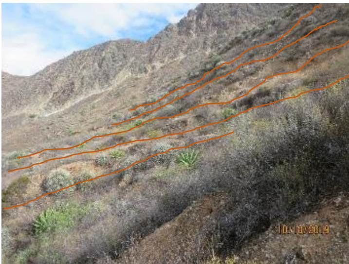
Figura 45. Identificación de zona de reptaciones de seguir el proceso originaría deslizamiento que podría afectar directamente el caserío de Eimar.
