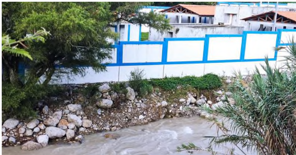
Fotografía N° 02: Erosión del cauce y del talud en la margen derecha del río Chotano exponiendo la cimentación de la PTAR.
