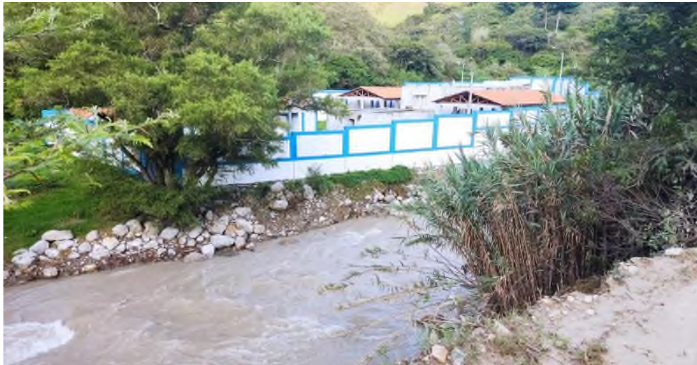
Fotografía N° 02: Erosión del cauce y del talud en la margen derecha del río Chotano exponiendo la cimentación de la PTAR.
