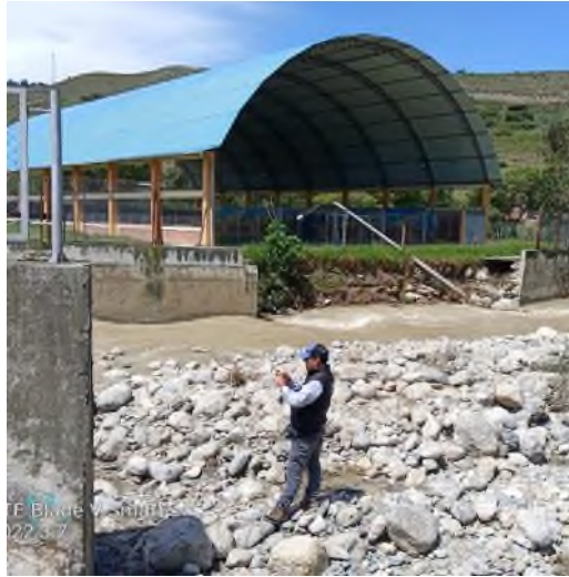
Fotografía N° 02: Acumulacion de roca y sedimento en el cauce del río Jalqueño .
