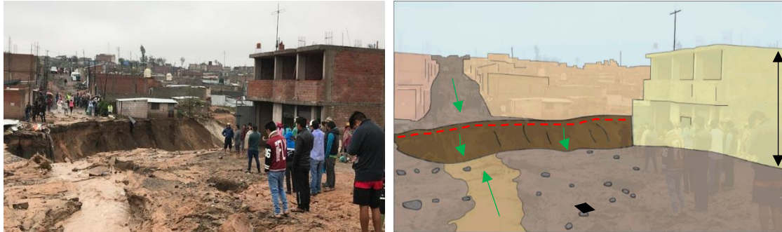
Figura 3. Foto de los daños causados en el sector de Cerro Colorado, 2020 (Fuente: El Comercio)
