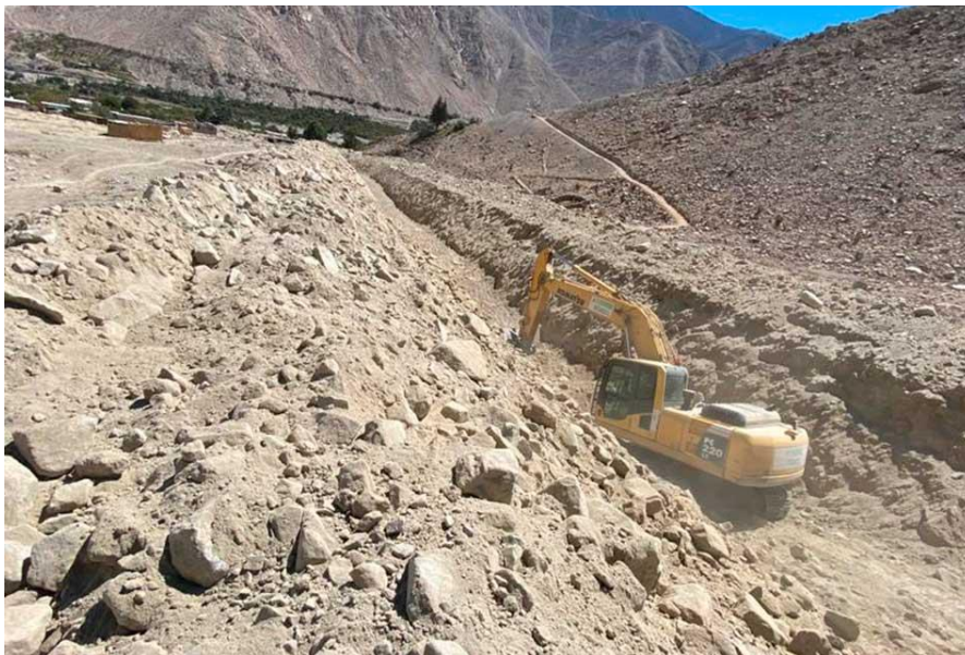
Figura 112. Limpieza de cauce de la quebrada.
