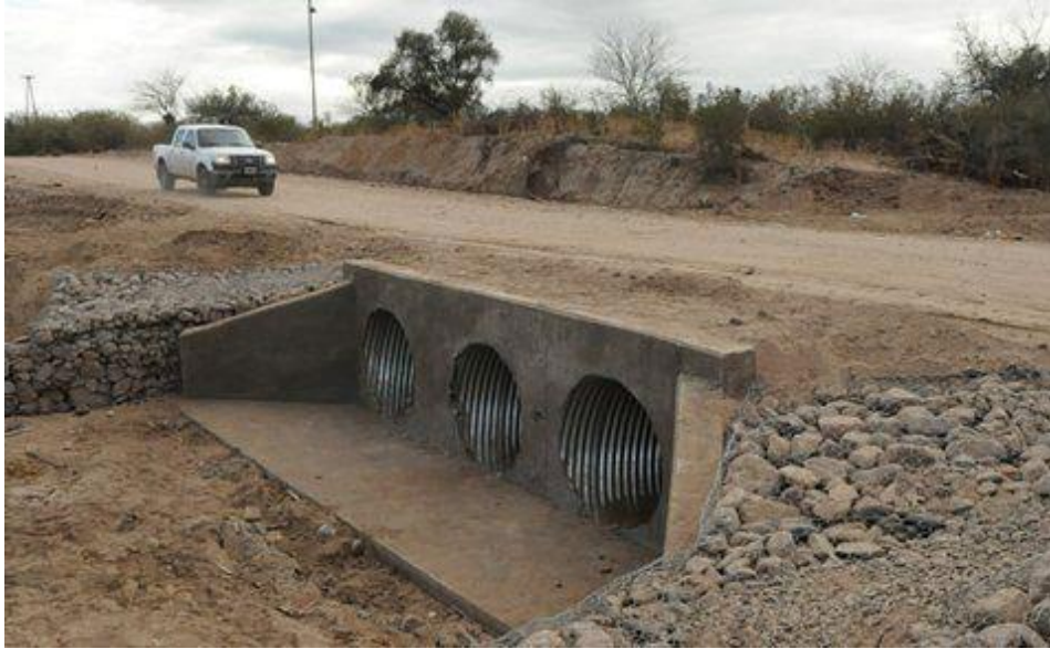
Figura 10. Obras de drenaje para redes viales (alcantarillas y pontones).
