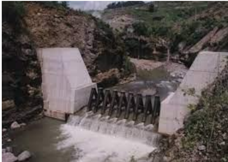
Figura 9. Presas tipo SABO de sedimentación escalonada para controlar la fuerza destructiva de los lahares.
