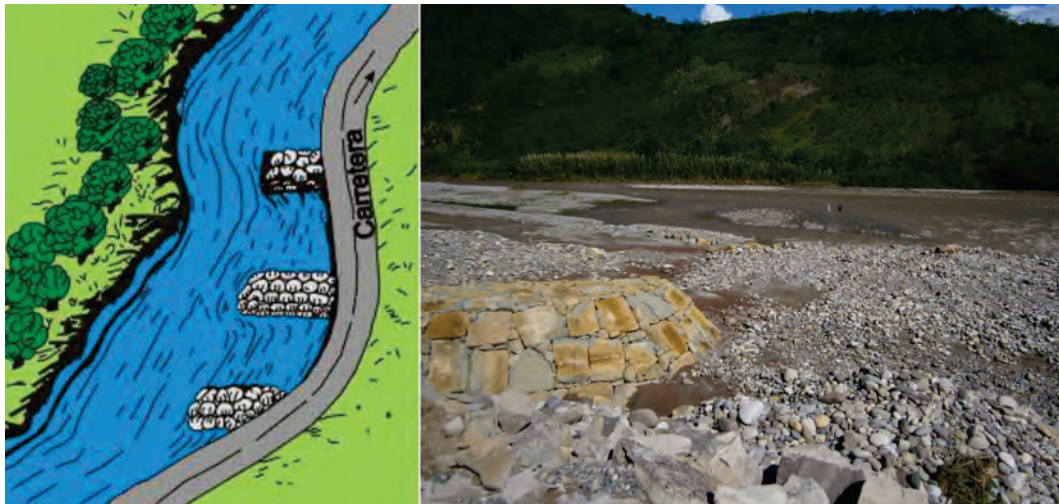
Figura 8.26 Espigones para proteger las terrazas fluviales.
