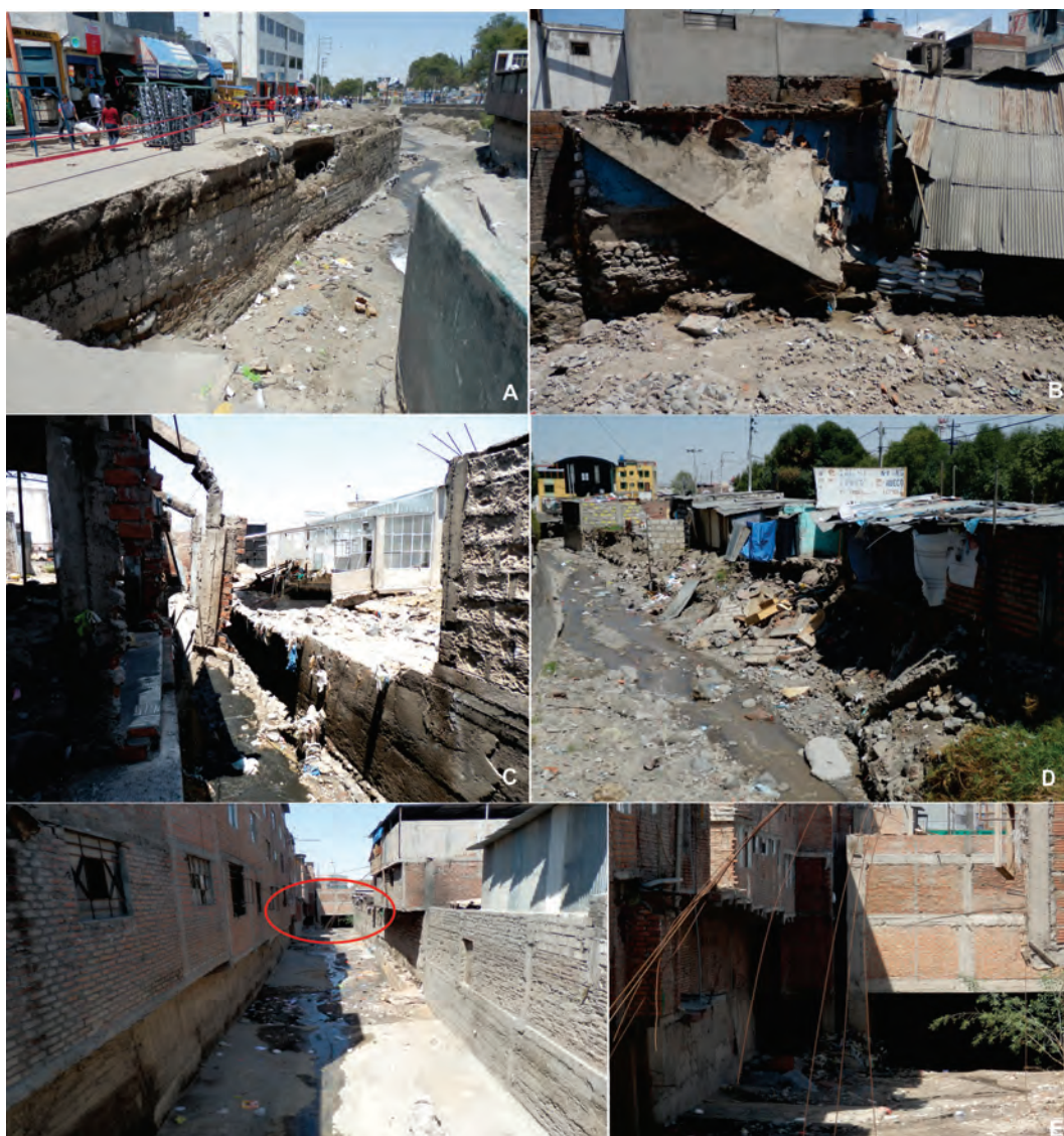
Figura 7.51 A) Colapso de muros de contención en la margen izquierda de torrentera, con pérdida de plataforma de la calle Virgen del Pilar. Este colapso permitió el descubrimiento de un muro antiguo a más de 1 m detrás del actual con 17 m de ancho. B) Colapso de muros de los puestos del mercado del Altiplano. C) El cauce de la torrentera se ha estrechado a 4.54 m de ancho por construcción de edificaciones. Por efecto del flujo, socavó los cimientos del muro de contención en la margen izquierda, lo que generó el colapso de las columnas de la fábrica textil y el rebose en ambas márgenes, en el pasaje Victoria. El puente en forma de arco a 11 m aguas abajo tiene un ancho de 3.78 m, el cual estranguló aún más la torrentera. D) Intersección de la Av. Venezuela con el pasaje Jacinto Ibáñez, frente a la Urb. Juan El Bueno. Allí se encuentran ubicadas 6 viviendas y un total de 20 personas que habitan dicho espacio. En la margen derecha de la torrentera, pese a que se realizó la limpieza del cauce, es evidente que las viviendas han avanzado hacia el cauce de la torrentera. Al incrementar el caudal de la torrentera el 8 de febrero, se represó debido a un obstáculo en el puente Vidaurrázaga (letrero de centro comercial). Al desfogar, erosionó 93 m en su margen derecha. E) El cauce de torrenteras se encuentra invadido por edificaciones que, por ganar terreno, han construido por encima de la torrentera.
