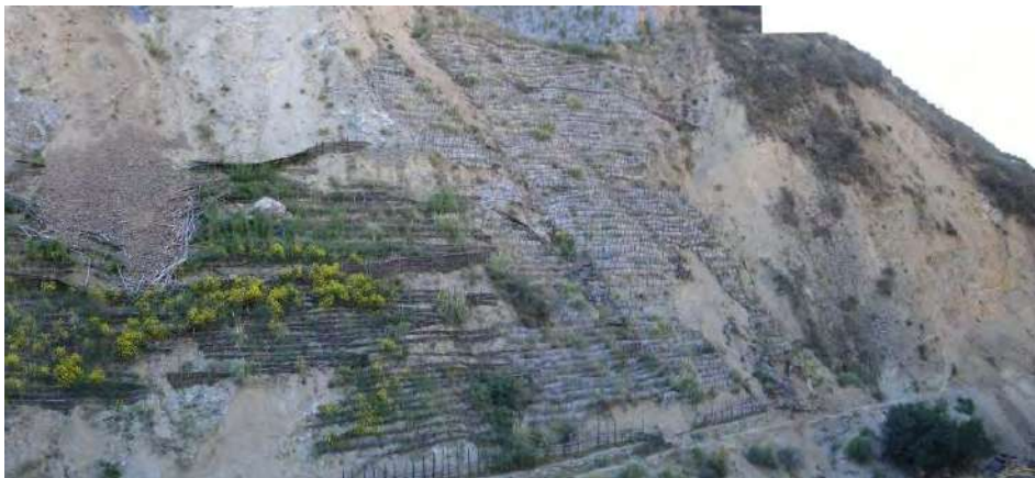
Fotografía 8.4 Ejemplo de evacuación de aguas superficiales y control de erosión en cárcavas, mediante trinchos escalonados.
