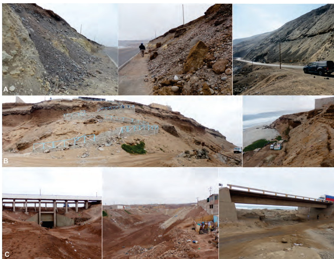
Figura 7.4 A) Derrumbes en talud superior de la carretera Panamericana con presencia de asentamientos en plataforma de la carretera Panamericana Sur km 615+100 al km 616+200. B) Sector de La Aguadita afectado por derrumbes y caída de rocas que afectaron camino peatonal a la playa. C) Quebradas Cementerio y Chala. Aguas arriba de la quebrada Cementerio, se ha obstruido el cauce de la quebrada con rellenos. Tomado el 03 de octubre del 2013, después del sismo del 25/09/13.
