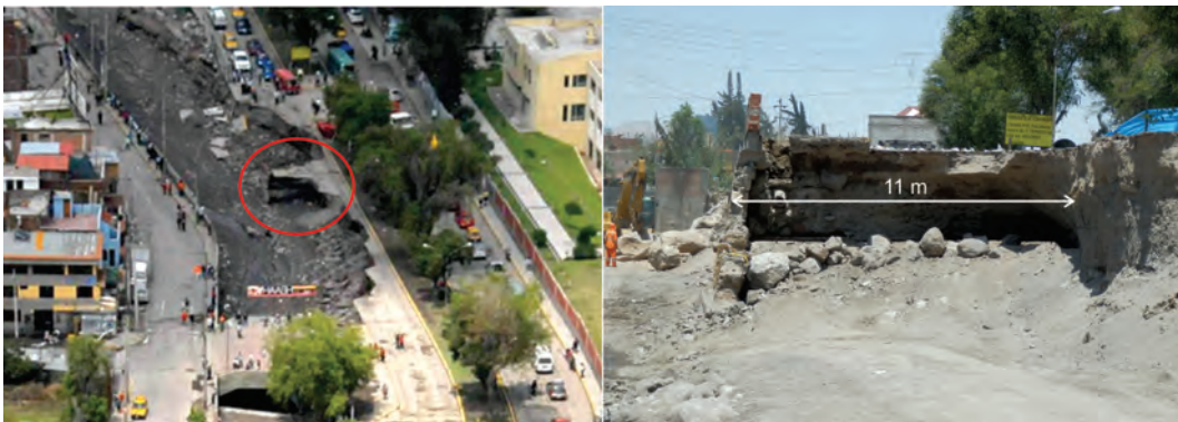
Figura 7.49 Erosión fluvial en la margen derecha de la torrentera Venezuela se llevó parte plataforma de la vía de la Av. Venezuela hasta la berma central, de aprox. 135 m de longitud y un ancho de 11 m.
