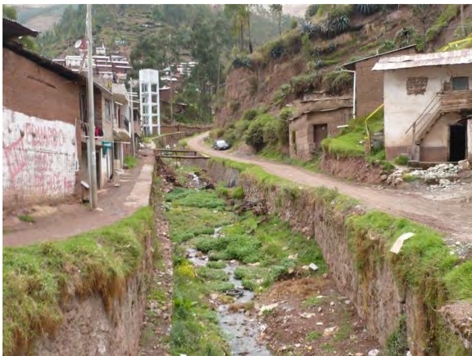
Fotografía 8.2 Encauzamiento de una quebrada.
