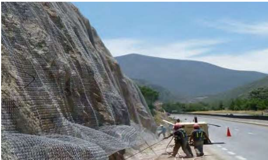
Fotografía 8.1 Mallas de protección con anclajes para caída de rocas o derrumbes tanto en detritos como roca alterada.
