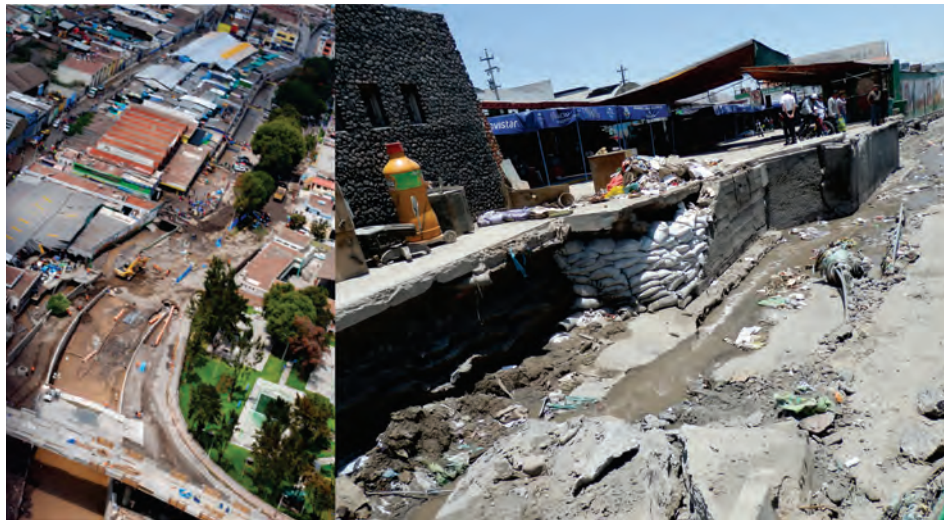
Figura 6.9 En la izquierda, vista aérea del sector Terminal Pesquero: se observa la reducción del cauce en forma escalonada de 6 a 3 m de ancho. En la derecha, ampliación de la vista: erosión en la margen izquierda de la torrentera Venezuela.
