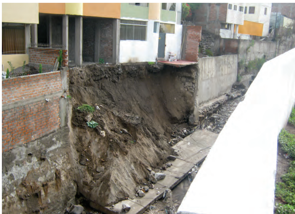
Fotografía 7.32 Vivienda afectada y colapso de muro de contención en la margen derecha de la quebrada San Lázaro debido al incremento del caudal por efecto de las lluvias excepcionales del 08/02/2013.
