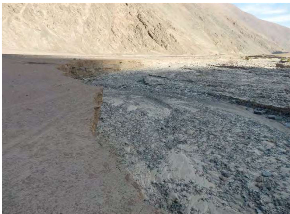
Fotografía 6.10 Erosión fluvial en la margen izquierda del río Atico afecta tramo de la carretera Atico-Caravelí (km 19+200).
