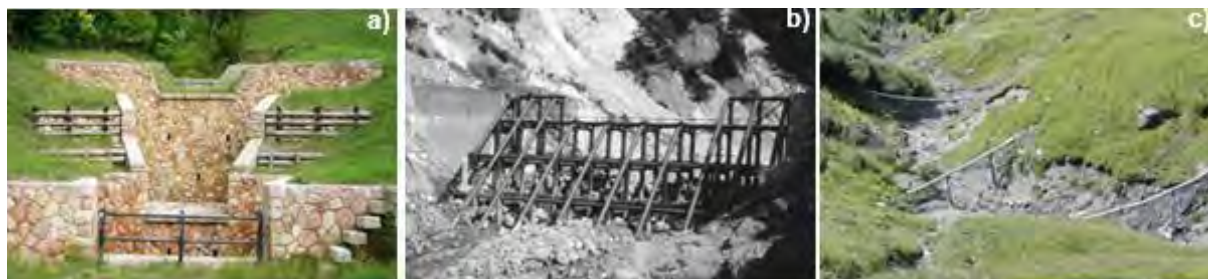
Figura 8.18 Presas tipo SABO de sedimentación escalonada para controlar la fuerza destructiva de los huaicos, a) de control; b) tipo rejilla; c) barras flexibles.
