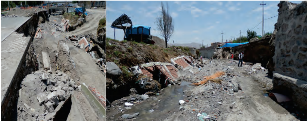
Figura 7.52 Presenta erosión de la vía asfaltada en la Av. Venezuela, debido al socavamiento de los cimientos de muros de sillar del mercado que generó el colapso de los mismos en el mercado Mariscal Castilla.
