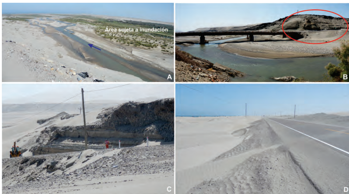
Figura 7.3 A) Área sujeta a inundación fluvial en ambas márgenes del río Yauca. B) Arenamiento en la margen izquierda del río Yauca. C) Derrumbes en talud superior de la carretera Panamericana Sur en depósitos de conglomerados y de arena. D) Invasión de dunas en carretera Panamericana Sur, km 578+000.
