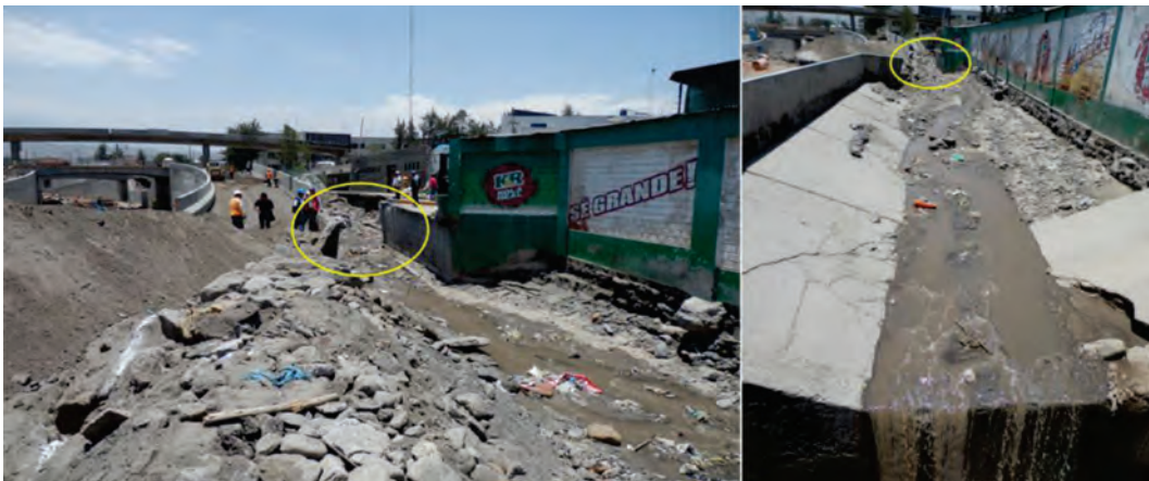
Figura 7.50 Vistas del estrangulamiento del cauce de la torrentera Venezuela, afectado por inundaciones de lodo. El depósito alcanzó hasta 1 m de altura.
