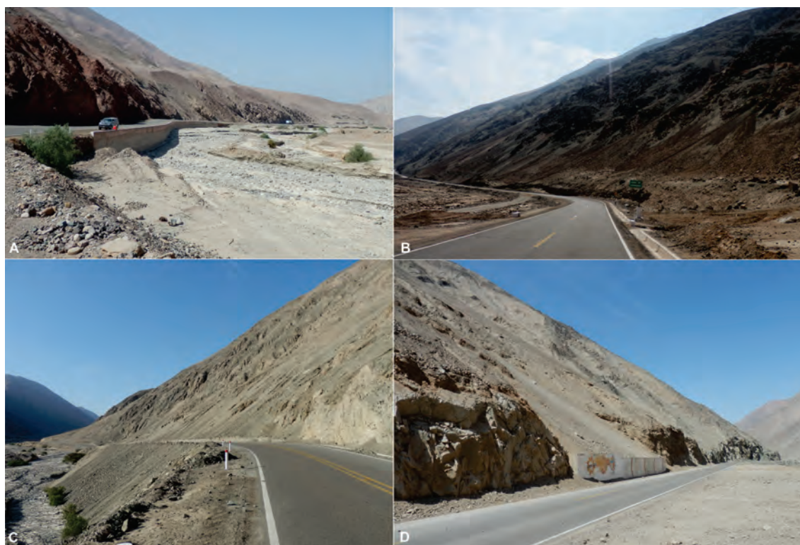
Figura 7.7 A) Erosión fluvial en la margen izquierda del río Atico, en el km 11+420 de la carretera Atico-Caravelí. B, C y D) Derrumbes en talud superior de carretera Atico-Caravelí, en los km 22+250, km 18+320, km 21+300 respectivamente.
