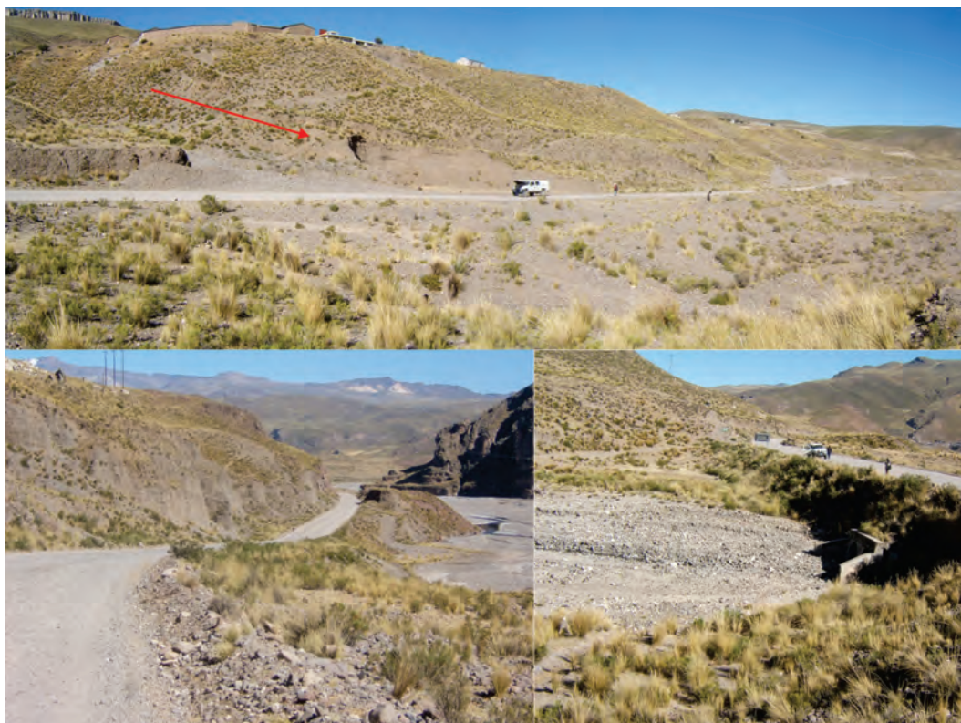
Figura 7.43 Sector de Callalli. Tramo de carretera de unos 600 m que se ve afectado por derrumbes y huaicos.
