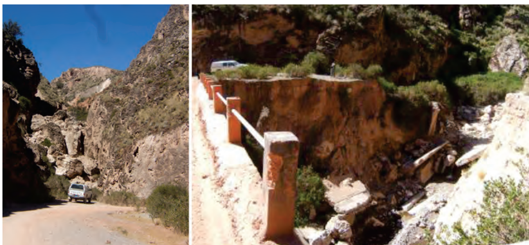
Figura 7.34 Carretera entre Huambo y Alto Sihuas. Derrumbe en la margen izquierda de la quebrada Mulapampa, erosión por el huaico generado aguas abajo.
