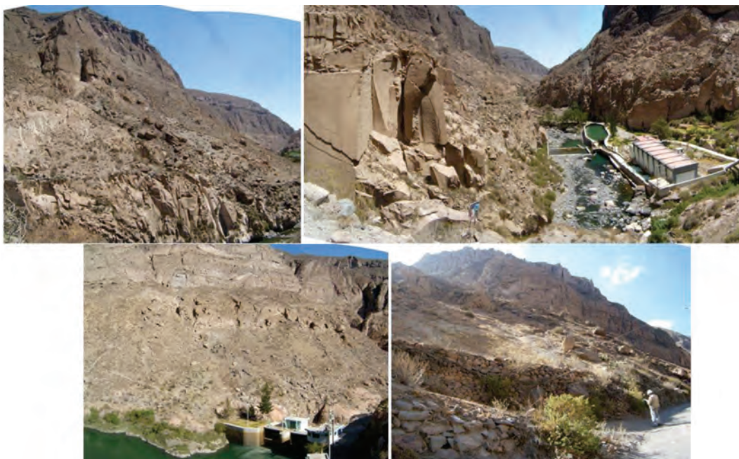
Figura 7.55 Laderas y taludes propensos a caída de rocas y derrumbes en el cañón del río Chili (ambas márgenes) que obstaculizarían el tránsito y afectan las centrales hidroeléctricas en Charcani.
