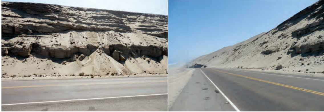
Figura 7.5 Derrumbes en depósitos eólicos y marinos en el km 648+000 de la carretera Panamericana Sur.
