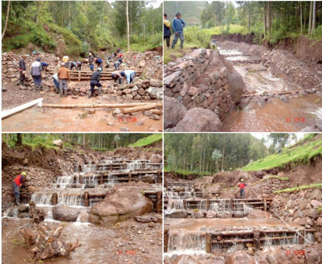
Figura 8.16 Construcción de disipadores de energía de las corrientes concentradas en el cauce de la quebrada, mediante diques transversales (enrocado y armazón de troncos) y canalización del cauce con muros laterales escalonados utilizando bloques de rocas para mitigar los efectos ante la ocurrencia de un flujo de detritos.
