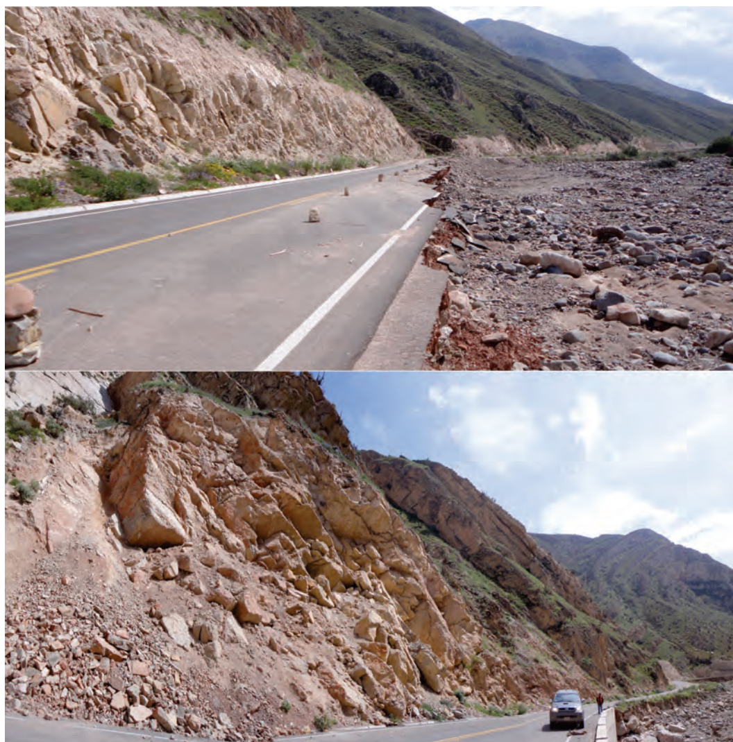
Figura 7.57 Quebrada Liquirca aumentó su caudal en el periodo lluvioso 2012, lo que generó erosión fluvial en la margen derecha, afectando tramo carretero Yura-Huanca en 100 m (Km 9+720).
