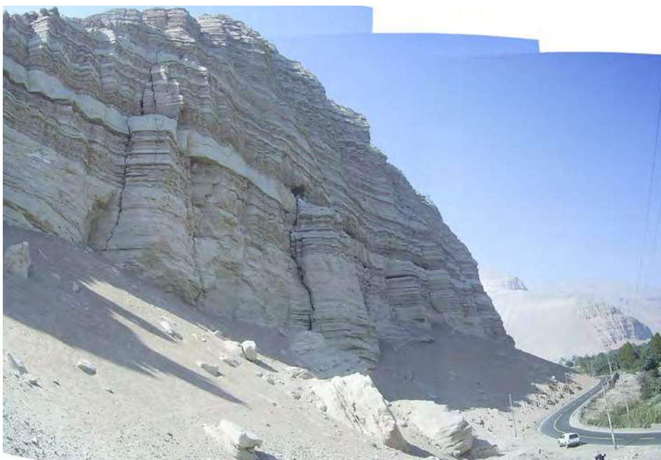
Fotografía 7.15 Derrumbes y agrietamientos en el sector Recodo Cerro que afectan la carretera Aplao – Huancarqui.
