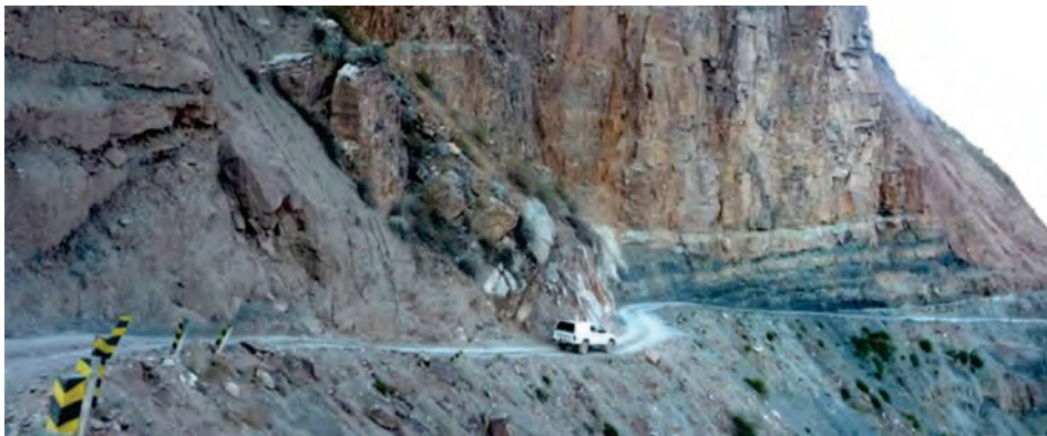
Fotografía 7.8 Talud de pendiente muy escarpada con sustrato rocoso muy fracturado y meteorizado, susceptible a la ocurrencia de caída de rocas y derrumbes en talud superior de la carretera Andamarca-Charcana.
