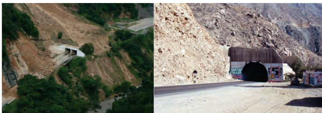
Figura 8.11 Túnel falso en la carretera Rafael Caldera Mérida (izquierda), Venezuela; carretera central Lima-La Oroya, Perú (derecha).
