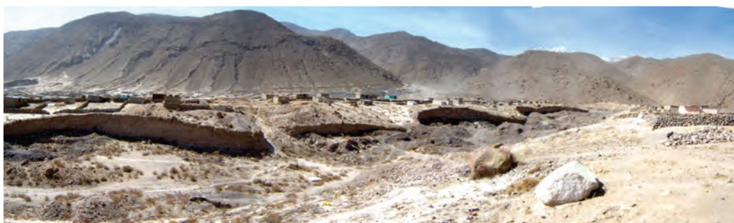
Fotografía 7.38 Erosión en cárcavas y posibilidad de ocurrencia de flujo de detritos en el sector Virgen de Chapi.
