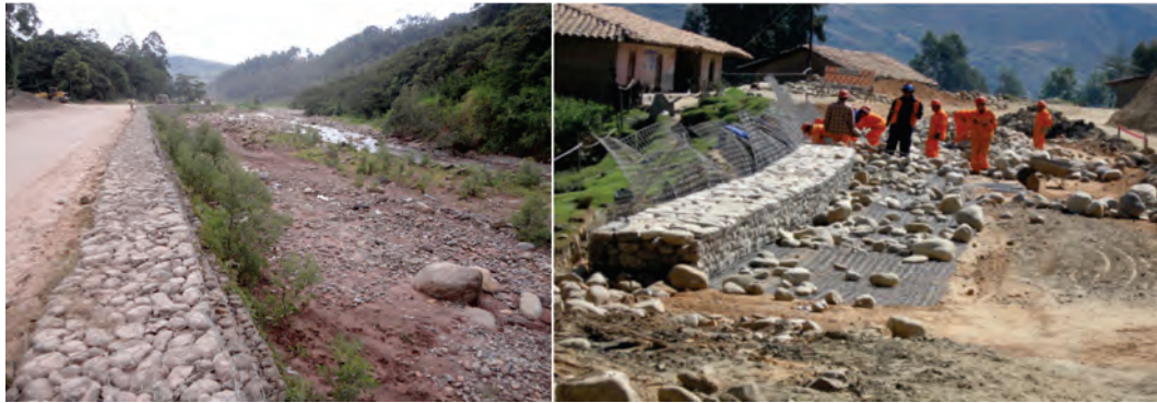
Figura 8.25 Ejemplos de uso de enrocados y muros de gaviones para protección de carretera. En muchos casos, esto debe estar acompañado de un levantamiento de la rasante de la carretera.
