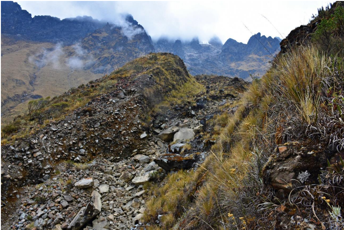
Foto 3. Talud exterior en la zona de desagüe (03/09/2020 / V.Bustinza)
