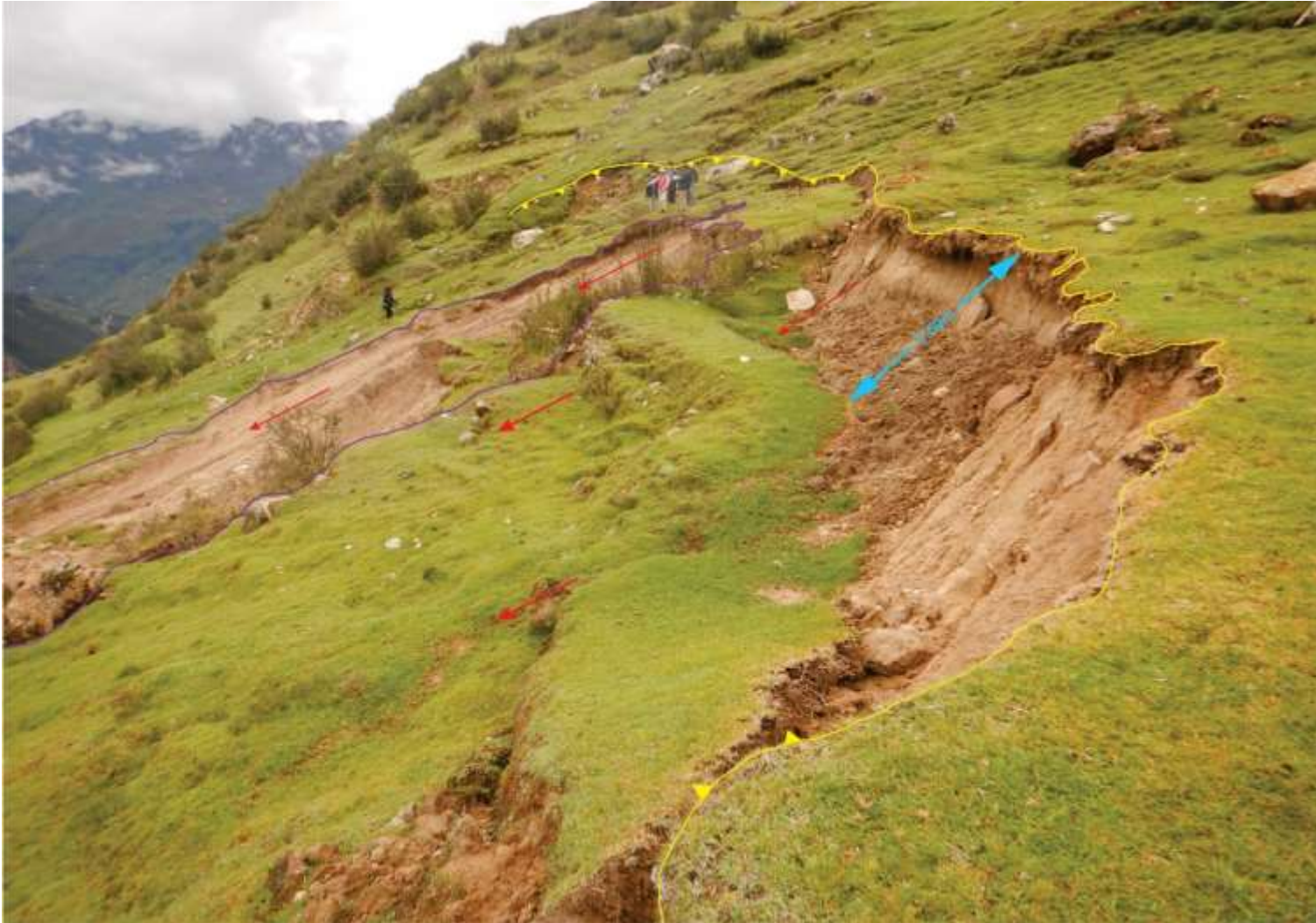
Figura 10. Vista de la escarpa del deslizamiento rotacional, que tiene una longitud de 25 m y un salto vertical de 0.50 m
