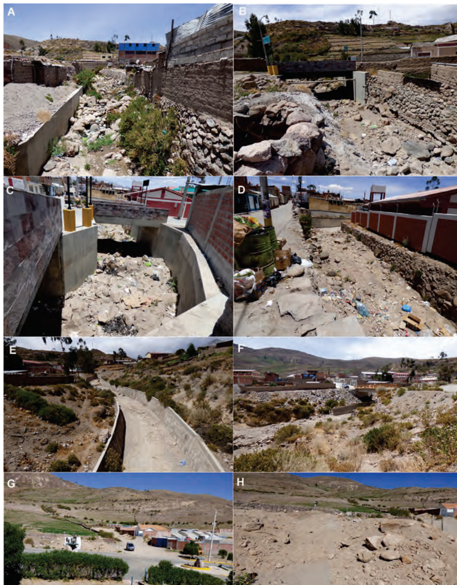
Figura 7.7 A) Vista del cauce colmatado del río Candarave, aguas arriba del puente 2 de Mayo; B) Vista del cauce estrangulado y colmatado aguas arriba del puente El Triunfo; C y D) Cauce colmatado encauzado por partes, aguas abajo del puente Dos de Mayo; E y F) Canalización de una parte del río Candarave hasta el puente Candarave de 14 m de longitud, como se observa en las vistas anteriores, en la parte alta el cauce se encuentra estrangulado (5-6 m) y colmatado; G y H) depósito del último huaico acarreado por la quebrada Jucuturi.
