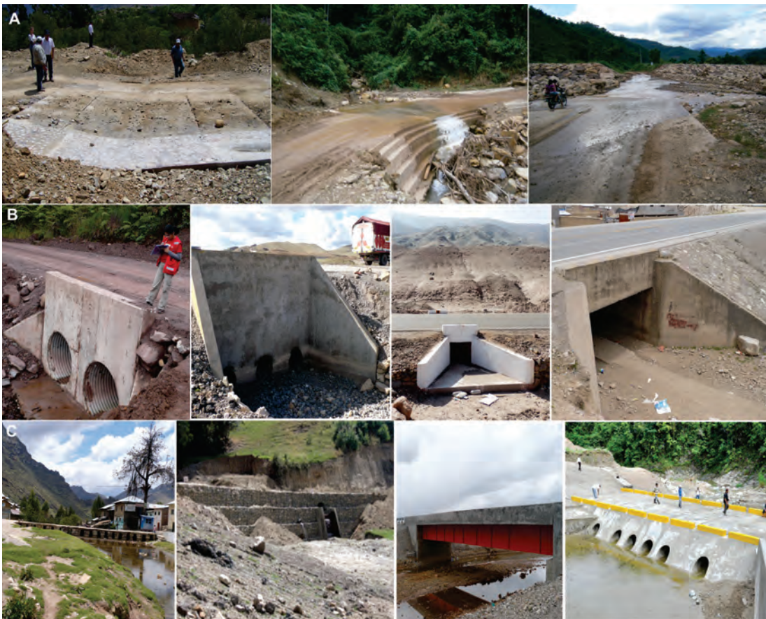
Figura 8.19 Obras de drenaje para redes viales: A) badenes; B) alcantarillas y pontones; y C) puentes, puentes-badén
