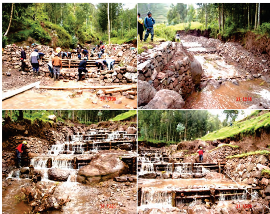
Figura 8.16 Construcción de disipadores de energía de las corrientes concentradas en el cauce de la quebrada, mediante diques transversales (enrocado y armazón de troncos) y canalización del cauce con muros laterales escalonados utilizando bloques de rocas para mitigar los efectos
