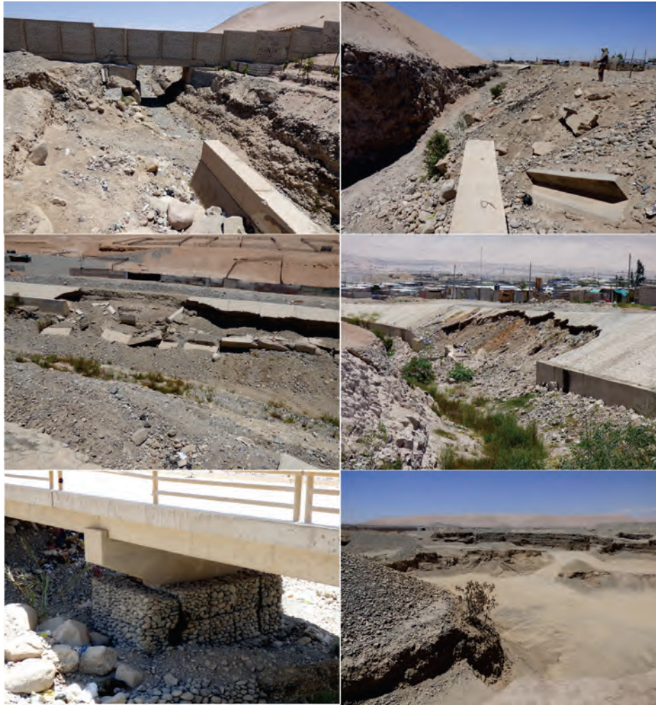
Figura 7.30 Vistas de la erosión fluvial en ambas márgenes del río Arunta, debido a la socavación de las bases colapsaron los muros, aguas abajo se colocó gaviones para proteger estribo de puente, lo cual fue insuficiente. Pasando el puente se extrae material para canteras en donde se pierde el cauce normal del río.
