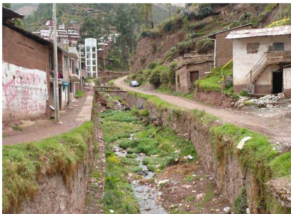
Fotografía 8.2 Encauzamiento de una quebrada.
