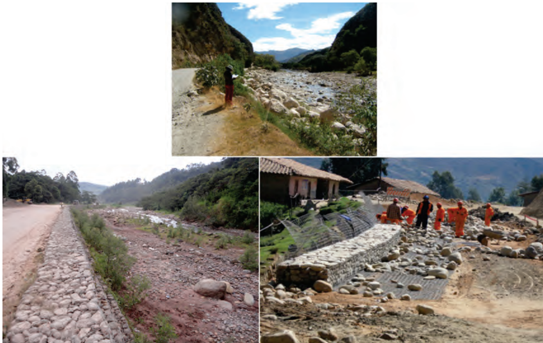
Figura 8.25 Ejemplos de uso de enrocados y muros de gaviones para protección de carretera. En muchos casos esto debe estar acompañado de un levantamiento de la rasante de la carretera.
