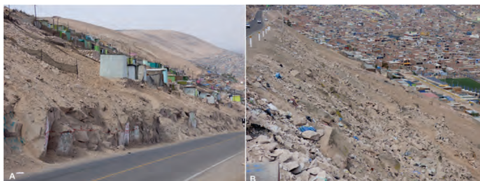
Figura 6.14 Caída de rocas en la Asociación Villa Intiorko, en el talud superior (A) e inferior (B) de la carretera Tacna-Tarata.
