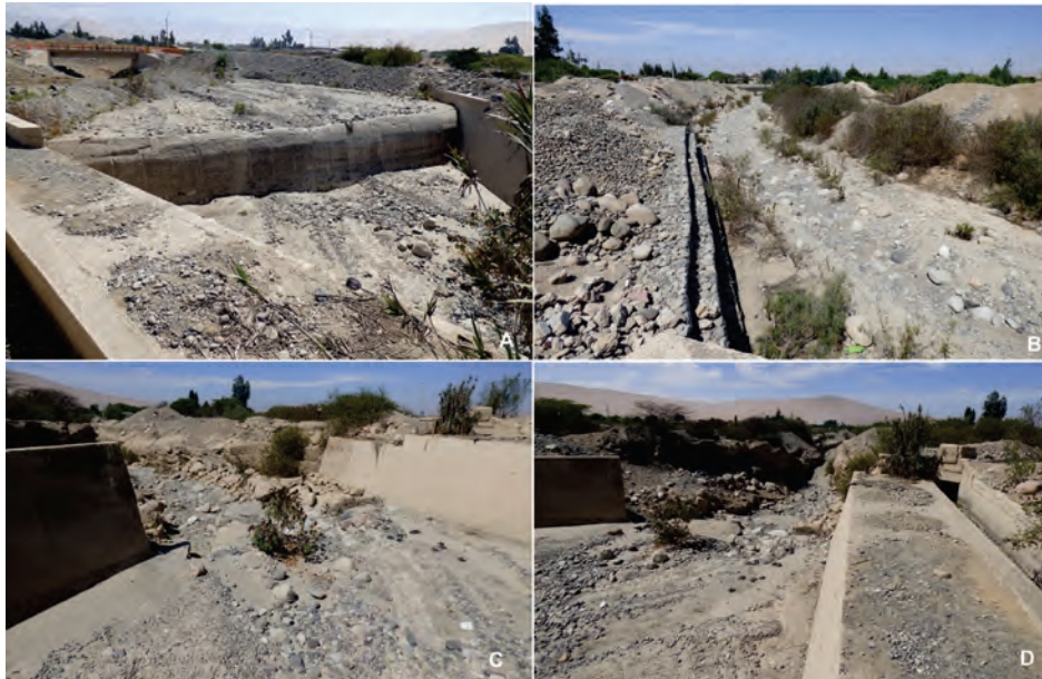
Figura 7.34 Erosión fluvial en ambas márgenes del desvío del río Uchusuma, sector 06 de Julio; se aprecian estructuras de encauzamiento con muros de concreto (A, C y D) y gaviones (B).
