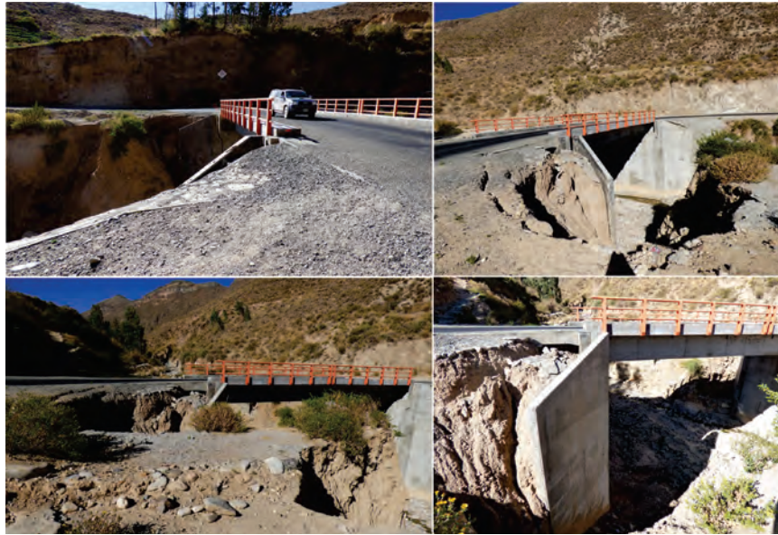
Figura 7.42 Zona de huaicos periódicos en el río Salla Cotacuchu (km 98+750 de la carretera Tarata-Ticaco), por dinámica fluvial erosionó estribos de puente de 30 m, el cual se encuentra a punto de colapsar.
