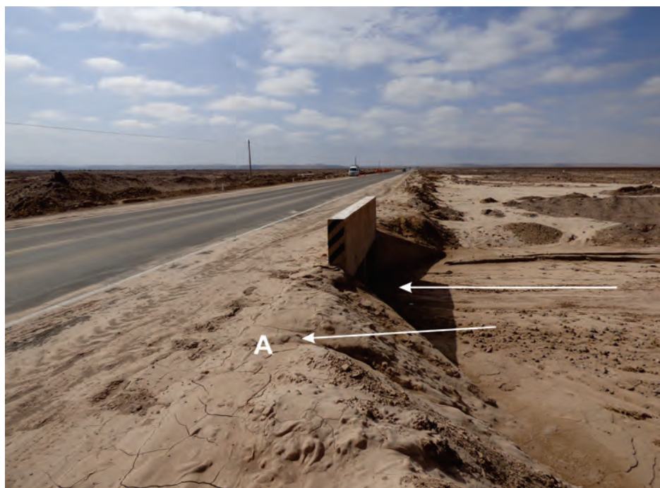
Figura 6.10 Flujo de lodo en el km 1274+140 de la carretera Panamericana Sur, límite entre los distritos Alto de la Alianza y Tacna, con vista al noroeste. Generalmente, los pontones tienen una luz insuficiente cuando se producen flujos excepcionales, obstruyéndose y desbordándose hacia la carretera (A), requiriendo ser descolmatadas periódicamente.
