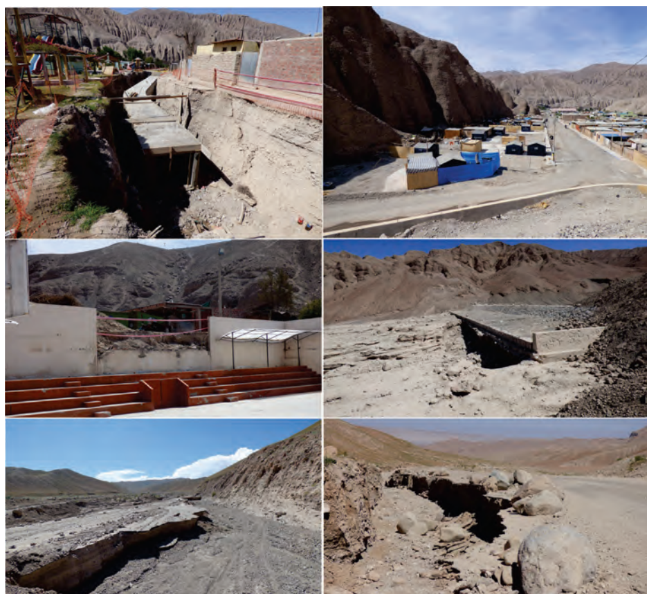
Figura 7.19 El huaico del 26/03/2015 afectó viviendas del poblado de Mirave pendiente abajo principalmente en la calle Toquepala y coliseo del poblado; socavó diques transversales, plataforma de carretera Mirave-Toquepala.
