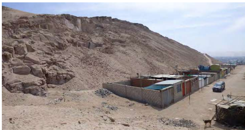
Fotografía 6.4 Caída de rocas en la Asociación de Vivienda La Florida, margen izquierda de la quebrada del Diablo, distrito de Tacna, con vista al este. Se distingue varias familias de discontinuidades en las rocas que generan roturas planares y en cuña.
