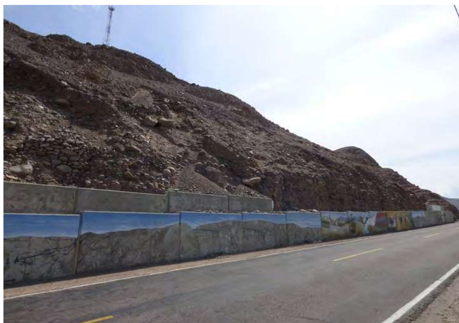
Fotografía 6.2 Derrumbes en talud superior de carretera Locumba-Mirave, sector Huancarane, distrito de Ilabaya, con vista al noreste. Se distingue muros de contención en el talud inferior de la carretera.
