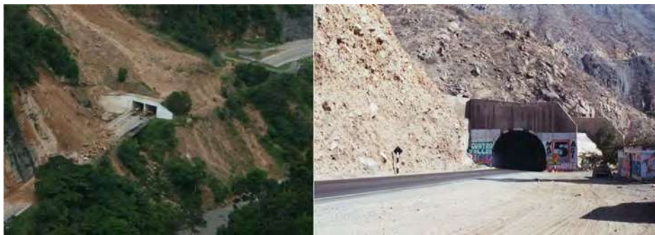
Figura 8.11 Túnel falso en la carretera Rafael Caldera Mérida (izquierda), Venezuela; carretera central Lima - La Oroya, Perú (derecha).
