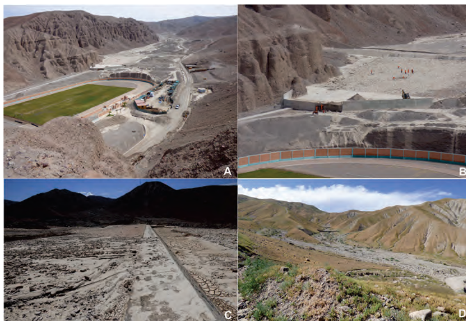
Figura 7.18 A) Vista panorámica de la quebrada Mirave; B y C) diques transversales colmatados con material del huaico del 26/03/2015; D) erosión en cárcavas en la parte alta de la quebrada Mirave que aportan material al cauce de la quebrada.
