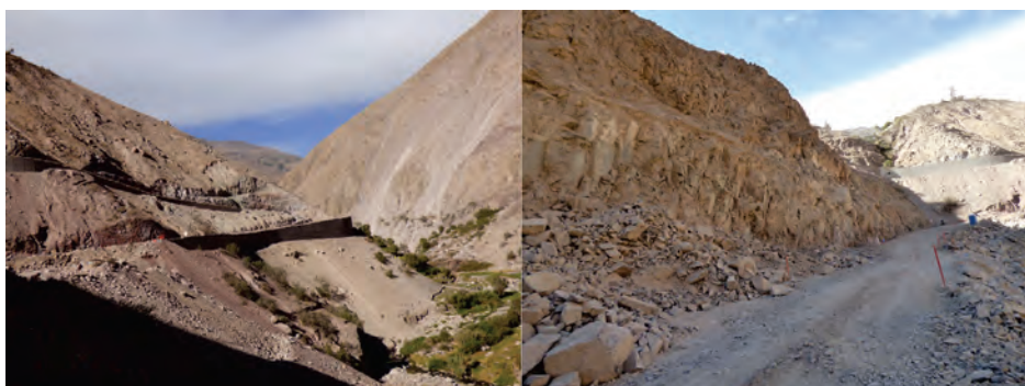
Figura 7.13 Derrumbes en el talud superior de la carretera Ilabaya-Candarave km 18+000 – km 24+000, sector Cambaya.
