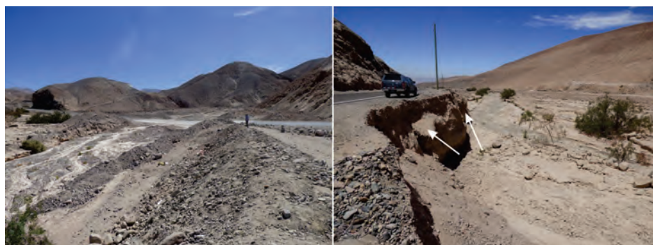
Figura 7.32 Baden en la quebrada Huintilla en la margen izquierda de la quebrada Chero, corta la carretera Tacna-Tarata (izquierda). Erosión de la plataforma de la carretera Tacna-Tarata (km 28+000- km 29+000) en la margen izquierda de la quebrada Molles, erosiona aproximadamente 1000 m.
