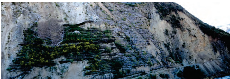
Fotografía 8.4 Ejemplo de evacuación de aguas superficiales y control de erosión en cárcavas, mediante trinchos escalonados.
