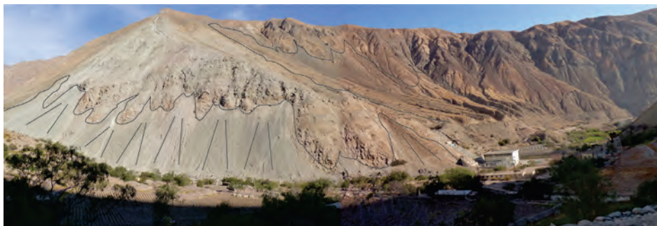
Figura 7.10 Vista panorámica de la Central Hidroeléctrica Aricota I, afectada por huaicos que descienden de las laderas del cerro donde se exponen depósitos coluvio-deluviales.
