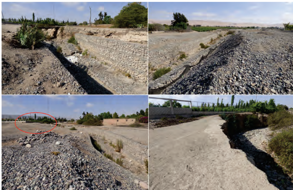
Figura 7.27 Erosión fluvial en la margen derecha del desvío del río Caplina, aguas abajo se han colocado gaviones en ambas márgenes, sector Piedra Blanca.
