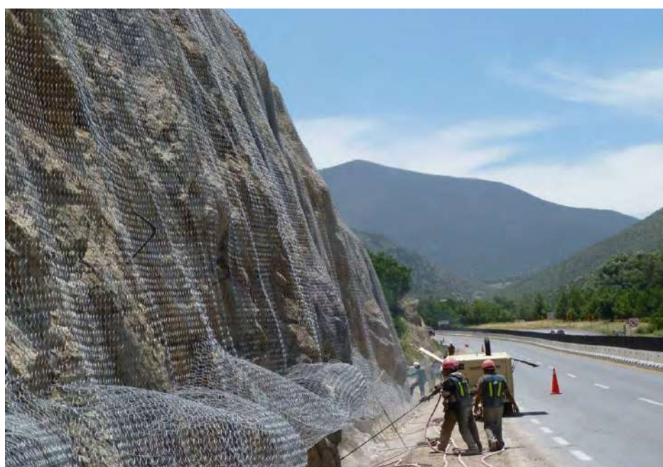
Fotografía 8.1 Mallas de protección con anclajes para caída de rocas o derrumbes tanto en detritos como roca alterada
