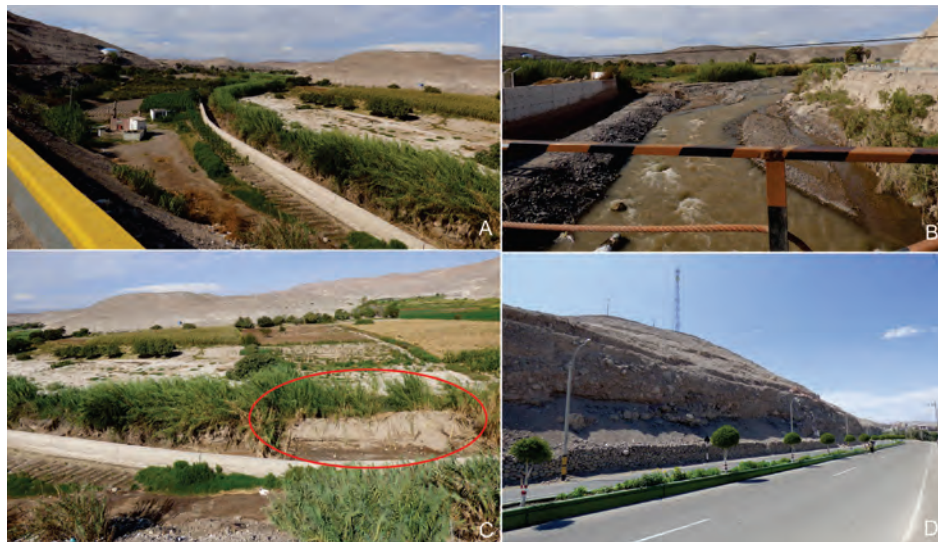
Figura 7.21 A) Muro de contención en la margen derecha del río Cinto cerca de la confluencia con el río Locumba; B) Área sujeta a inundación en la margen derecha del río Locumba; C) erosión fluvial en la margen izquierda del río Cinto; D) derrumbes en talud superior de carretera de acceso a Locumba.
