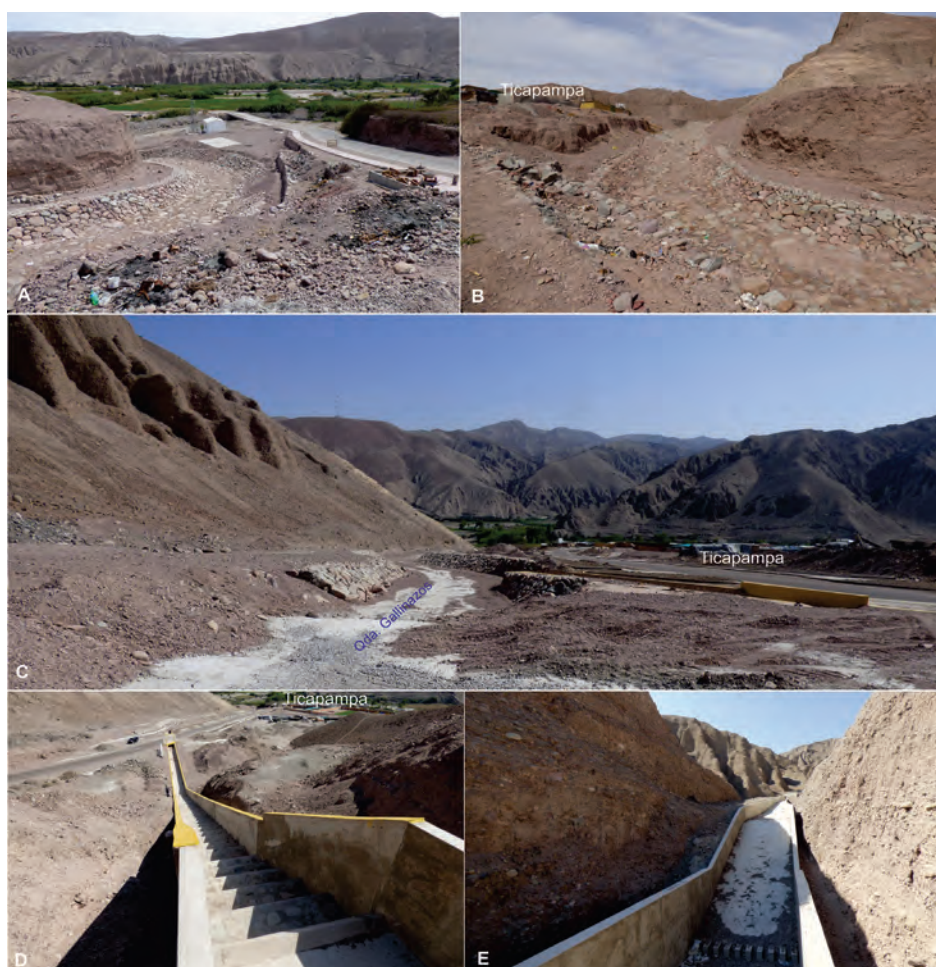
Figura 7.23 Vistas del sector Ticapampa, y canalización de la parte baja de la quebrada Gallinazos con mampostería de piedra (A, B y C) y con canales de concreto (D y E), poblado se encuentra en la margen derecha de esta quebrada.
