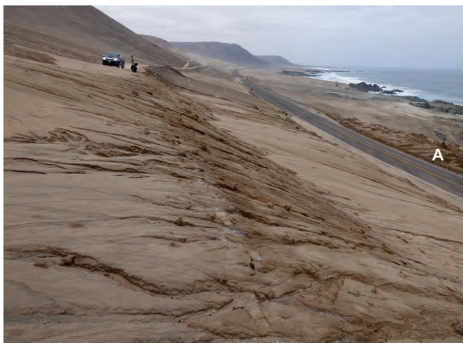
Figura 6.11 Flujos de lodo del 26 de marzo del 2015 que descienden del cerro Chero, cubriendo un tramo de la carretera Tacna-Ilo, km 59+000 - km 63+000, distrito de Sama, con vista al sureste. A un lado de la carretera se aprecia el material removido, luego de la limpieza efectuada en la carpeta asfáltica (A).
