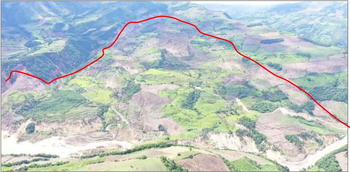
Figura 6. Vista panorámica del deslizamiento en Aserradero, margen izquierda de río Utcubamba.
