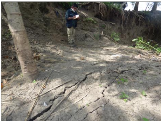
Fotografía 5. Se aprecia el escarpe principal y los agrietamientos del terreno
