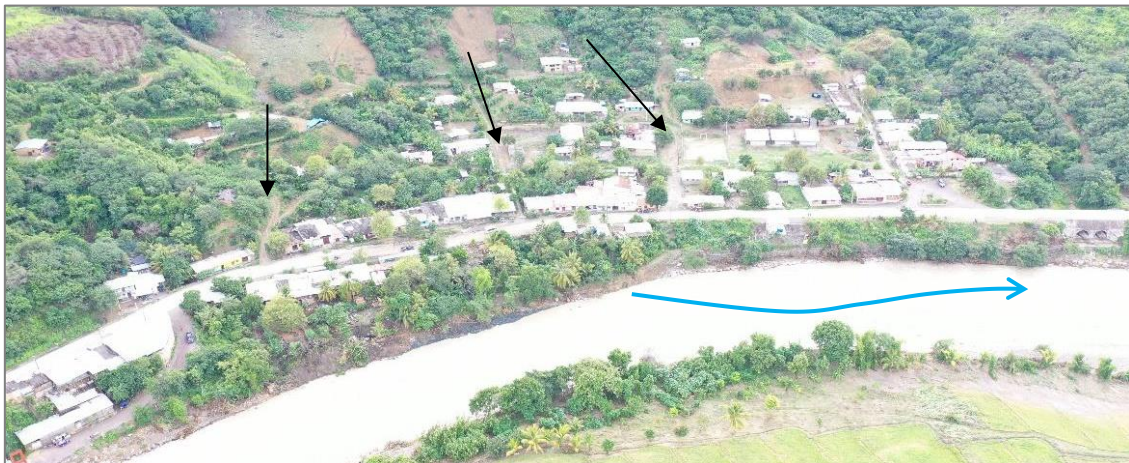
Figura 7. Caserío El Salao, afectado por deslizamiento e inundación.
