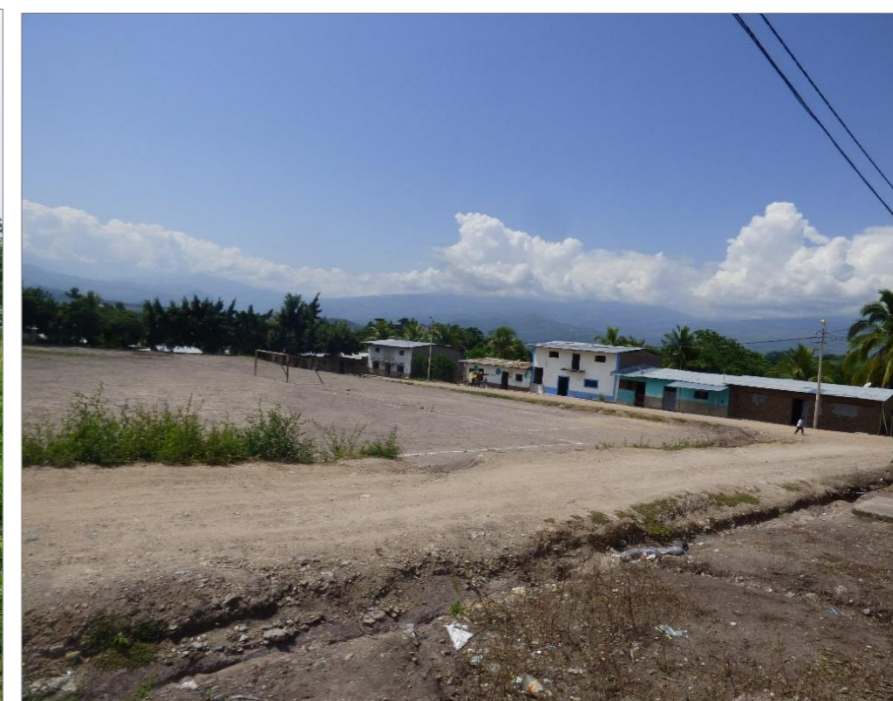
Fotografía 12. Drenaje pluvial que debe ser revestido, para evitar la infiltración de agua al subsuelo.
