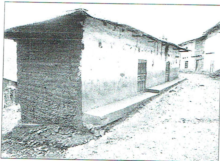
Figura 03: Vivienda constituida por adobe en muy mal estado de conservación.
