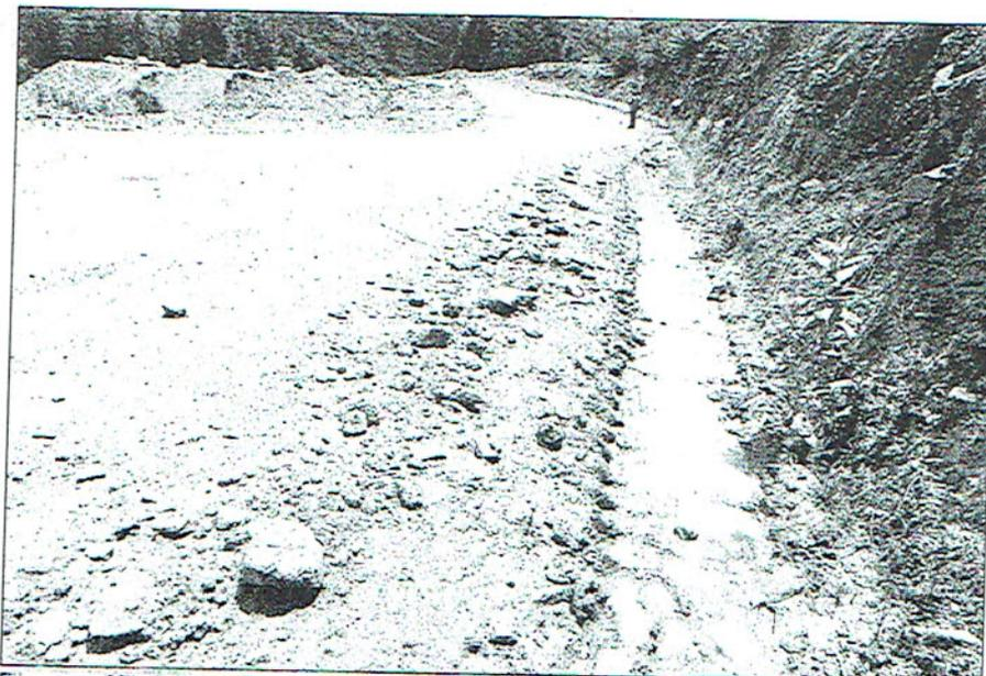
Figura 07: Vía afirmada que conecta Huánuco y Pasco expuesta al deslizamiento.
