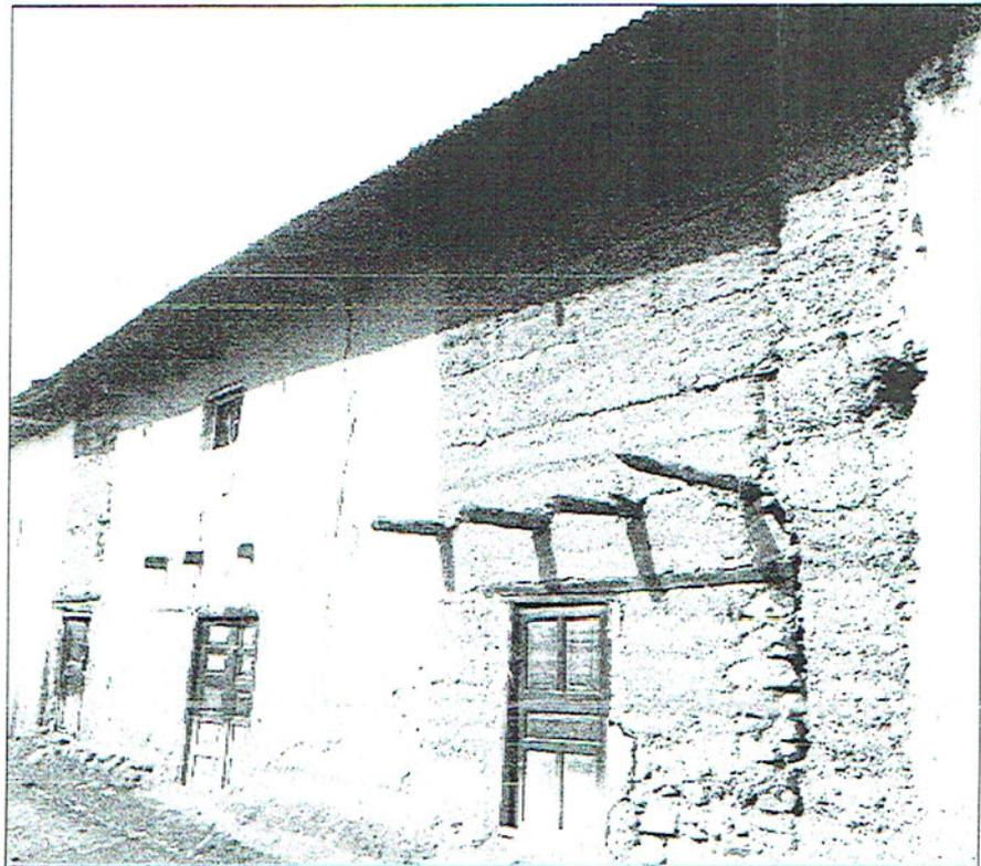
Figura 05: Aberturas superiores a los 10mms en los muros de las edificaciones expuestas.
