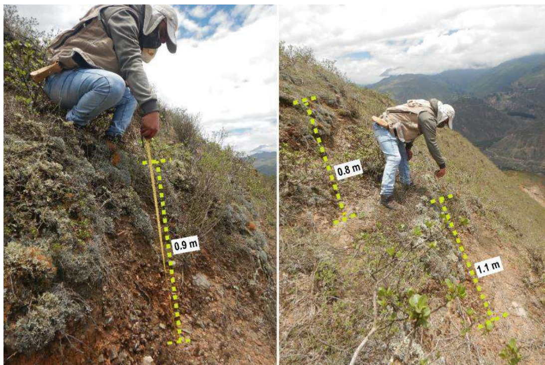
Figura 19. Vista de grietas de tracción paralelas a la corona del deslizamiento, con saltos verticales de 0.90 m a 1.1 m, que evidencian el avance retrogresivo del deslizamiento.
