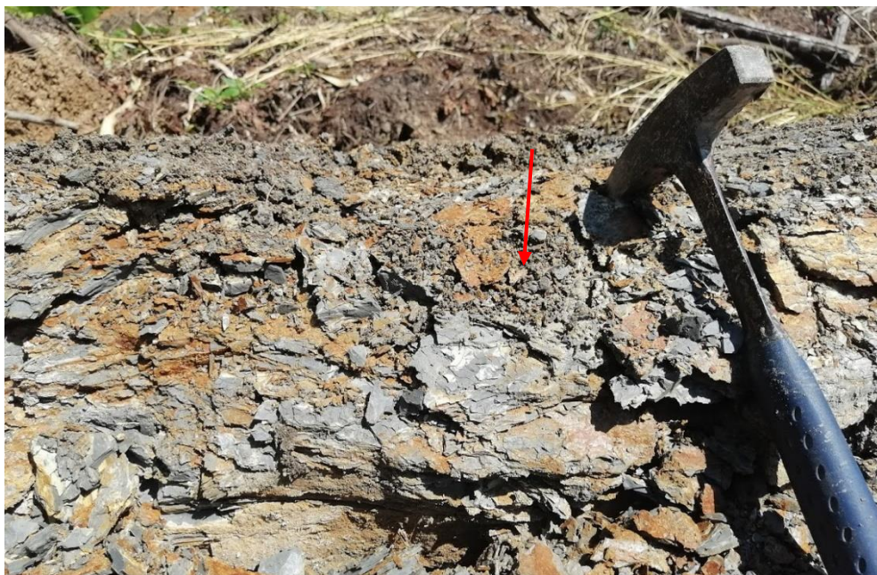
Figura 6: Lutitas grises fisibles ubicadas en la base del deslizamiento.
