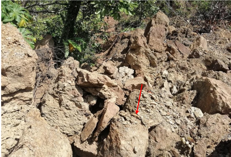
Figura 5: Escombros de margas, observados en la zona de arranque del deslizamiento.
