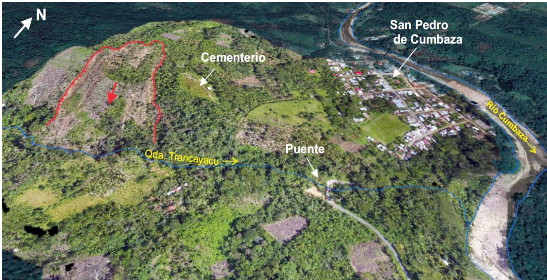
Figura 17: Vista en perspectiva del deslizamiento, la trayectoria de la quebrada Trancayacu, la ubicación del puente, cementerio y área urbana de la localidad de San Pedro de Cumbaza.
