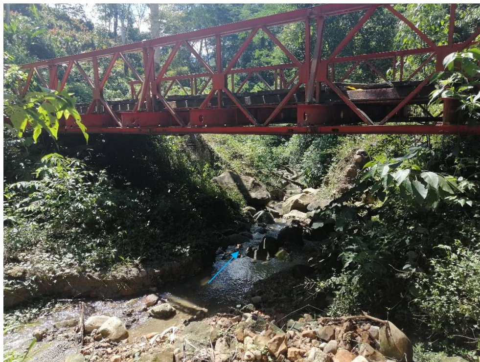
Figura 19: Lecho activo de la quebrada. Trancayacu.
