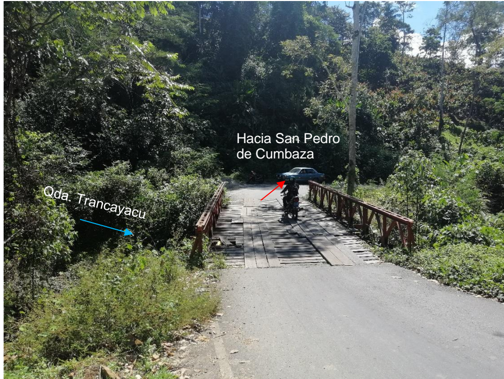
Figura 18: Puente de acceso a San Pedro de Cumbaza, sobre cauce de la quebrada Trancayacu.
