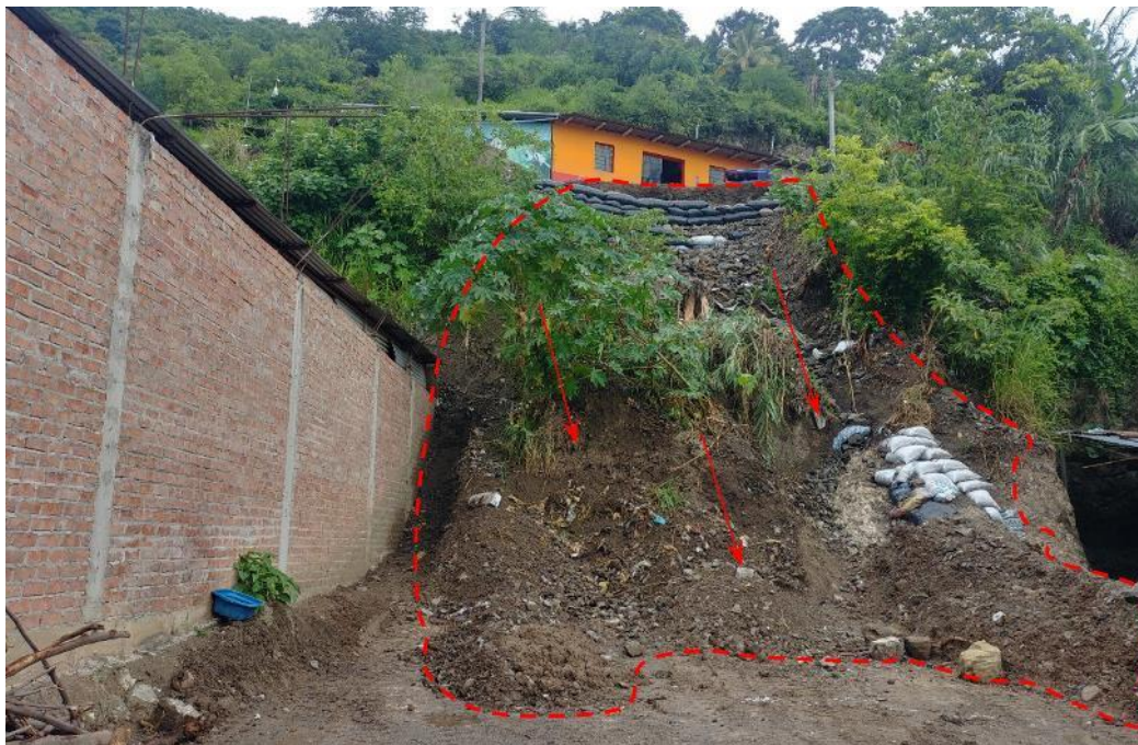
Figura 7. Derrumbe originado por el corte del talud con fines de construcción de vivienda. Coordenadas UTM WS-84 -17S, Norte: 9369429 – Este: 742002.
