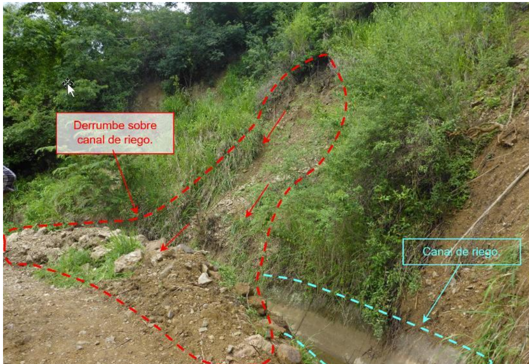
Figura 10. La denudación de los terrenos para la instalación de cultivos agrícolas, origina el proceso de erosión en las laderas. Coordenadas UTM WS-84 -17S, Norte: 9369339 – Este: 741856.
