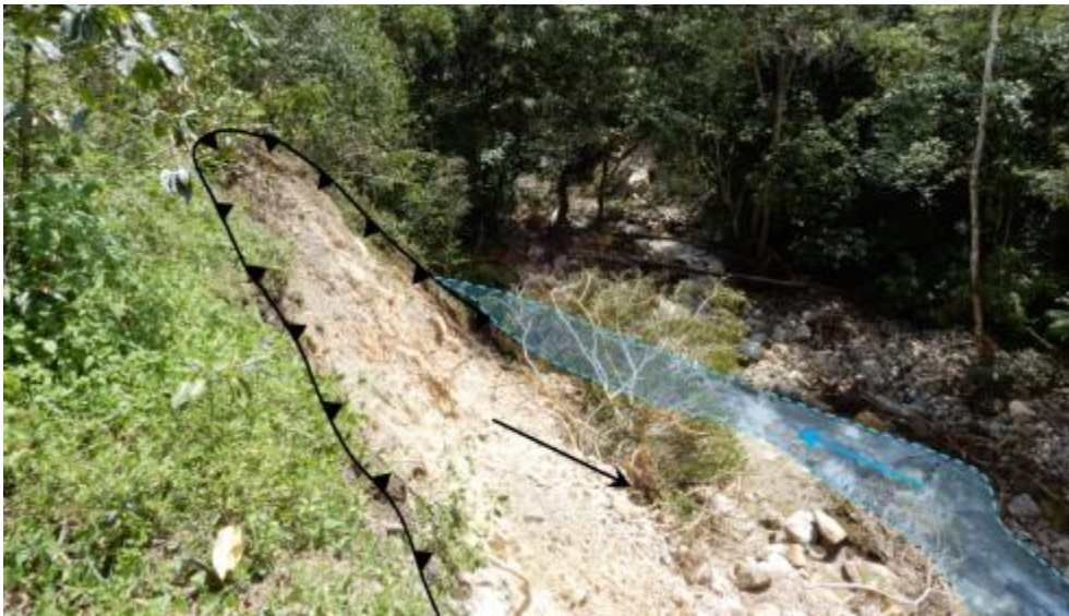
Figura 9. Deslizamientos de material coluvio – deluvial, con dirección hacia el cauce de la Quebrada.
