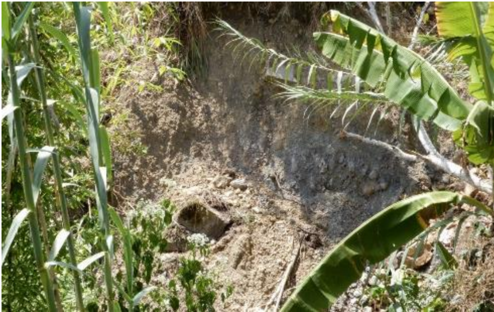
Fotografía 2. Depósito coluvio-deluvial, compuesto por gravas y bloques heterométricos (55%), envueltos en una matriz areno limosa (45%). Coordenadas UTM 171977 E – 9336472 N (WGS-84).
