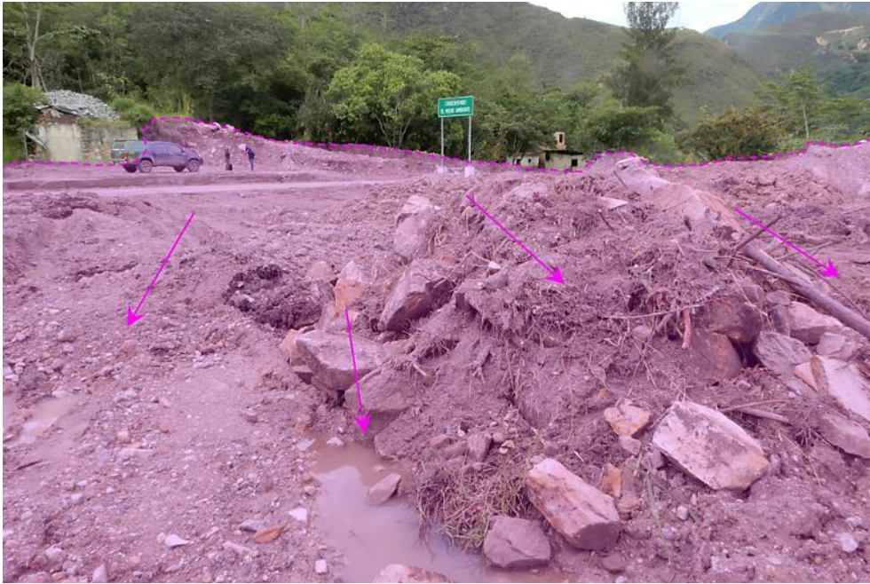
Figura 12. Zona baja del anexo Donce, donde la llegada del flujo de detritos forma un abanico y origina daños en viviendas, y carretera asfaltada.
