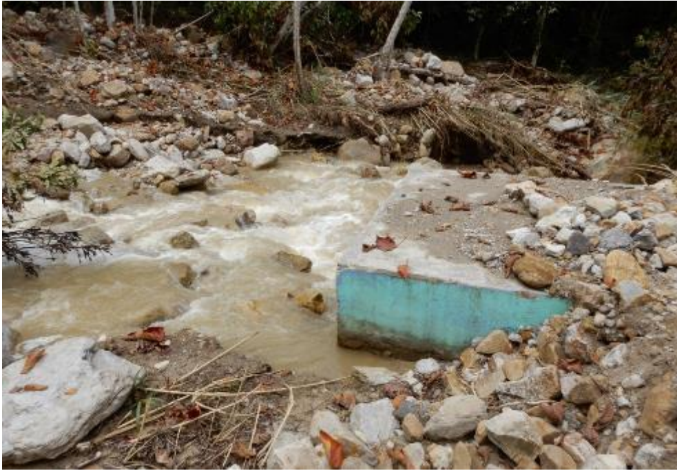
Fotografía 5. Infraestructura de captación y potabilización de agua, colapsado.
