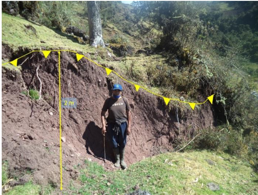
Figura 7. Se aprecia el escarpe del deslizamiento (coordenadas UTM: 722617 E; 8551292 N).
