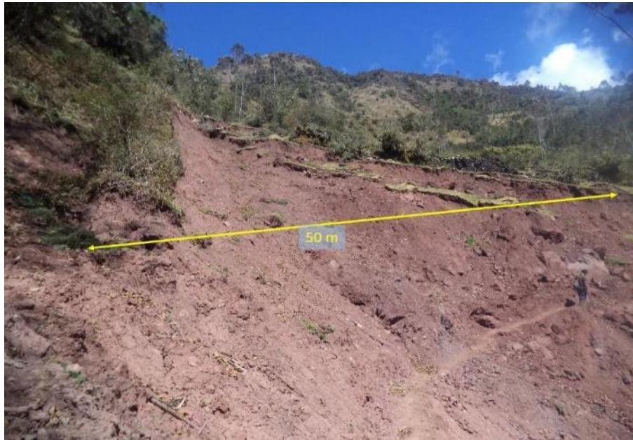
Figura 8. Se aprecia la reactivación del deslizamiento con ancho de 50 m y una altura de 160 m (coordenadas UTM: 722657 E; 8551319 N).
