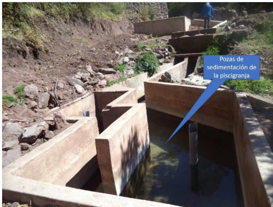
Figura 6. Se aprecia las pozas de sedimentación utilizadas por la piscigranja, las que fueron dañadas por la entrada del flujo de detritos.
