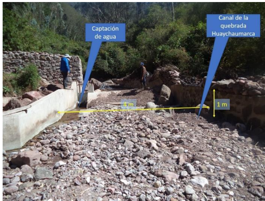
Figura 11. Se aprecia la canalización del río con sus medidas y la captación de agua para la piscigranja municipal (coordenadas UTM: 723481 E; 8551451 N).
