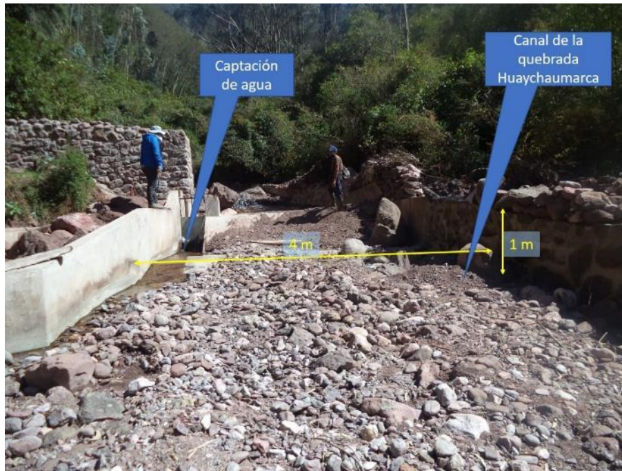
Figura 5. Se aprecia la canalización del cauce del río y la toma de agua para la piscigranja, los cuales fueron afectados por el flujo.
