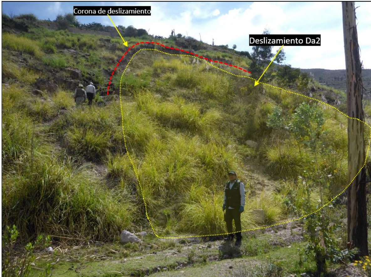
Figura 9. Deslizamiento Da2 en Yalagua, (coordenadas UTM WGS84: 312438E, 8199194N)
