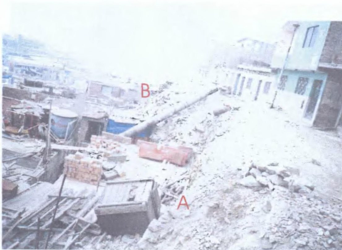
FOTO N° 11: Vista del Pasaje Alfonso Ugarte en el A.A.H.H 9 de Octubre, en donde se pueden ver los cortes (B) hechos en la ladera del cerro, para ubicar las viviendas y las pircas de sostenimiento (B).
