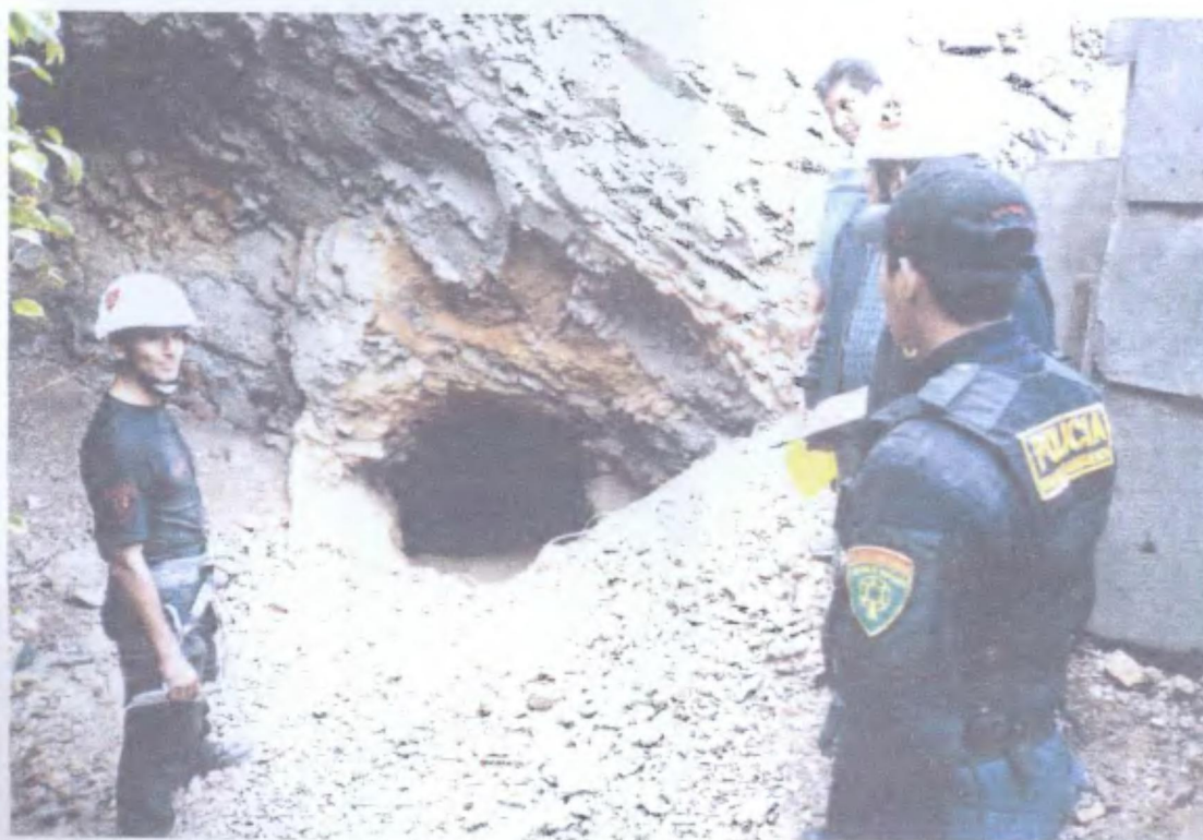
Foto N° 12: Vista de la entrada a un socavón en la urbanización Santa Mary entre los lotes 1 y 2 de la Mz A.
