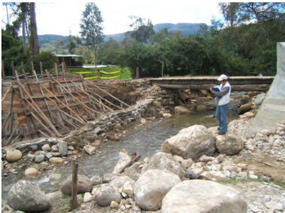
Foto 10.7.- Construcción de alcantarilla en el cauce del río Molino que podría colmatarse, represarse y generar huayco.
