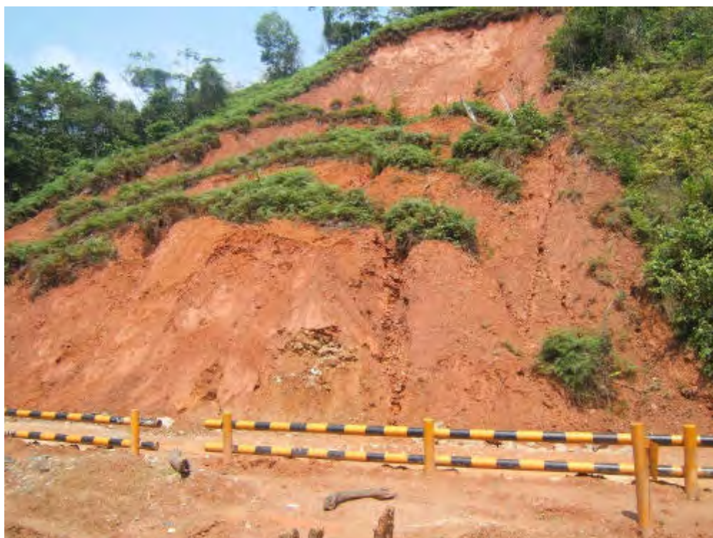
Foto 10.33.- Montenegro: Deslizamiento traslacional activo en el talud superior de la carretera.
