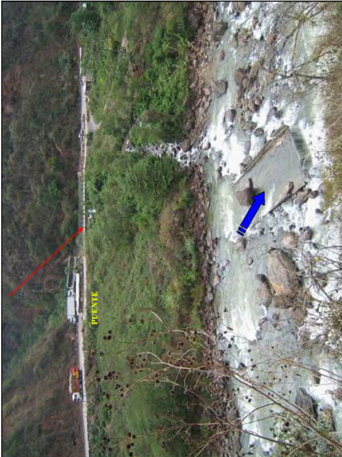
Foto 10.12.- Quebrada Tingo (carretera Fernando Belaunde Terry, kilómetro 278), área afectada por flujo de detritos. En el 2004 destruyó puente.
