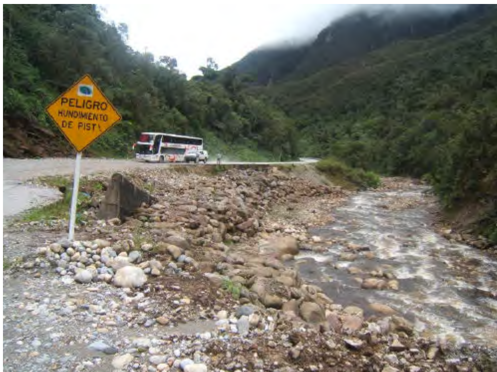
Foto 7.15.- Kilómetro 370 de la carretera Fernando Belaunde Terry, margen izquierda del río Nieva. Erosión fluvial que afectó la plataforma de la carretera.
