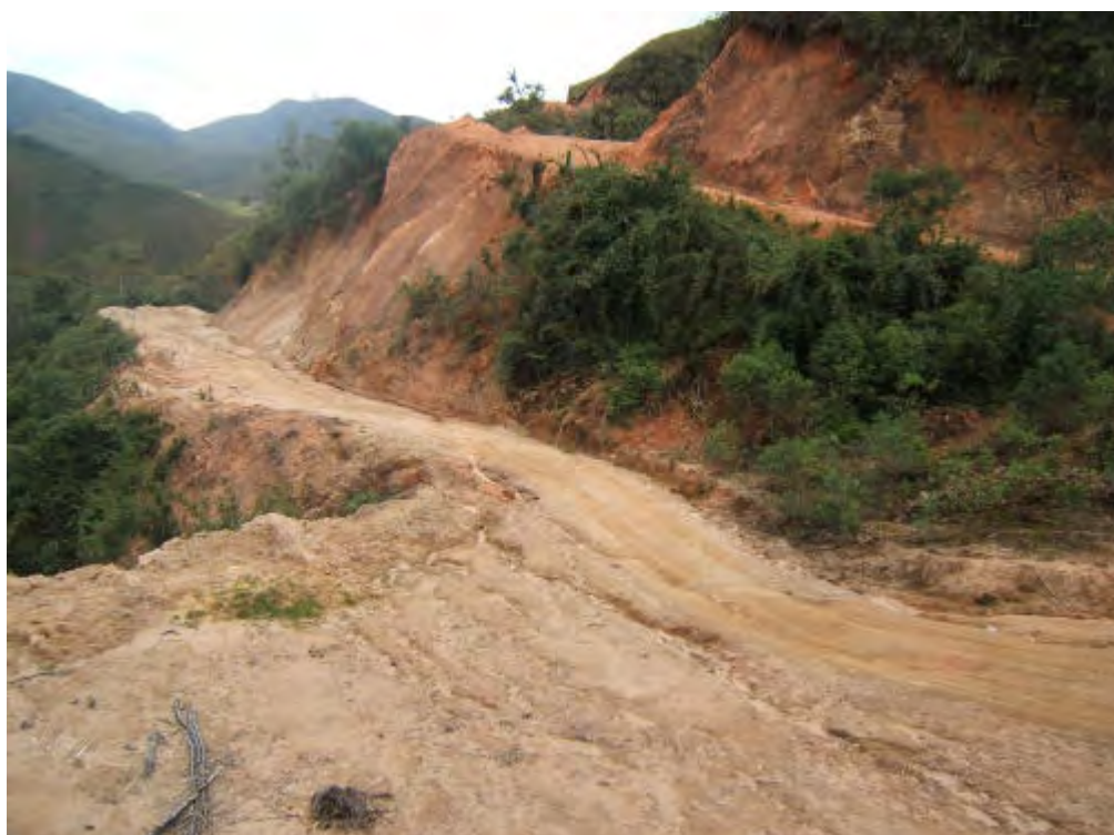
Foto 10.10.- Derrumbes, erosión en surco y pequeños deslizamientos que afectan la carretera de acceso al valle turístico de Huaylla Belén.
