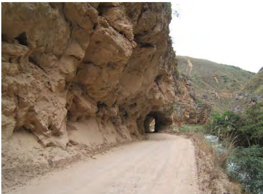
Foto 10.6.- Talud rocoso muy escarpado y ligeramente fracturado, sector El Túnel, margen derecha del río Utcubamba.
