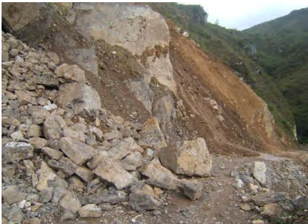
Foto 7.1.- Caída de rocas, derrumbes y pequeños huaycos que afectan la carretera entre los distritos de Maino y Levanto, en la margen derecha del río Osmal.
