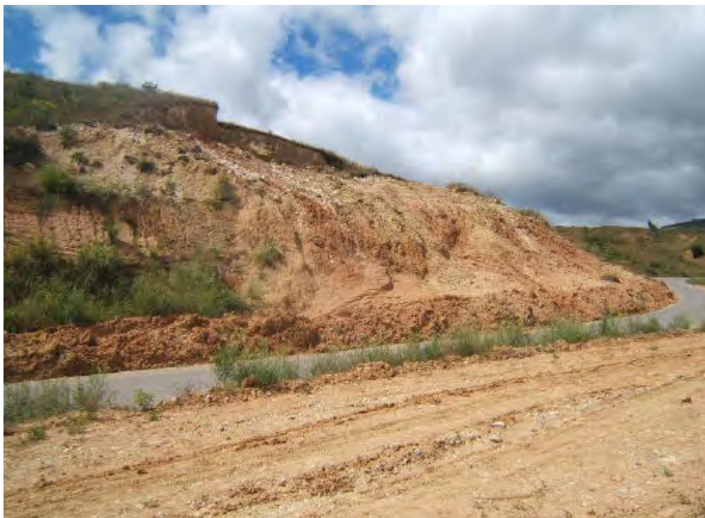
Foto 10.4.- Deslizamiento-flujo ubicado en la ruta de acceso a la ciudad de Chachapoyas, tramo del desvío Leimebamba-Chachapoyas.
