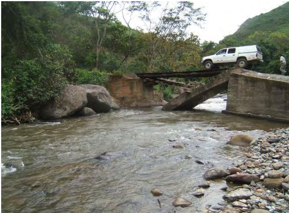
Foto 10.17.- Pontón afectado por flujo de detritos y erosión fluvial en la quebrada Palaguas.
