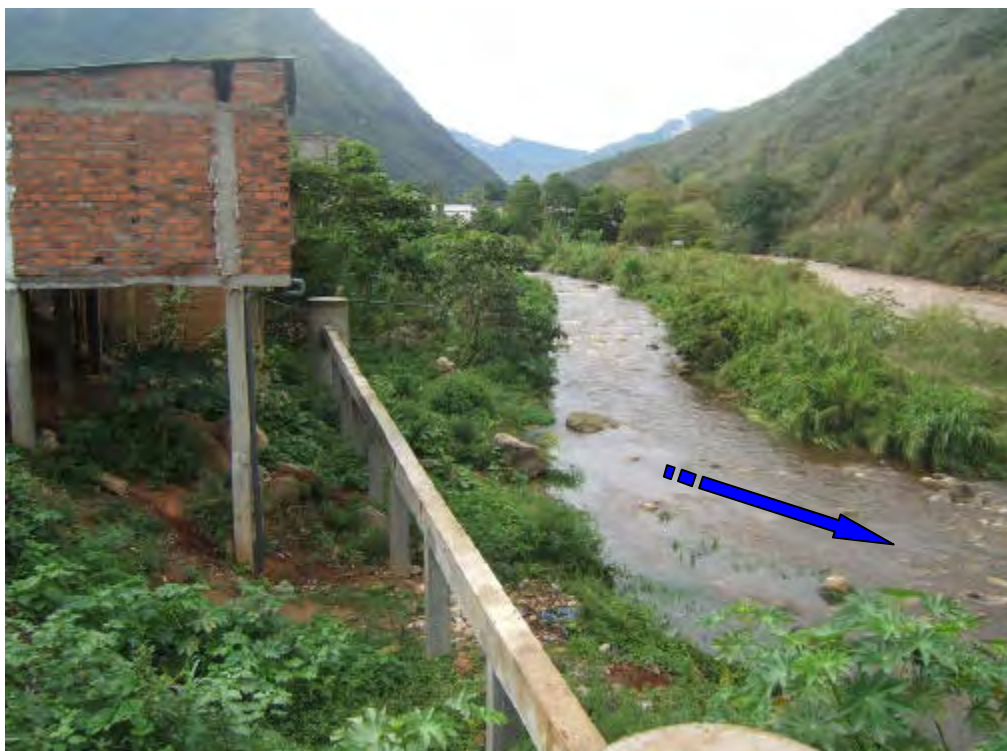
Foto 10.13.- Pedro Ruiz, ocurrencia de erosión fluvial en la margen derecha del río Utcubamba. También podría ser afectada por inundaciones.
