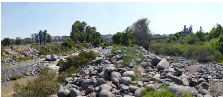
Fotografía 5.30 Vista con dirección hacia el norte, aguas arriba del río Chili cerca a la confluencia de la quebrada Venezuela, donde se puede ver en el centro de la imagen el muro de encauzamiento formado con la acumulación de material aluvial del mismo cauce del río; distrito de Arequipa.
