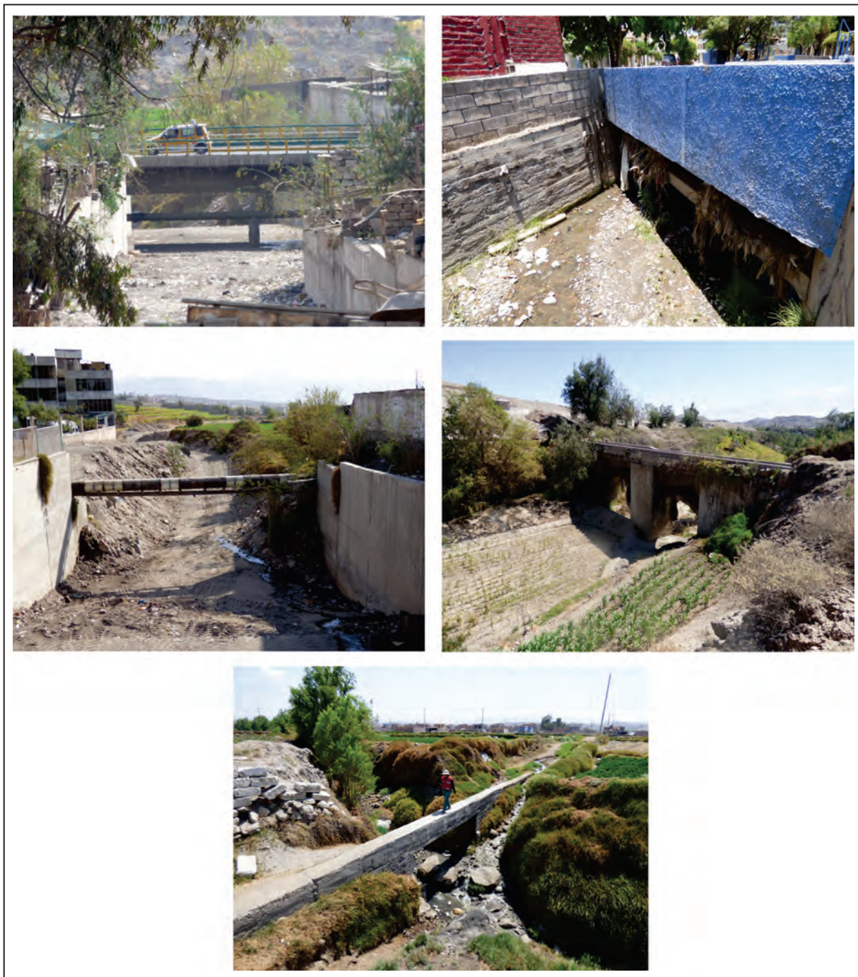
Figura 8.33 Vista donde se puede observar tuberías de desagüe que cruzan las quebradas por debajo de puentes, constituyéndose en retenes de material sólido que provocan desbordes e inundaciones. También se puede observar acueductos que cruzan cuyos pilares reducen la sección de drenaje de las quebradas.
