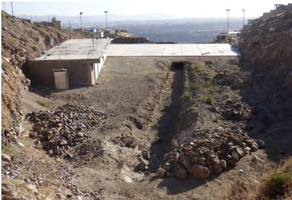
Fotografía 6.7 Local comunal y loza deportiva de la Asociación de Vivienda San Luis Gonzaga, del distrito de Alto Selva Alegre-Zona A, construida en el mismo cauce de la quebrada San Lázaro (cuenca Alta). Vista hacia el suroeste.
