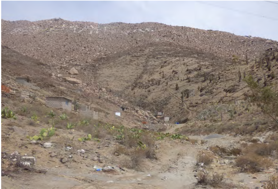
Fotografía 6.15 Quebrada seca de corto recorrido en cuyo cono proluvial y laderas con bloques sueltos, viene siendo ocupado por las viviendas de la Asociación de Viviendas La Rinconada, distrito Jacobo Hunter. Vista con dirección hacia el suroeste.
