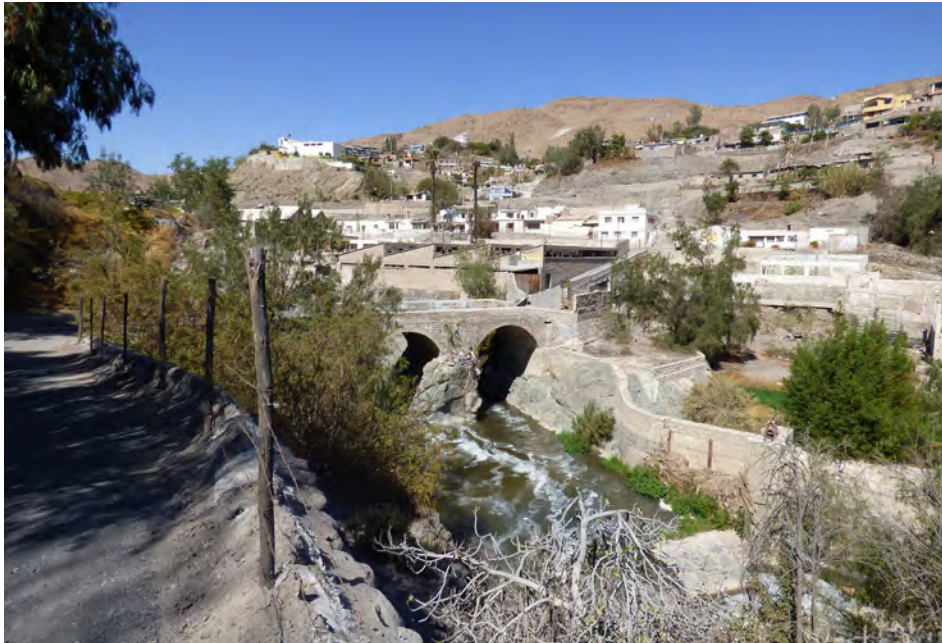
Fotografía 5.20 Vista del río Chili donde se puede ver un afloramiento intrusivo gabrodiorítico en medio del cauce a manera de isla, la cual ha sido usada para colocar un pilar del puente que cruza el río.
