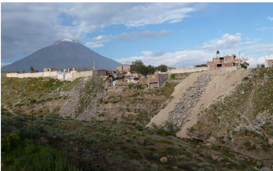
Fotografía 6.6 Desmonte arrojado en la margen izquierda de la quebrada Pastoras. Vista hacia el noreste.
