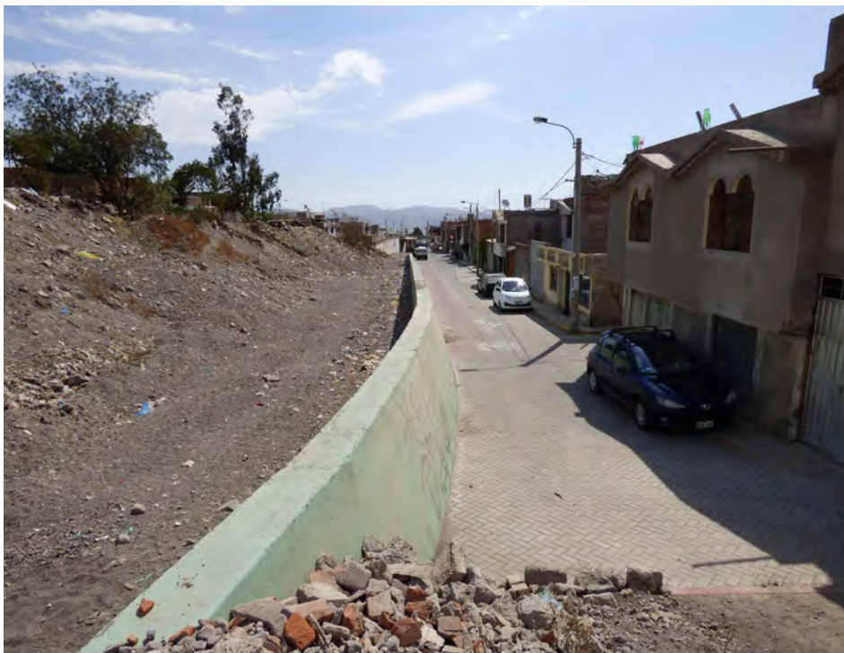
Fotografía 6.13 Vista aguas abajo de quebrada encauzada en la calle Torrentera (punto de control n° 624), se observa el muro de concreto y el desnivel existente entre la calle y el lecho de la quebrada. Vista con dirección hacia el suroeste.
