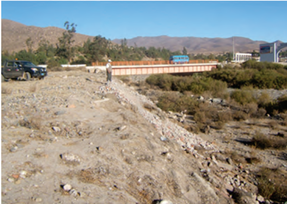
Fotografía 6.20 Río Yarabamba. Botadero de desmonte en la margen derecha que estrecha su cauce.
