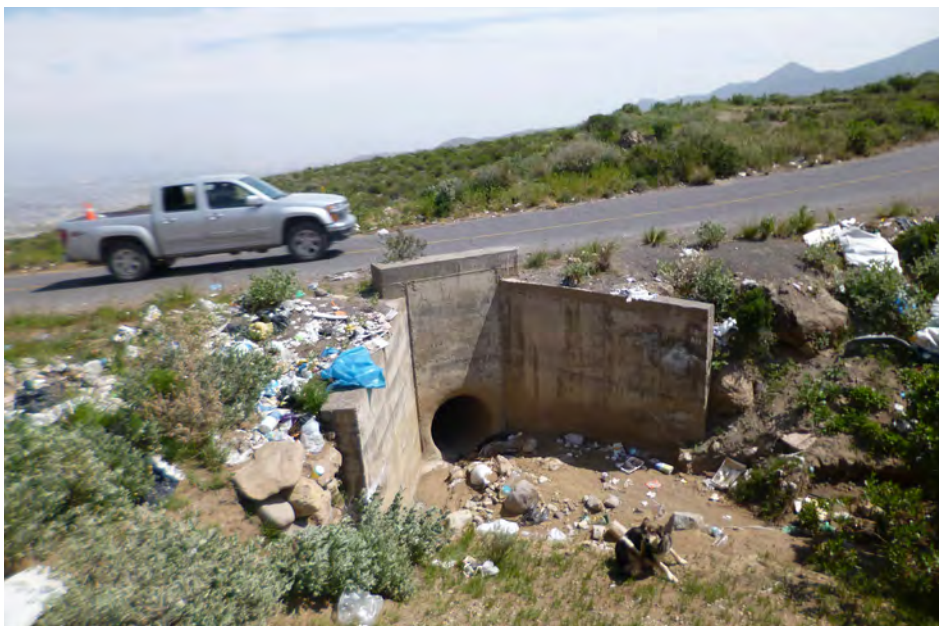
Fotografía 6.1 Vista de alcantarillas colocadas en la carretera que sube por el sector de Cabrería en el distrito de Cayma. Vista hacia el suroeste.
