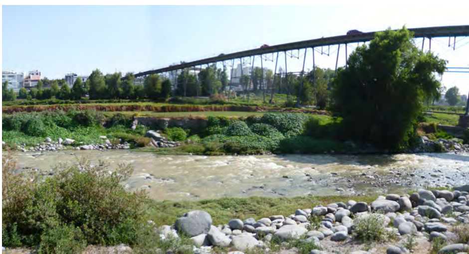
Fotografía 5.15 Vista con dirección al oeste de la margen derecha del río Chili, sector de Vallecito, donde es posible ver hasta tres niveles de terrazas aluviales.
