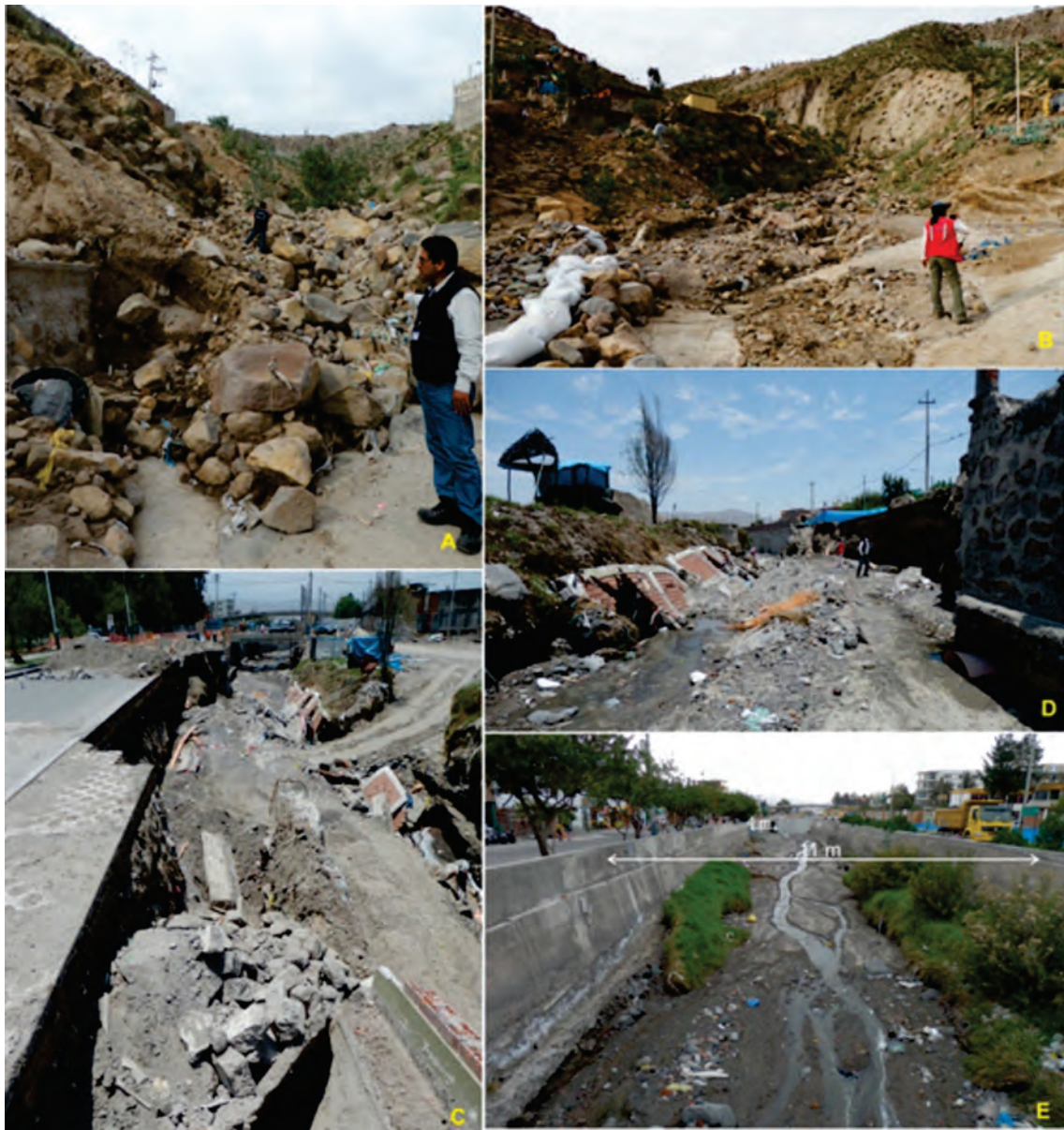
Figura 6.34 a y b) las cabeceras de las torrenteras se encuentran afectadas por deslizamientos y flujos; además, los cauces se encuentran colmatados de material, sector La Rinconada, distrito Mariano Melgar; c y d) presenta erosión de la vía asfaltada en la Av. Venezuela, a la altura del mercado Mariscal Castilla, debido al socavamiento de los cimientos de muros de sillar, llegaron a colapsar; e) av. Los Incas y Agricultura (altura de la Gerencia Regional de Salud); estrechamiento del cauce por obras del by pass , de 13 a 4 m de ancho, con muros de contención de 4.5 m de alto.
