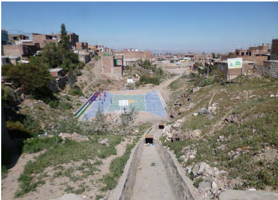
Fotografía 5.18 Vista con dirección suroeste donde se puede observar una quebrada seca la cual ha sido antropogenizada, se ha construido una loza deportiva en el mismo cauce, dejándose una alcantarilla para que discurra el agua que se concentra durante los periodos de lluvia.
