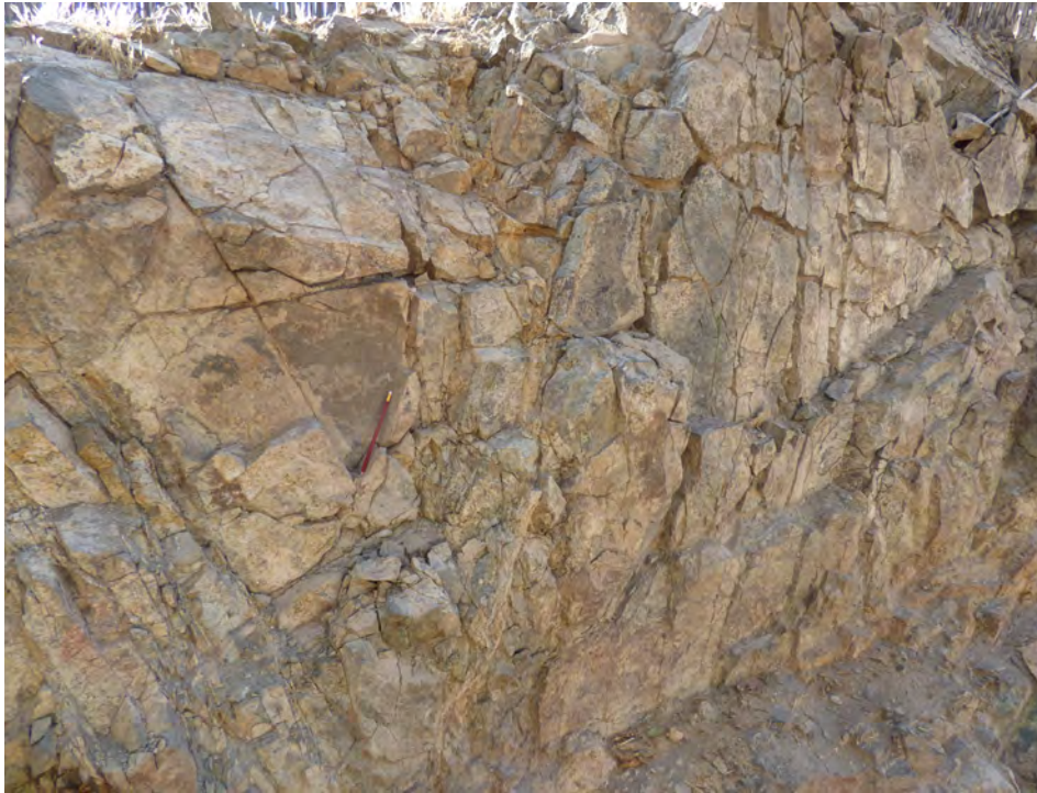
Fotografía 3.12 Vista en la que se puede observar un gabro muy fracturado y ligeramente alterado, ubicado en un afloramiento reducido localizado en la margen derecha de la quebrada Río Seco, cerca del peaje de Uchumayo.
