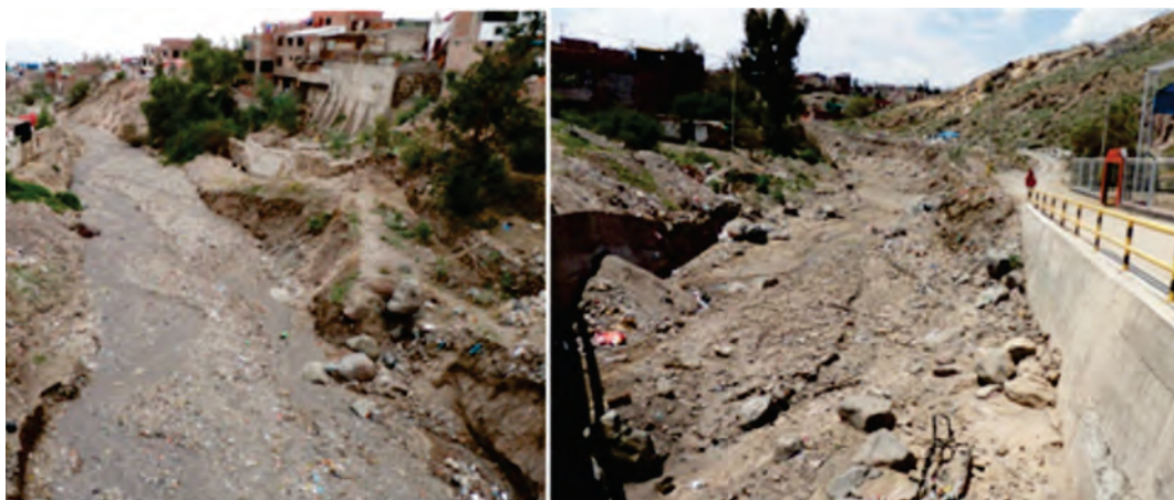
Figura 6.29 Flujo de detritos en la torrentera y derrumbes en ambas márgenes de la torrentera, cabecera de la torrentera Venezuela, sector San Juan XXIII, confluencia de ramal I y II.
