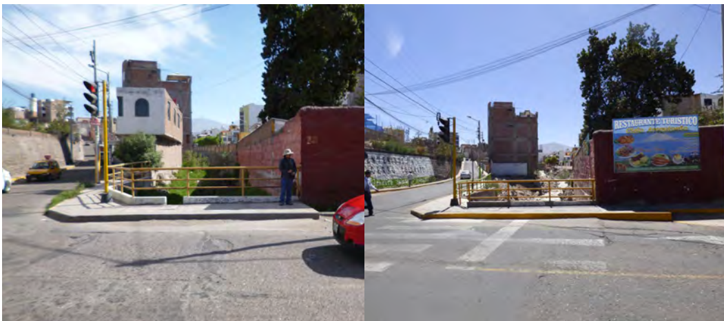
Fotografía 6.18 y 6.19 Vista del mismo sector de la quebrada Chullo, encauzada con muros de concreto y viviendas, localizada en el cruce de las avenidas Pancho Fierro y Arequipa, tomadas con una diferencia temporal de 16 meses, donde es posible ver la intensidad de la erosión producida con la crecida de la quebrada en la temporada de lluvias del año 2016; se produjo la destrucción de una vivienda en la margen derecha, destrucción de muro de ladrillos en la margen izquierda y socavamiento de las bases de otra vivienda de cuatro pisos.
