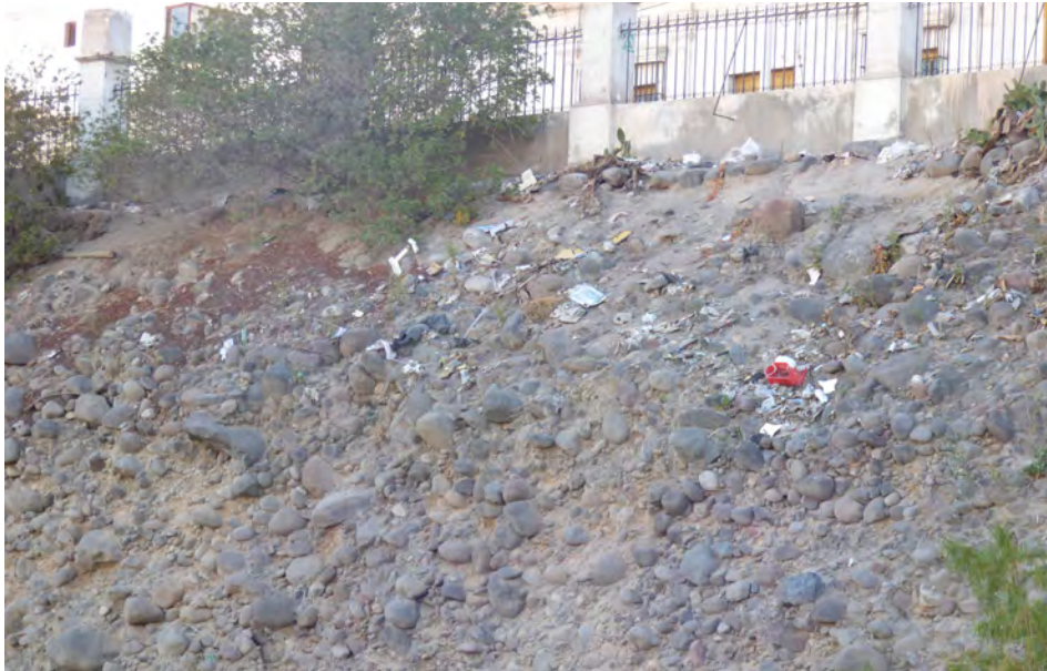
Fotografía 3.4 Vista del acantilado de la margen derecha del río Chili entre los Puentes Quiñones y Bolognesi, se puede observar los materiales gruesos (gravas y bolos) acumulados por un antiguo flujo de detritos (lahar histórico del Misti).
