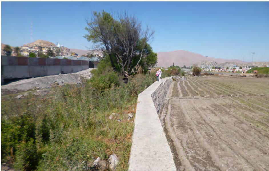
Fotografía 5.31 Vista con dirección hacia el suroeste, donde se puede observar un dique de concreto y mampostería colocada para encauzar el río Chili y proteger terrenos de cultivo de la margen derecha; distrito de Sachaca.
