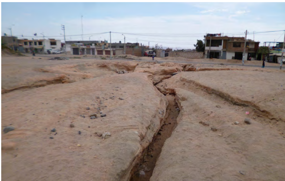
Fotografía 5.21 Vista en la que se puede observar las cárcavas formadas por escorrentía superficial concentrada que corta las ignimbritas rosadas; sector avenida 1 (antigua carretera a Yura), distrito Cerro Colorado.
