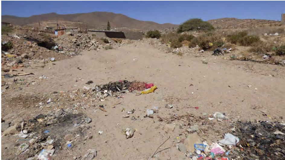
Fotografía 6.17 Vista aguas arriba de la quebrada Churumpaya, en donde las viviendas se vienen construyendo dentro del cauce de esta. Vista con dirección al este.
