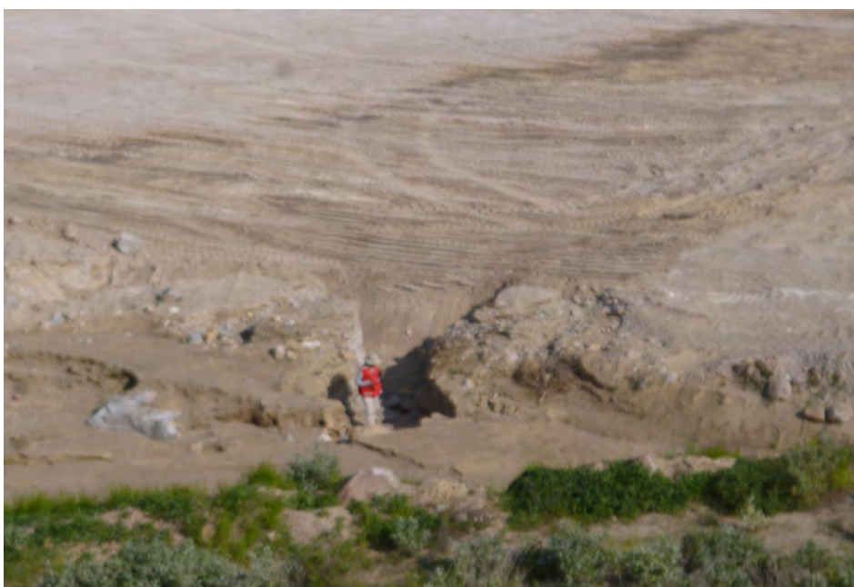
Fotografía 6.2 Quebrada del Fundo Cabrería cuyo cauce ha sido borrado por la explanación del terreno, para habilitar una nueva urbanización de viviendas. Vista hacia el suroeste.
