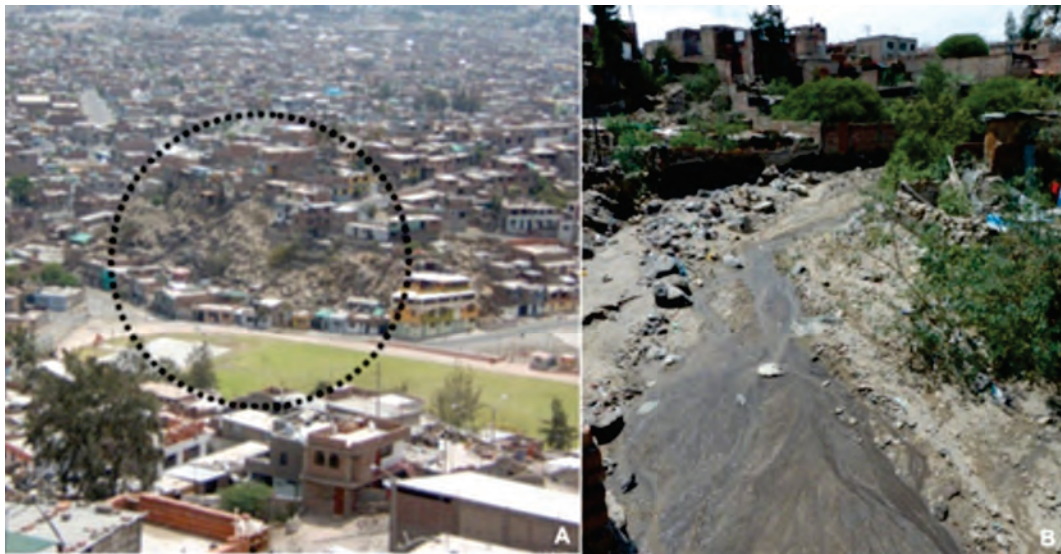
Figura 6.28 a) caída de rocas en el puente Arnao Tahuantinsuyo; b) fuerte erosión y colapso de muros de viviendas dentro del cauce de la torrentera, puente Arnao.
