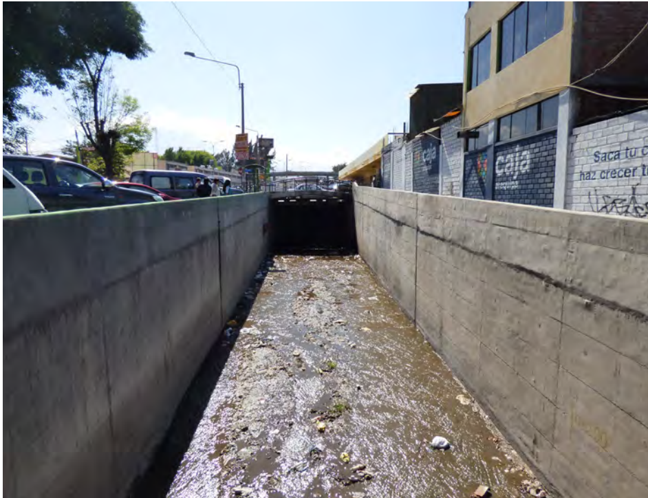
Fotografía 6.9 Cauce techado o "canal cubierto" de la quebrada Venezuela.
