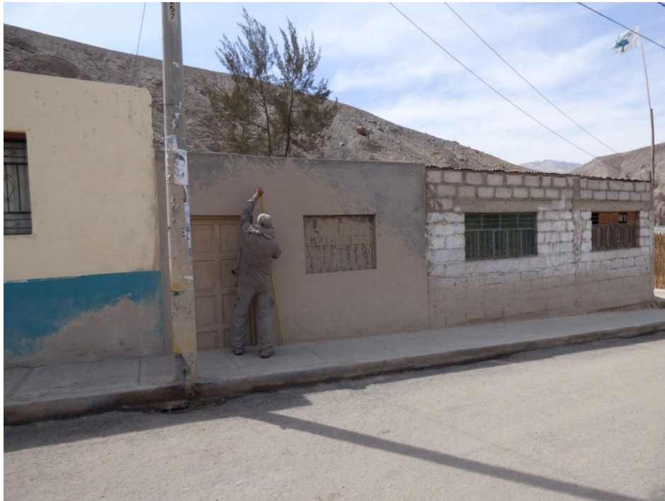
Foto 11. Vivienda afectada por flujo de detritos
