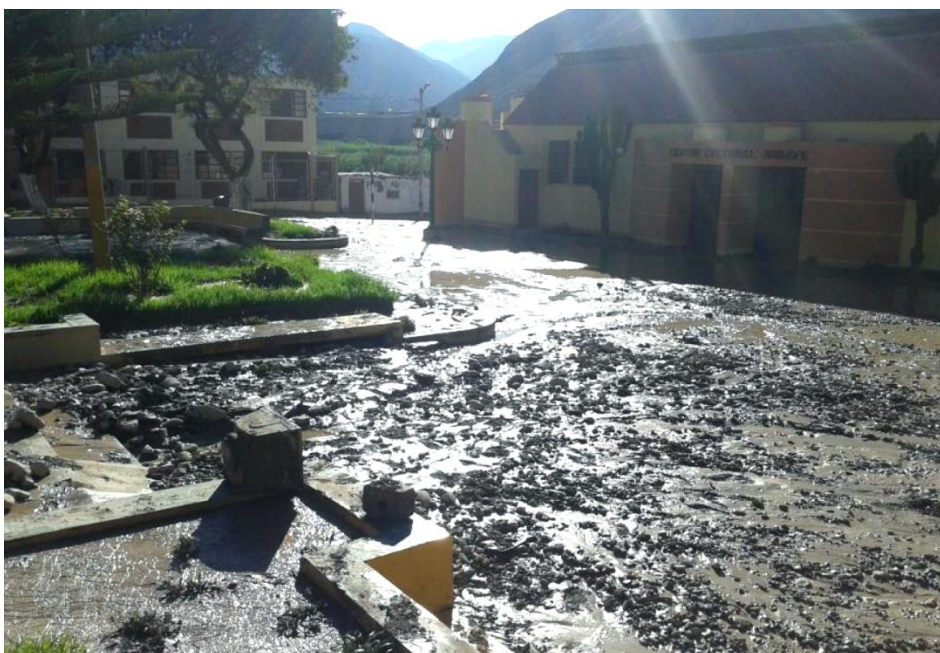
Foto 12. Plaza principal de Mirave afectada por flujos recientes. Fuente: INDECI.
