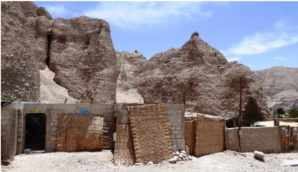
Foto 16. Viviendas ubicadas al pie de los acantilados.
