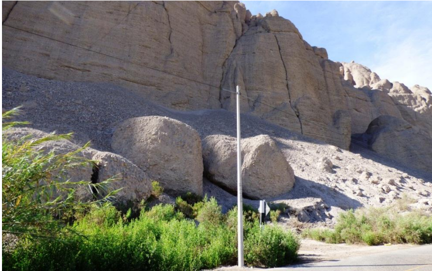
Foto 15. Ejemplo de derrumbes que ocurren en la zona de Mirave.
