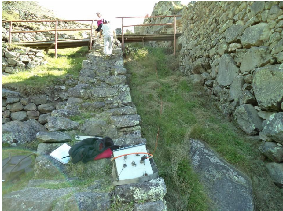
Foto N°10: Vista de la falla mapeada interceptando con la LT-9.
