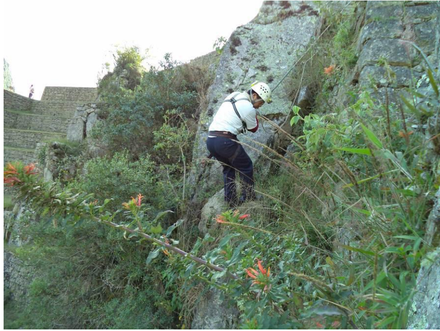
Foto N° 11: En la zona de Deslizamiento parte posterior del Intihuatana para la colocación de los electrodos finales de la línea LT-5, se tuvo que emplear el arnés de escalamiento.
