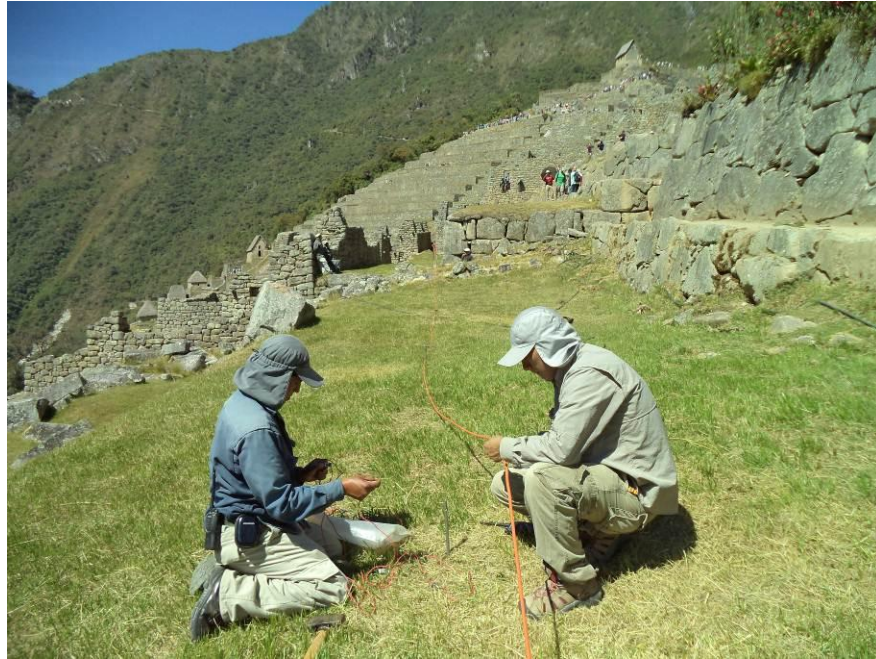
Foto N° 3: Equipo de apoyo instalando los 48 electrodos al cable multicanal principal para la línea LT-1.
