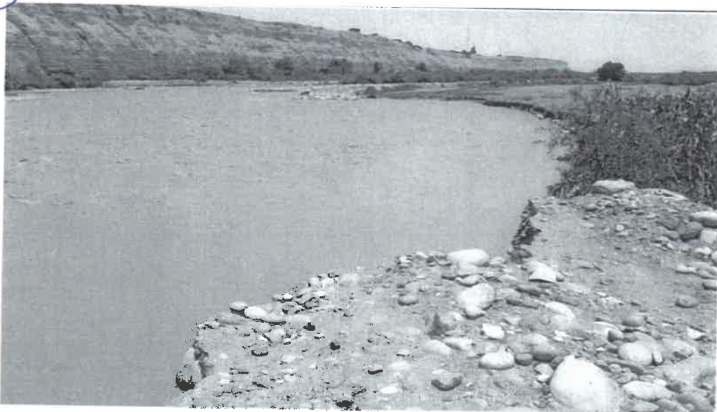
Imagen 5 : Sector crítico Dos Palmas Vista lateral
