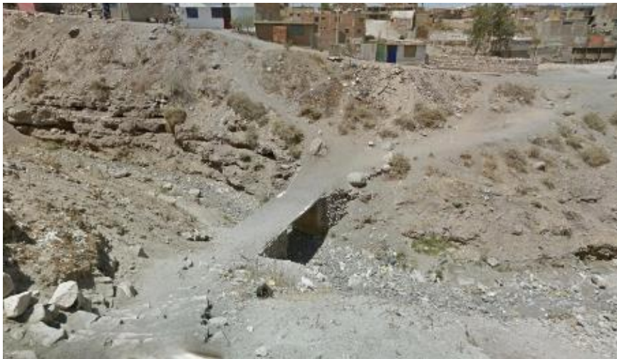
Figura 50. Puente sector medio, quebrada Pastoraíz.
