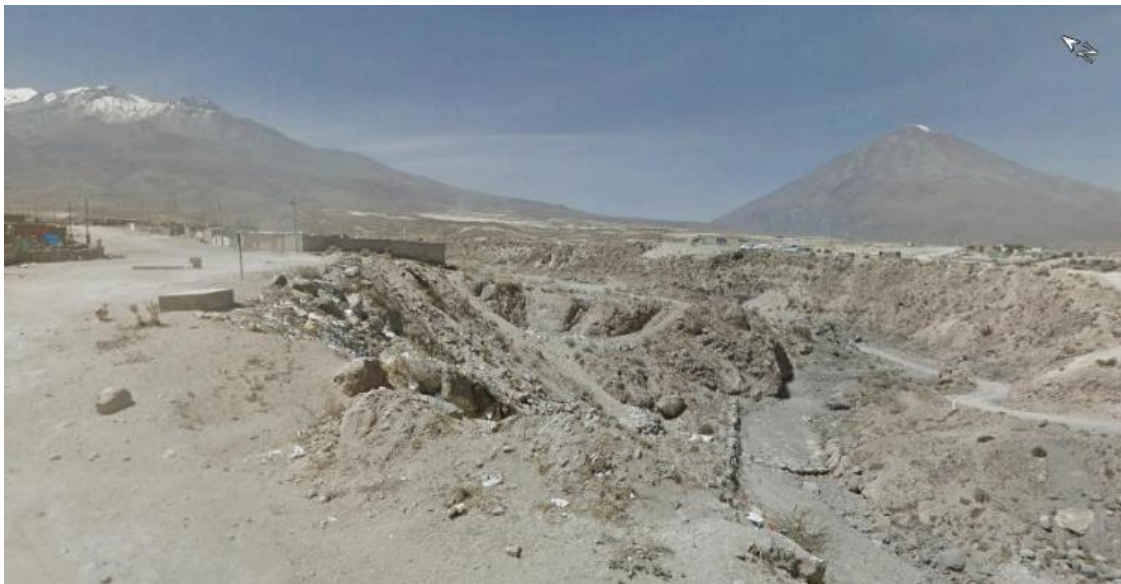
Figura 36. Zona de levantamiento del perfil E-E' de la Quebrada Azufral (sector Lari Lari y Tucos) (Coordenadas UTM WGS84 227948 E, 8195021 N).
