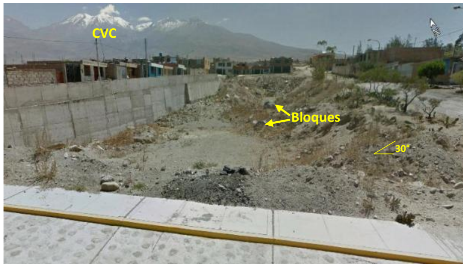
Figura 19. Quebrada tributaria con un muro de contención en la margen izquierda.
