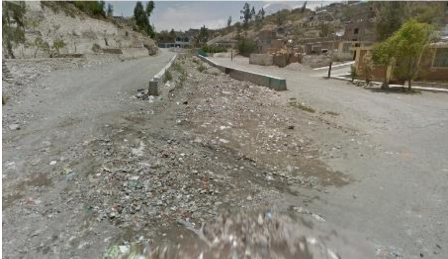
Figura 49. Puente en el sector alto, quebrada Pastoraíz.
