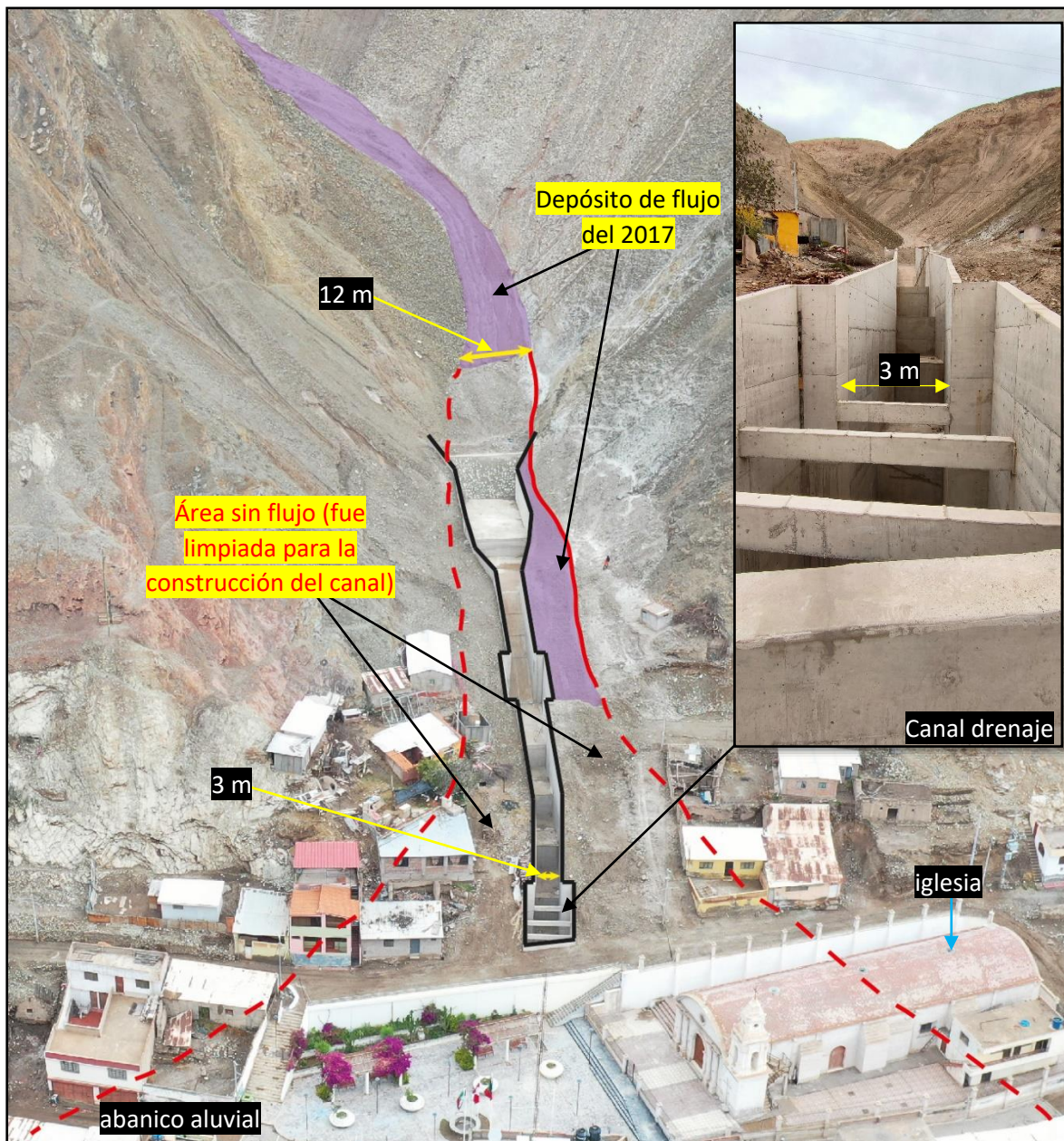
Figura 18. Canal drenaje La Capilla
