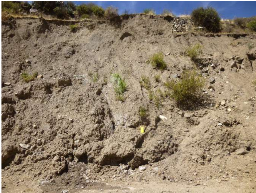
Foto 2.2: Vista del depósito del flujo de lodo en la margen derecha del río Tassa.
