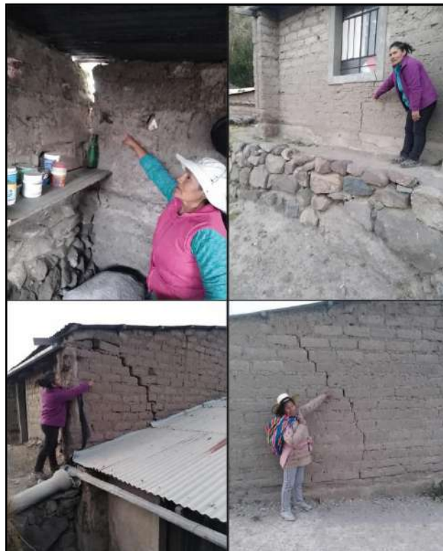
Figura 17. Viviendas en el sector Los Pinos en el centro poblado Anascapa.
