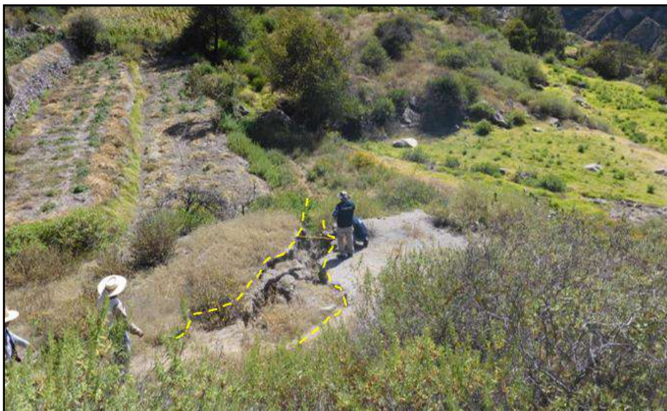
Figura 10. Agrietamientos G3, terrenos de cultivo de Anascapa, (coordenadas UTM WGS84: 301917E, 8183353N)
