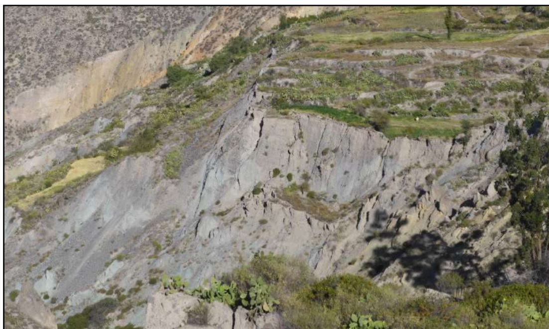
Figura 21. Derrumbes en la margen derecha de la quebrada Anascapa, (coordenadas UTM WGS84: 303094E, 8183114N)
